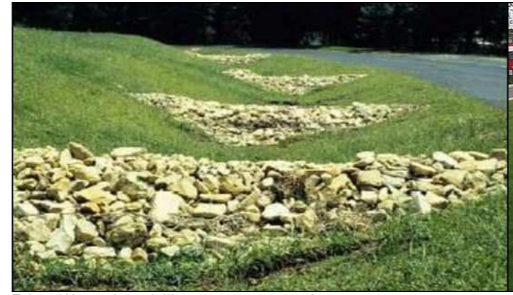
Esimerkki murskepadolla varustetusta avo-ojasta. Lähde: http://www.lakesuperiorstreams.org/stormwater/toolkit/swales.html
