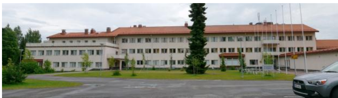
Kuva 7. Päärakennuksen harmoninen kokonaisilme muodostuu ikkunajasta ja materiaalien käytöstä (rappaus, tiiliosat, luonnonkivipintaiset sokkelit).
