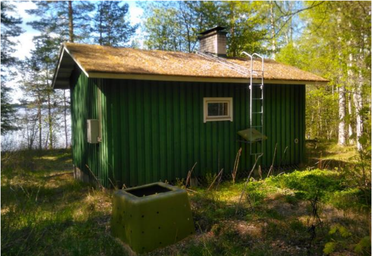
Rakennus takapihalta kuvattuna.
