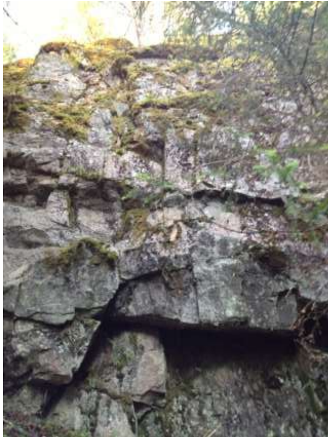
Kuva 39. Hytinvuoren jyrkkää kalliöseinämää
