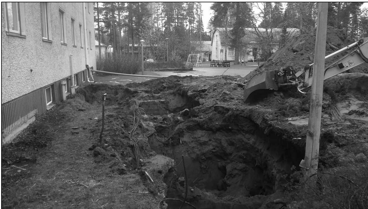
Kuva 1. Näkymä lämmitysöljysäiliöalueelle luoteesta.
