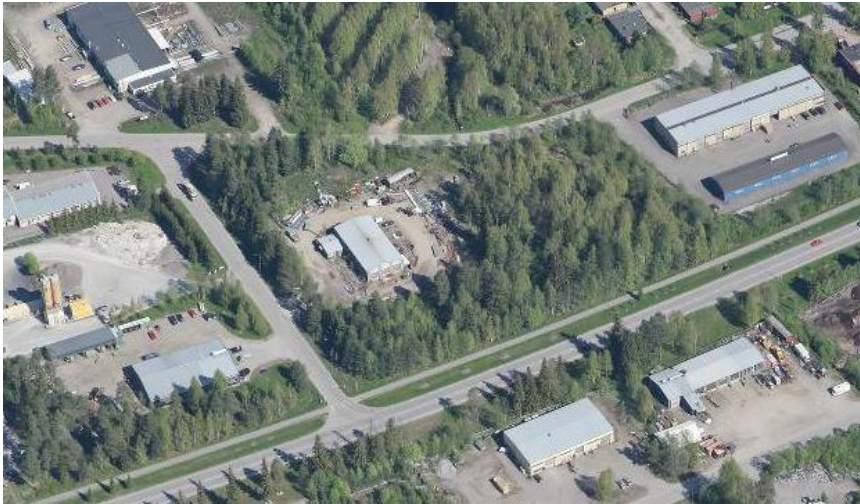
Kuva 3: Helmintie 1 ennen teollisuushallin saneerausta rautakaupaksi (kuva 2012).
