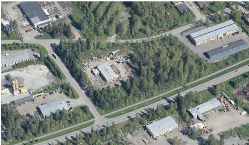
Kuva 4. Helmintie 1 ennen teollisuushallin saneerausta rautakaupaksi (kuva 2012).
