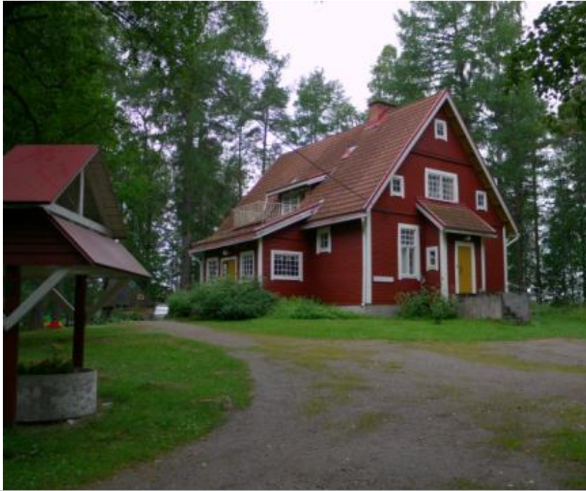
kuva vasemmalla: Rakennuksen julkisivu saapumissuuntaan (kaakkoon).
