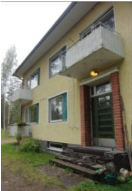
kuva: Asuntolasiiven julkisivua
