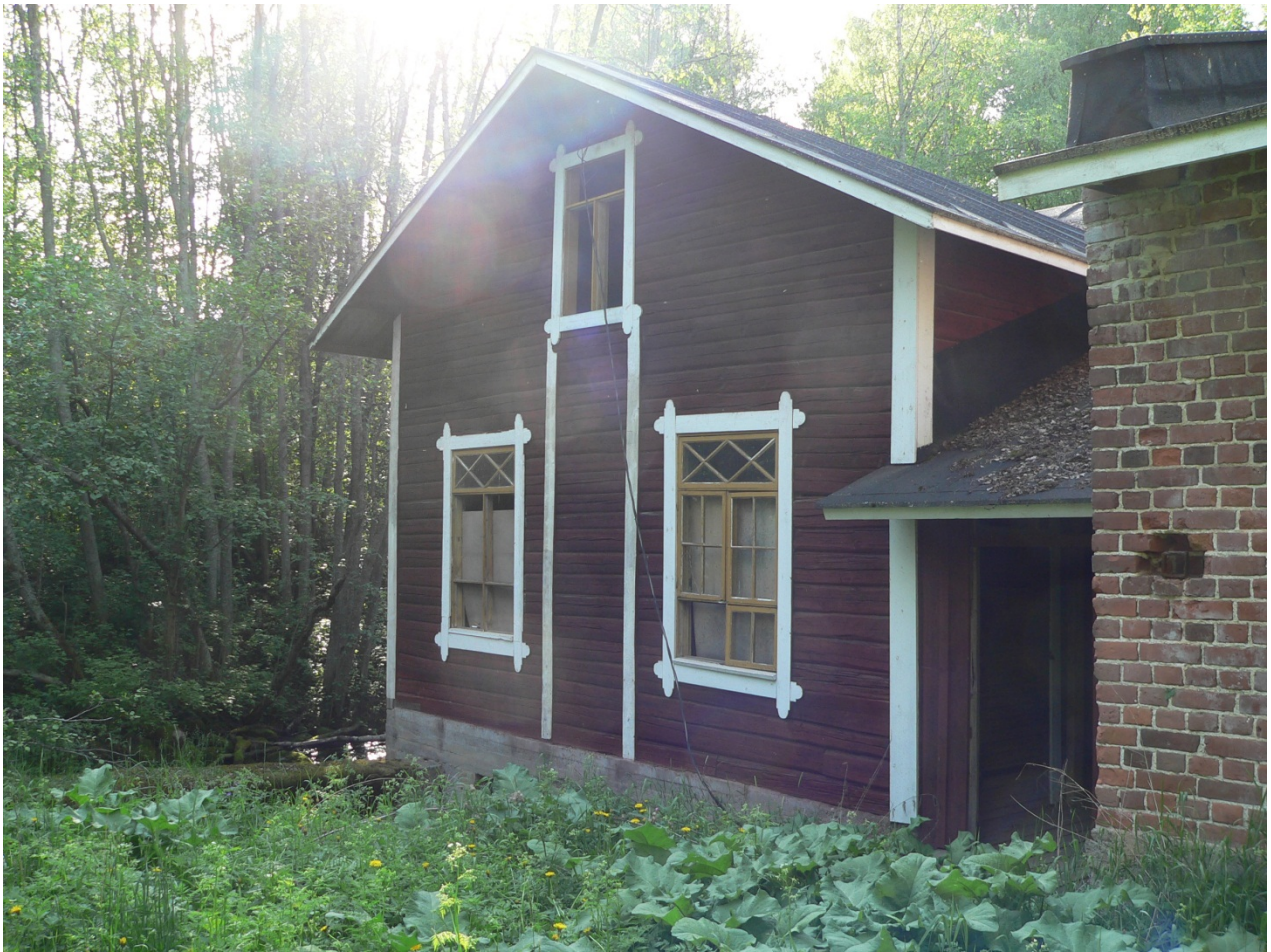
kuva: Mylly-, sähkö- ja sahalaituksen rakennuksen hirsiosan eteläpääty ja tiiliosan eteläsivua.
