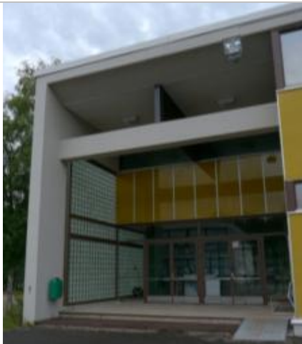
kuva: Rakennuksen pääjulkisivun toinen sisäänkäynti.
