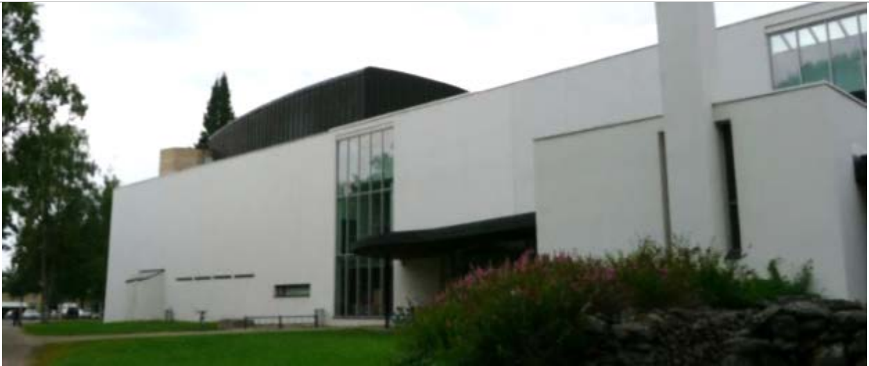
kuva: Rakennuksen itäinen sisäänkäynti
