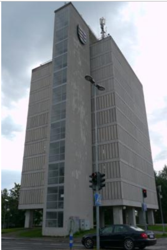
kuva: Rakennuksen julkisivu luoteeseen.
