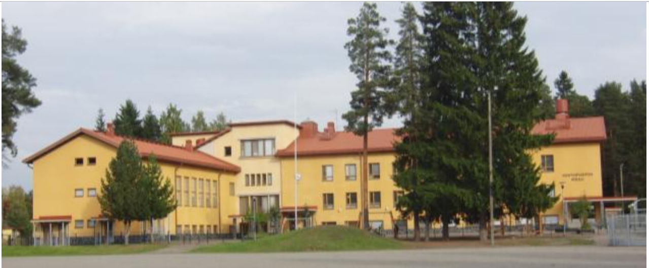
kuva: rakennuksen julkisivu länteen, urheilukentälle päin
