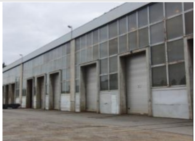
kuva: Konepajahallin koillisjulkisivua.
