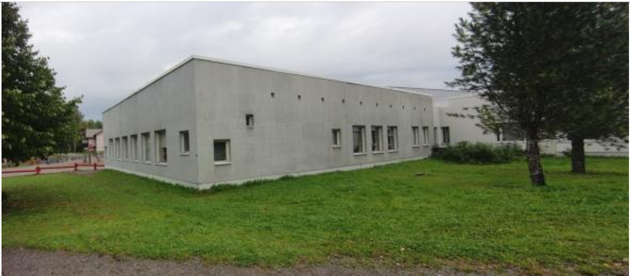
kuva: Rakennuksen ikkunasomittelua.
