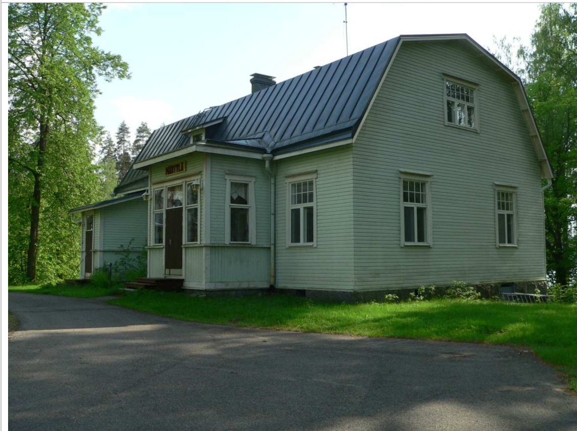
kuva: Mäntylä, entinen metsänhoitajan asuinrakennus vuodelta 1905 (kartalla rakennus 009). Rakennus on tyyliltään ja muodoiltaan hyvin samanlainen kuin samaan aikaan rakennettu johtajan asuinrakennus.
