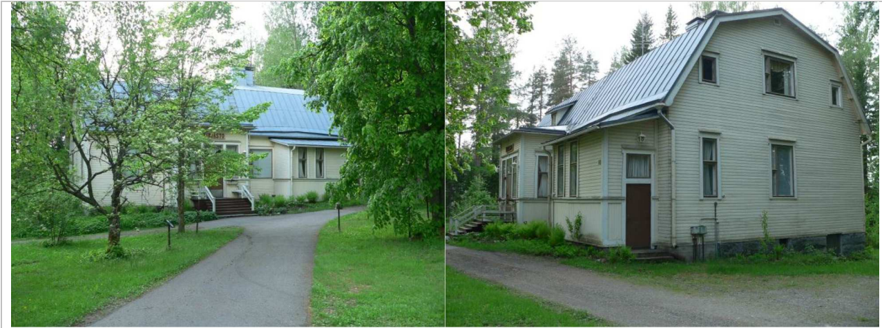
kuvat: Entinen johtajan asuinrakennus (vasemmalla päärakennuksen suunnasta idästä ja oikealla pohjoisesta päin nähtynä) toimi oppilaitoksen viimeisinä aikoina kirjastona. Rakennus on rakennettu vuonna 1905. (Kartalla rakennus 006)
