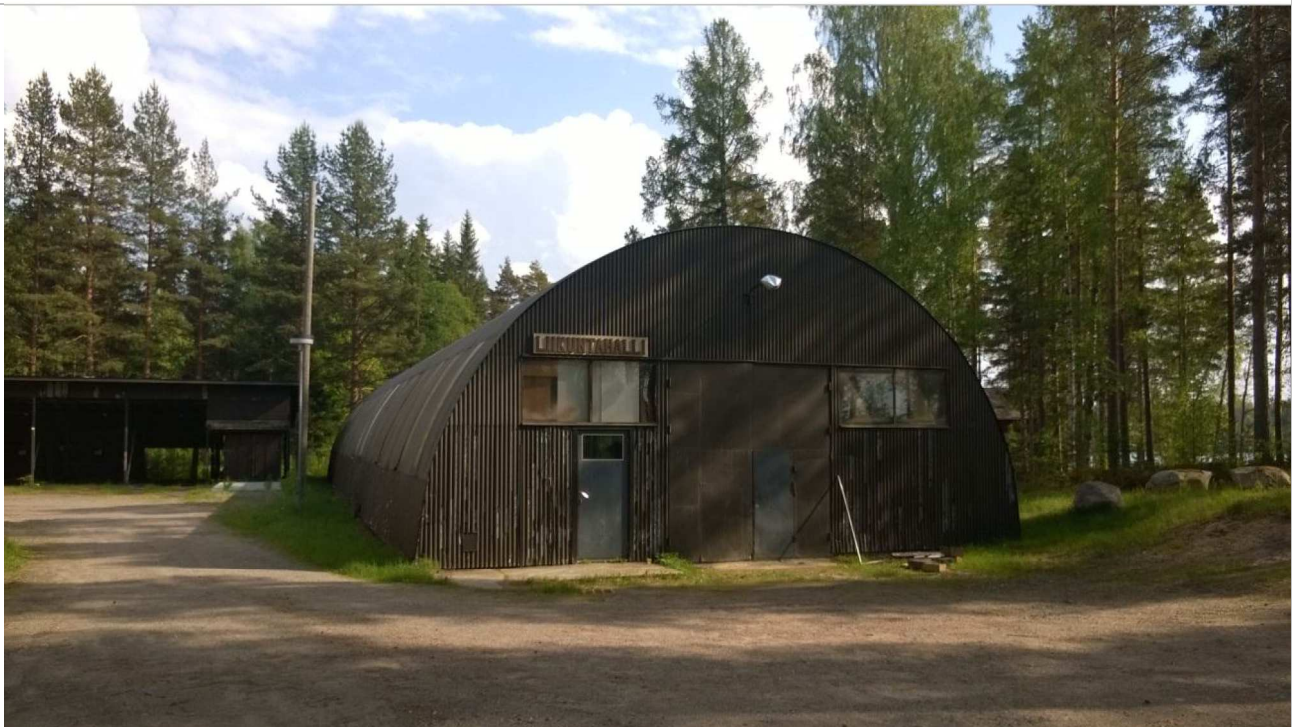
kuva: Liikuntahallin (kartalla kaakko-luode-suuntainen pitkä rakennus rakennusryhmässä D) pohjoinen sisäänkäyntipääty. Rakennus on huonokuntoinen. Taustalla näkyy kentän eteläreunaa rajaava suojakatos (kartalla edellisen itäpuolella rakennusryhmässä D).
