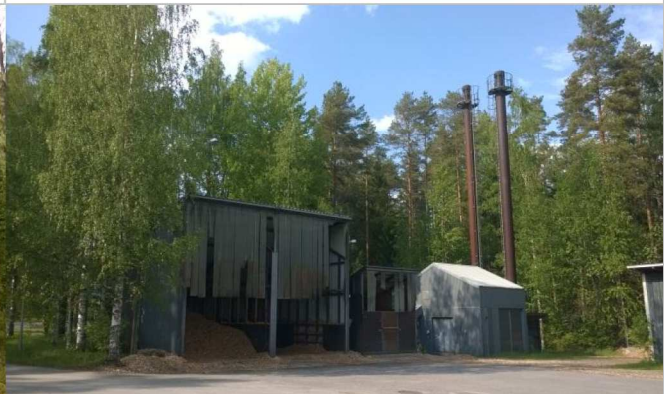
kuva: Lämpövoimala hakevarastointeen (itäisimmät rakennukset kartan rakennusryhmässä C)
