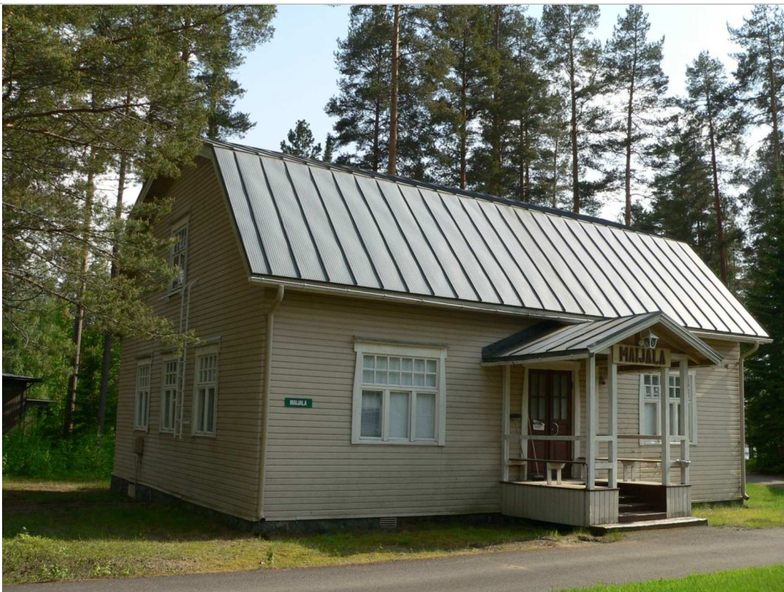
kuva: Maijalan (kartalla rakennus 017) ovat alueen ensimmäiset opiskelijat rakentaneet leipomoksi jäännöshirsistä. Rakennus korjattiin opetustiloiksi 1970-luvulla.
