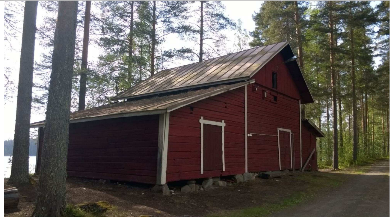
kuva: Karistusriihi kaakkoiskulmalta nähtynä. (kartalla rannanpuoleisin rakennus tien länsipuolella rakennusryhmässä D).
