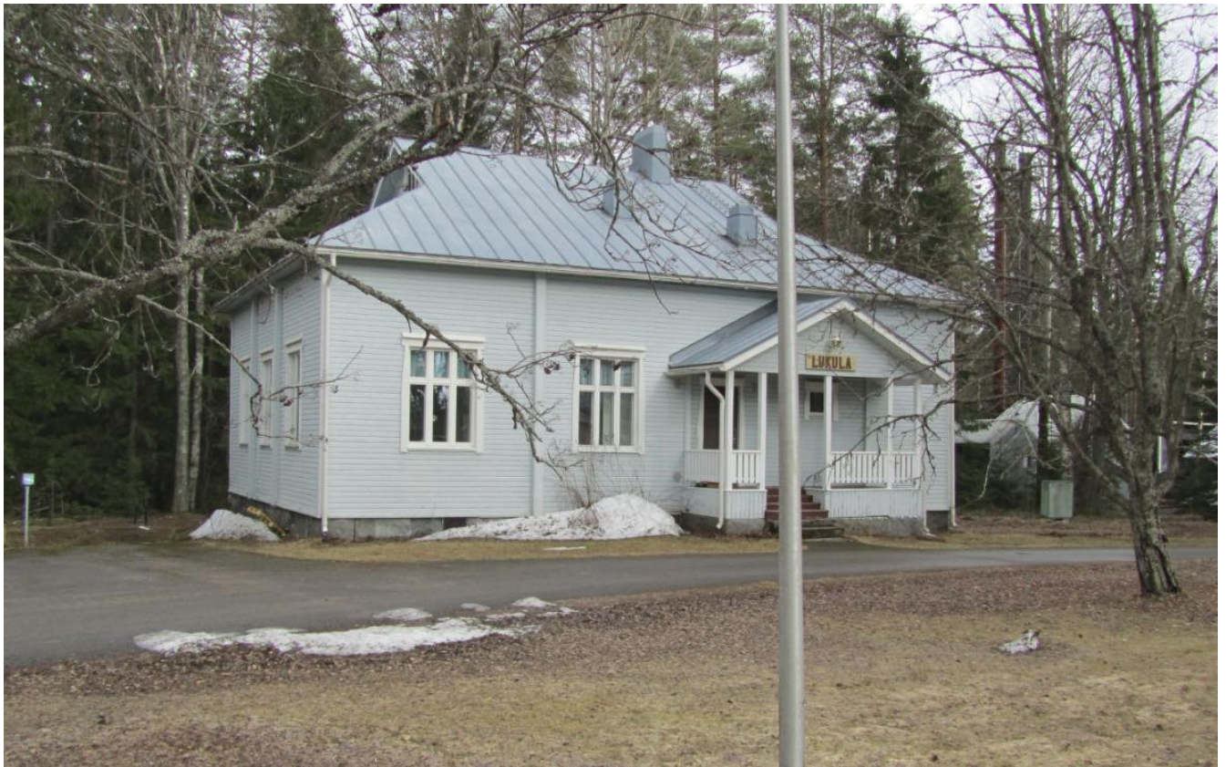
Kuva: Kuvassa käsityörakennus 1915. Nykyisin Lukula, toisessa päässä sijaitsi alun perin tallimiehen asunto, toisessa verstaas. Rakennus toimi asuntolana 90-luvulla.
