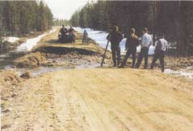
Kuva 52: Kevättulva on katkaissut tien.
