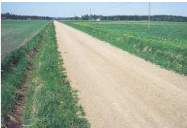
Kuva 14: Kuivatus, sivuojat Ojat ovat hyvässä kunnossa, arvosana 3 (arvosanat 3–0).
