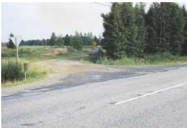
Kuva 40: Tiekunnan tulee poistaa irtokivet päällystetyltä liittymäalueelta.
