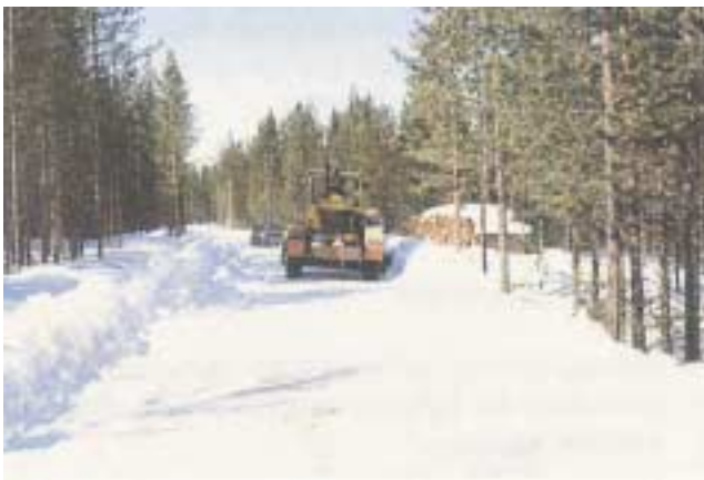
Kuva 35: Talvihöyläys parantaa tien liikennöitävyyttä.
