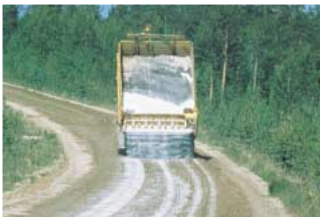
Kuva 29: Kalsiumkloridin levitystä kuorma-autosta.
