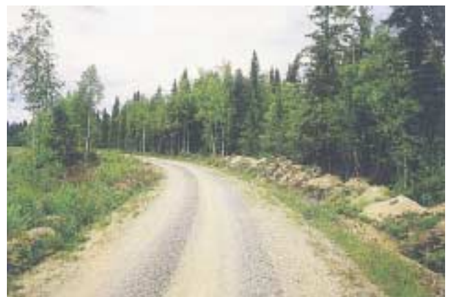
Kuva 48: Kaivumassat pitää levittää sivuojan taakse tai kuljettaa pois.
