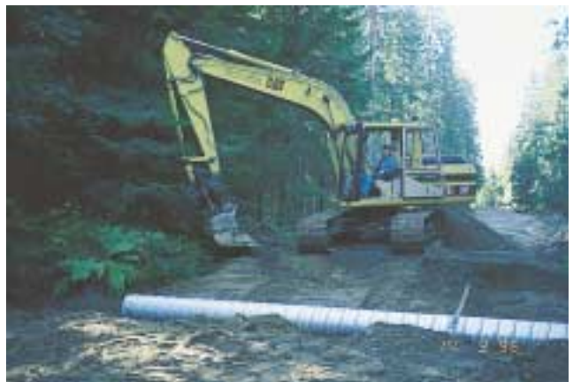
Kuva 49: Rummun uusiminen.
