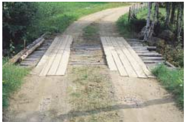
Kuva 55: Silta on kunnostuksen tarpeessa.
