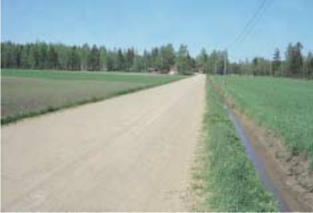
Kuva 10: Sivukaltevuudet Poikkileikkausmuoto on hyvä, arvosana 1 (arvosanat 1 tai 0).
