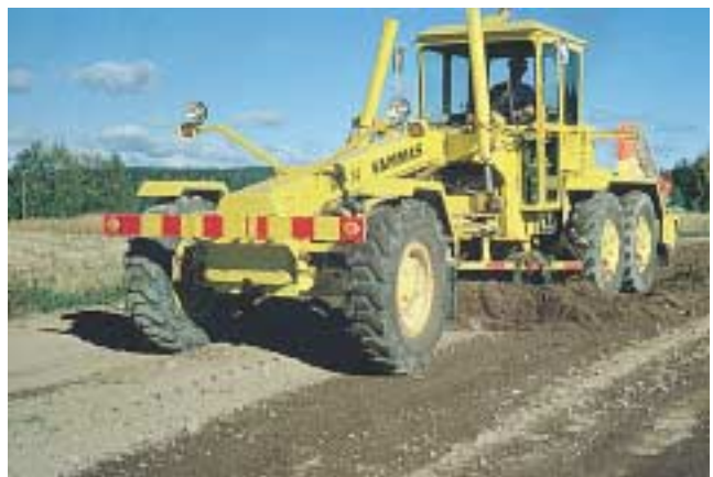
Kuva 24: Höyläys käynnissä.
