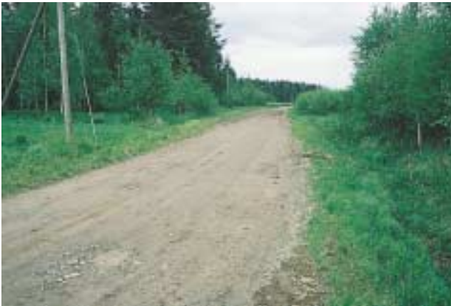
Kuva 12: Raiteet, kuopat, irtto- ja maakivet Tiessä on liikennettä ja kunnossapitoa haittaavia kuoppia, arvosana 1 (arvo- sanat 2–0).
