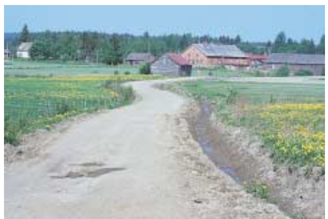
Kuva 9: Materiaalin määrä Kulutuskerrosmateriaalia on liian vähän, arvosana 0 (arvosanat 3–0).
