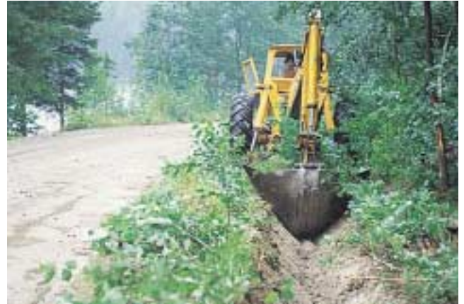
Kuva 47: Muotokauha ei yleensä sovi sivuojien kunnostamiseen, tiehen ei tule pintakuivatuksen kannalta oikeaa muotoa.
