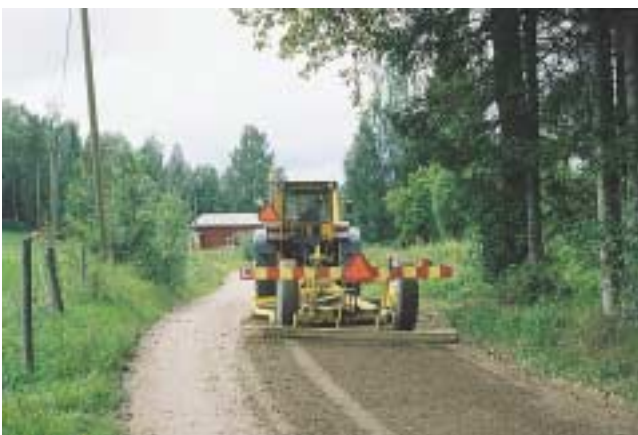
Kuva 28: Lanaus käynnissä.
