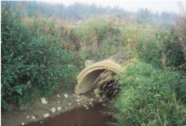
Kuva 16: Kuivatus, rummut Rumpu on välttävissä kunnossa (liettynyt), arvosana 1 (arvosanat 2–0).
