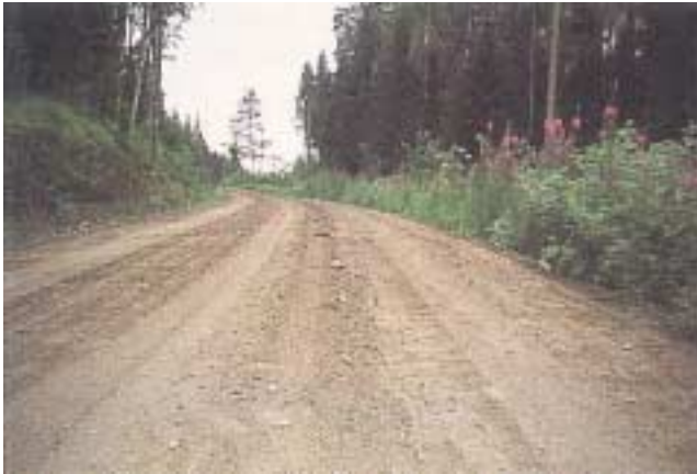
Kuva 27: Lanan nostamat kivet tulee poistaa tieltä heti lanauksen jälkeen.
