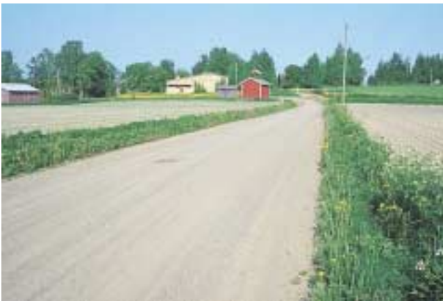
Kuva 6: Materiaalin laatu Kulutuskerrosmateriaalia on hyvää, arvosana 3 (arvosanat 3–0).
