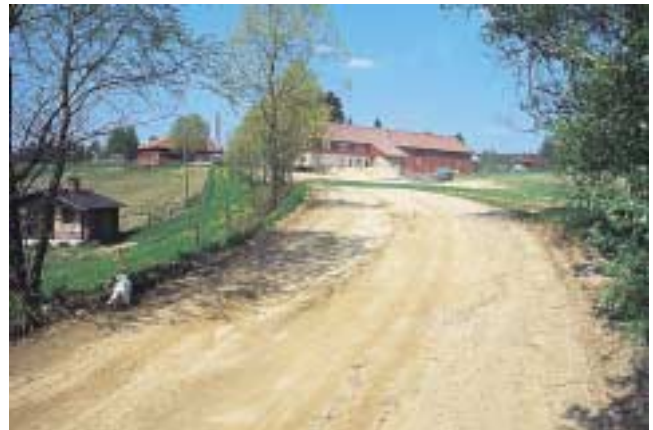
Kuva 13: Raiteet, kuopat, irtto- ja maakivet Tiessä on pahoja painaumia, arvosana- 0 (arvosanat 2–0).
