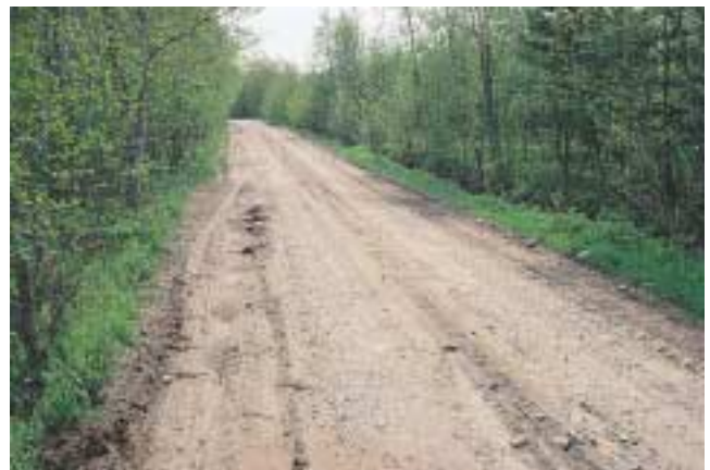
Kuva 15: Kuivatus, sivuojat Ojat ovat huonossa kunnossa, arvosana 0 (arvosanat 3–0).
