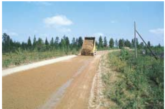
Kuva 45: Soran levitystä kuorma-autosta.
