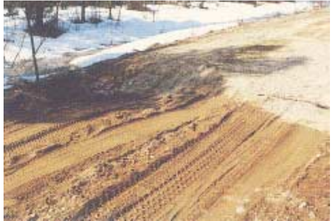
Kuva 53: Pahat routavauriot on korjattava mahdollisimman pian.
