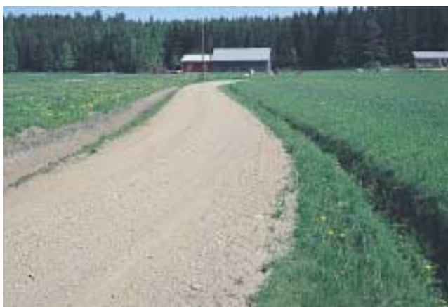
Kuva 8: Materiaalin määrä Kulutuskerrosmateriaalia on riittävästi, arvosana 3 (arvosanat 3–0).
