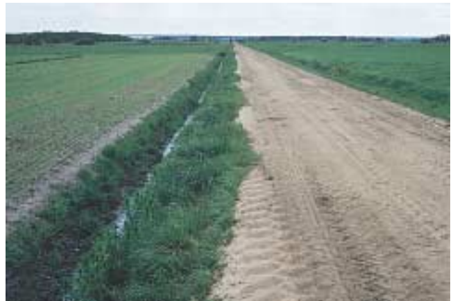
Kuva 7: Materiaalin laatu Kulutuskerrosmateriaali on liian tasarakeista, arvosana 0 (arvosanat 3–0).
