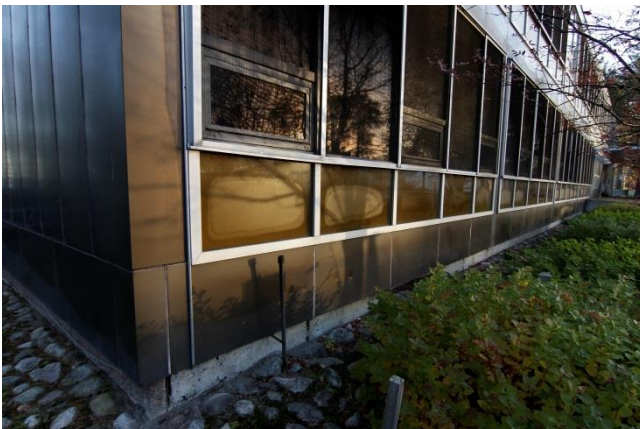
Kuvassa näkyy ikkunan alle lasituksen taakse kertynyttä kosteutta.
