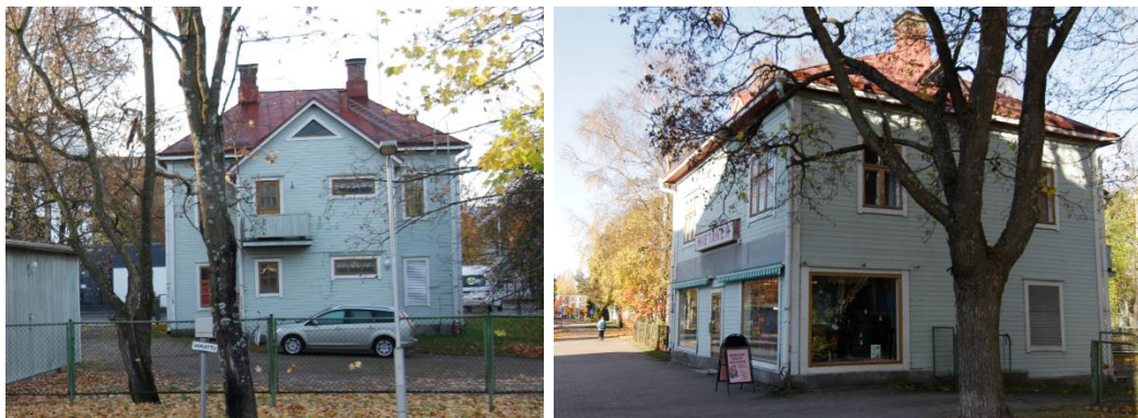
Kuva 9. Rakennus Sepposen liike- ja asuintaloa vastapäätä osoitteessa Savontie 7, jossa on toiminut vuosia Hietasen vaateliike.
