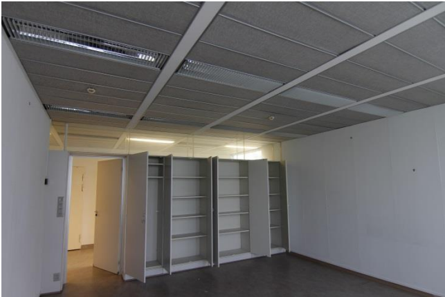
Tyypillinen toimistohuone. Katossa näkyy ikkunajäotuksen mukaiset mahdolliset väliseinän paikat. Valaistus on sisäkattoon upotettu. Toimistohuoneiden käytävän puoleisella seinällä on kaappeja.
