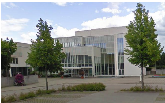
Kuva 4. Sipisen suunnittelema Imatran kulttuurikeskus sijaitsee kaupungintaloa vastapäätä. Se on valmistunut 1986 ja julkisivun abstrakti valkoisuus on tyypillistä Sipisen myöhäisemmälle arkkitehtuurille. Kuvalähde: Google Maps, Street View Jul 2009. Lainattu 14.11.2016.
