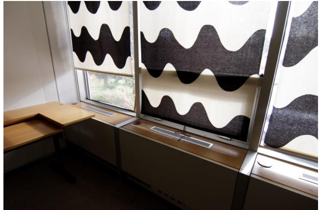
Ikkunoiden alla on kotelointi, joka piilottaa talotekniikan.
