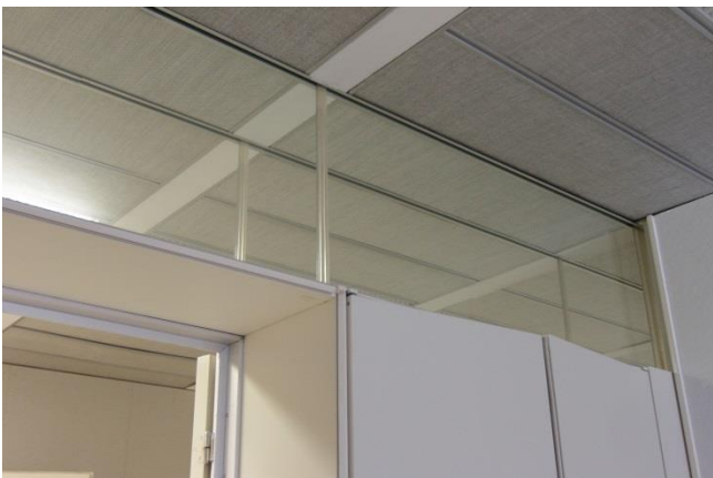
Käytävän ja toimistohuoneiden välissä on kaappeja, joiden yllä on käytävään luonnonvaloa päästävä ikkuna.
