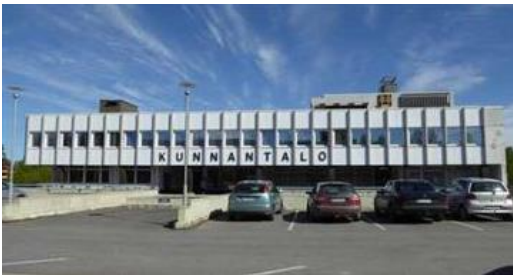
Kuva 1. Mäntyharjun kunnantalo on valmistunut vuonna 1966. Hallinto- ja liikekortteli on heijastuma 60-luvun keskustasuunnittelusta ja aikaa leimanneesta kaupungistumisesta. Kuvälähde Etelä-Savon kulttuuriperintötietokanta, http://www.esku.fi/asp/kohde_det.aspx?KOHDE_ID=22704 .
