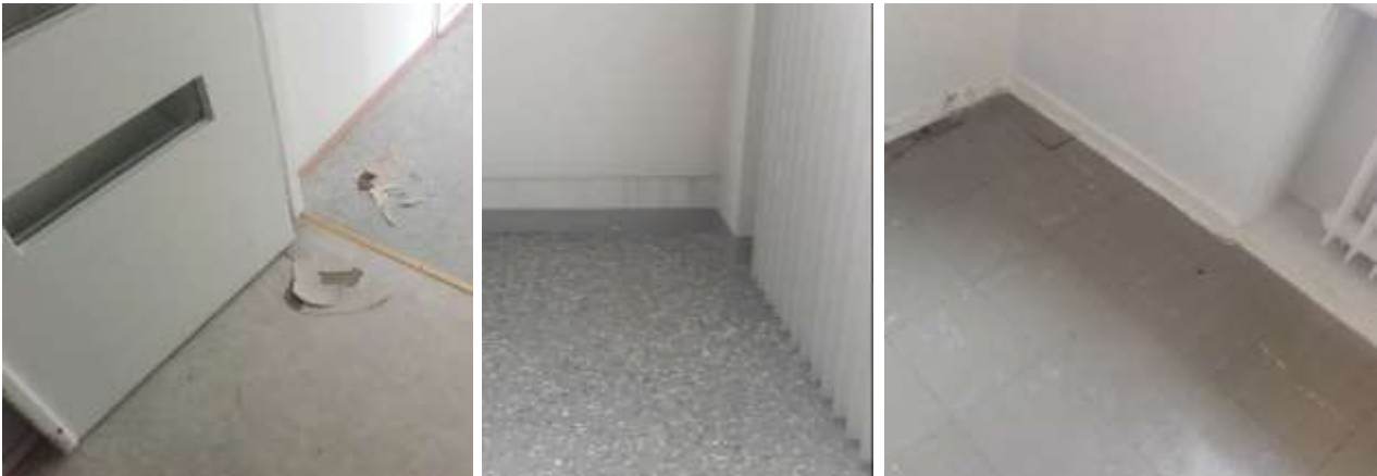
Kuva 57. Vasemmalla keskeiskäytävän muovimattoa ja ikkunallinen väliovi. Keskellä ja oikealla asuinhuoneiden lattioiden erilaisia linoleum-päällysteitä.
