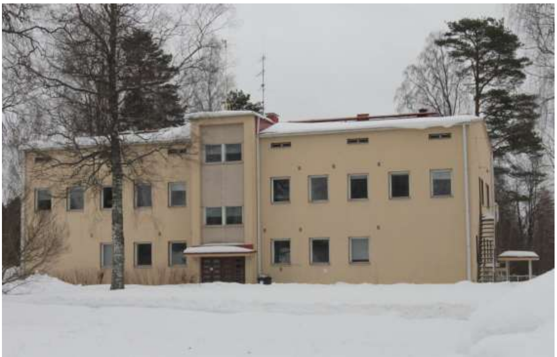
Kuva 9. Entisen mielisairaalan lounaan puoleinen pääjulkisivu. Rakennus on tällä hetkellä talvisin tyhjiällä.
