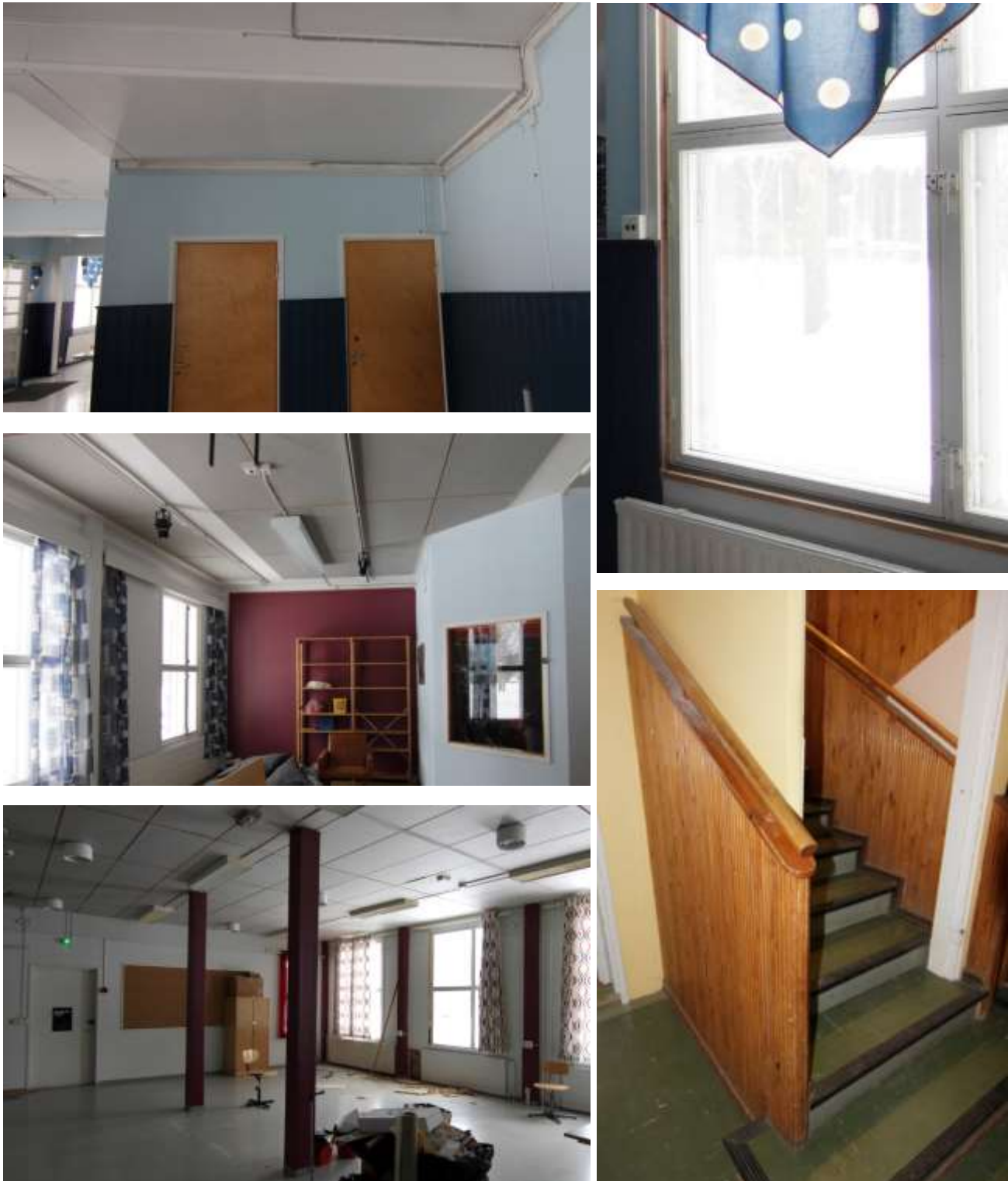
Kuva 42. Rakennuksen länsipäädyn pintamateriaaleja on uusittu eri aikoina, eikä alkuperäisestä sisustuksesta ole säilynyt viitteitä. Yläkuvassa kellarin ja varaston ovat, keskikuvassa näkyy hyvin uusittu sisäkatto akustiikkalevyineen. Alakuvassa kokoontumistila rakennuksen keskeltä. Yllä oikealla luultavasti 1900-luvun puolivälistä peräisin olevien ikkunoiden heloituksen yksityiskohtia. Alla ullakolle johtavat portaat. Siroissa kaiteissa on käytetty sormipaneelia.
