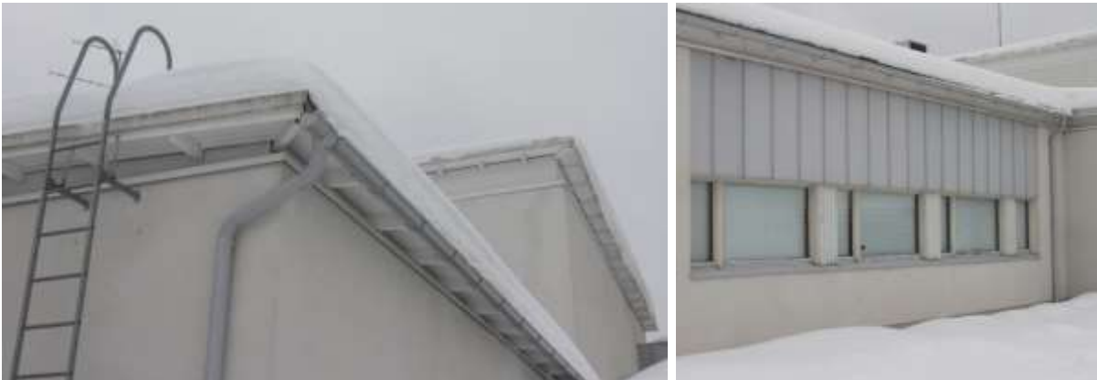
Kuva 80. Vasemmalla koulun lounaisjulkisivulla näkyy hyvin laajennuksen yhteydessä muutetut kattorakenteet. Taustan korkeampi rakennusosa on liikuntahalli. Oikealla lounaisjulkisivusta hahmottuu vielä alkuperäisen osan ikkunajako.
