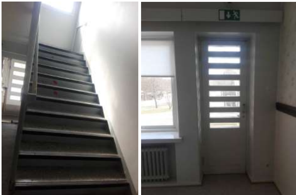
Kuva 56. Vasemmalla porraskäytävä yläkertaan. Oikealla varapoistumistien ovi yläkerrassa. Ikkunalaudan alla näkyy alkuperäinen lämpöpatteri. Kuvälähde: Piekämäen kaupunki, Tmi Heikki Vihavainen.
