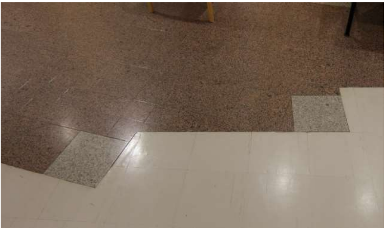
Kuva 109. Pääaulan lattiamateriaalina on käytetty graniittia, joka vaihtuu virasto-osassa vinyylivartilaatoiksi.
