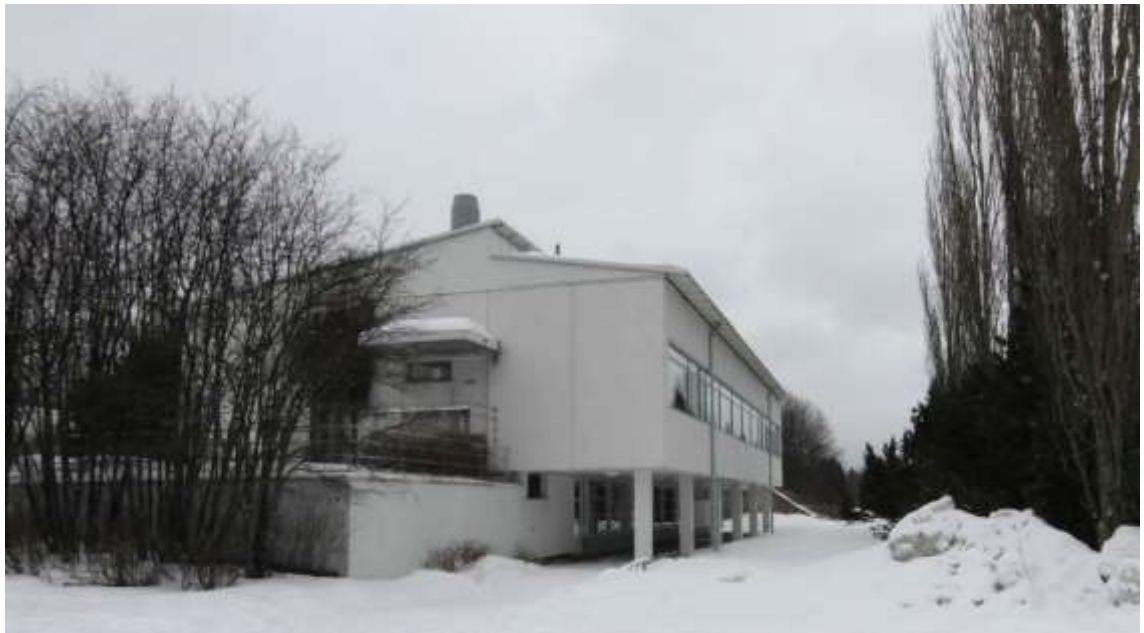
Kuva 15. Seurakuntakeskuksen vanhan osan kaakkoispääty ja alarinteen puoleinen arkadikäytävä.
