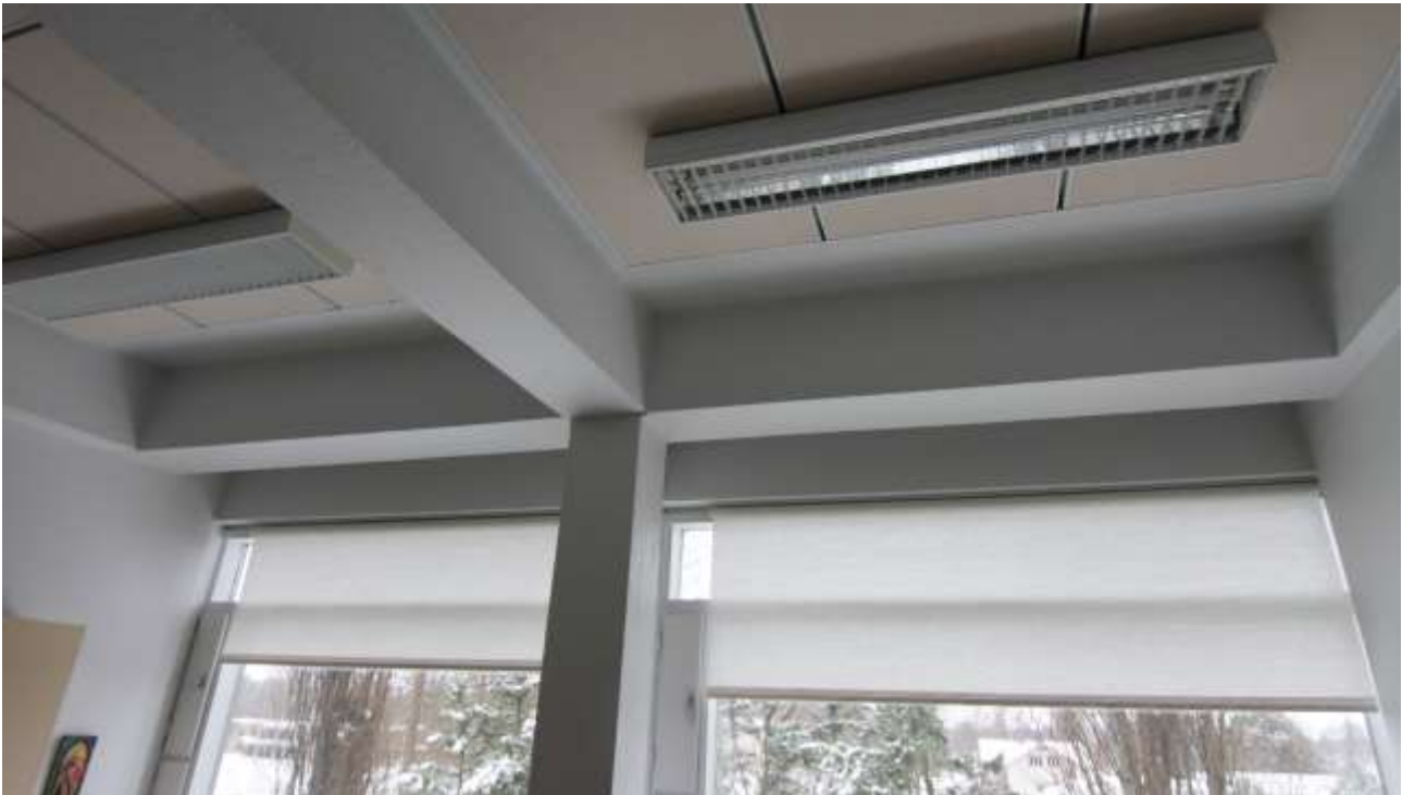
Kuva 71. Toimistuhuoneiden mitoitus noudattaa moduulijakoa huoneiden ollessa kahden moduulin levyisiä kuten kuvassa tai pienempiä yhden moduulin levyisiä huoneita. Rakennuksen kantava pilari-palkki -rakente näkyy hienosti myös toimistuhuoneissa. Ikkunat ovat alkuperäiset.
