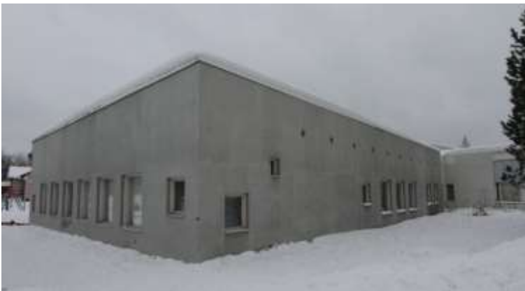
Kuva 81. Alkuperäisosan luoteispäädyn laajennus eroaa koordinaatistoltaan hieman alkuperäisestä osasta.
