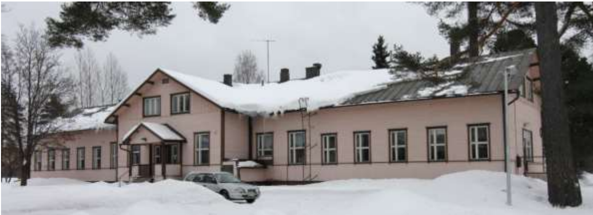
Kuva 32. Entisen kunnalliskodin luoteisjulkisivu.
