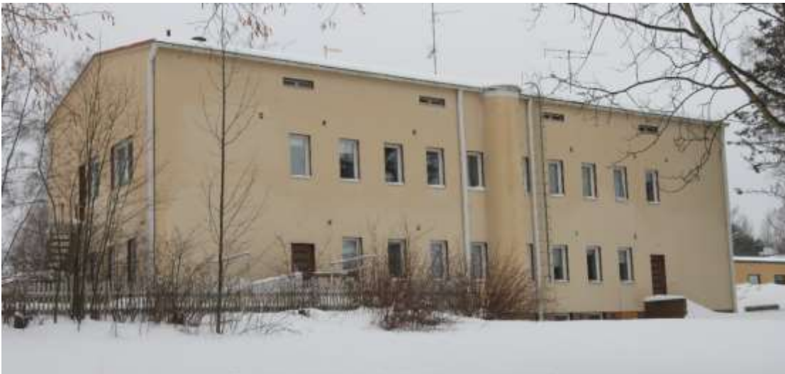
Kuva 48. Entisen kunnalliskodin mielisairaalaosaston kaakkois- ja koillisjulkisivut.
