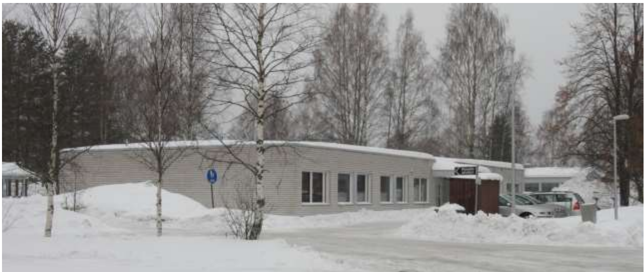
Kuva 18. Maaselän päiväkoti on matala, tasakattoinen laatikkomainen rakennus vuodelta 1976.
