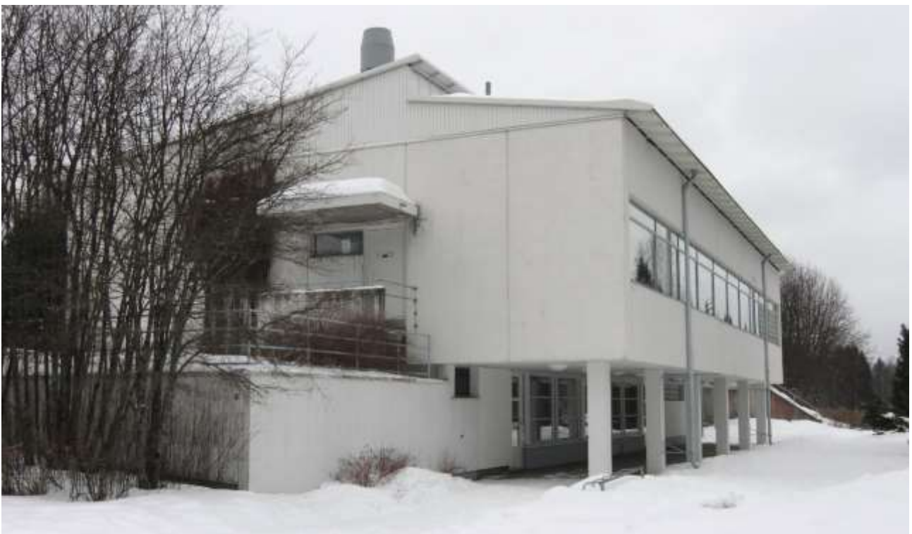
Kuva 63. Seurakuntakeskuksen alkuperäinen osa on varsin yksinkertainen laatikkomainen rakennusmassa, joka on alarinteen puolelta pilareiden varassa.
