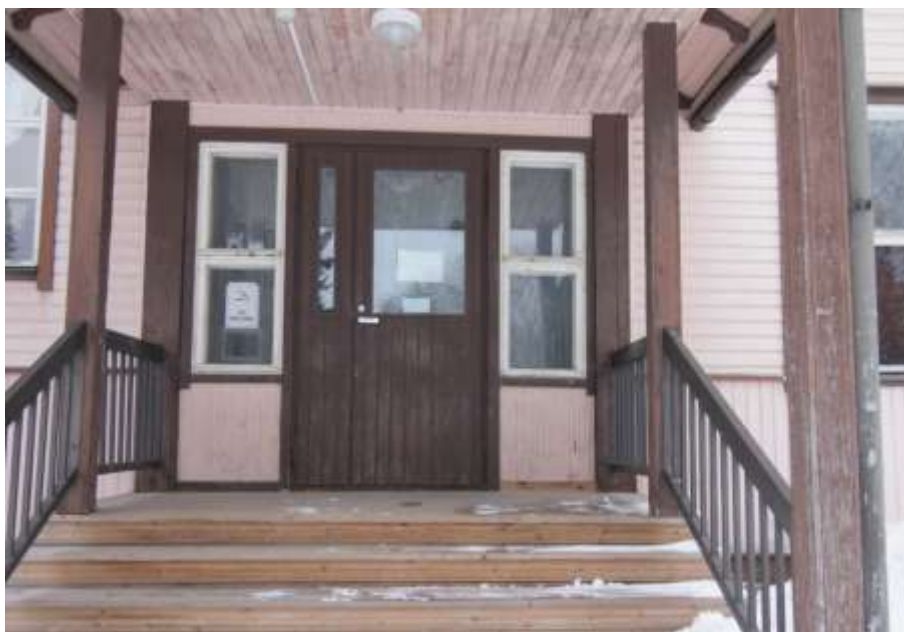
Kuva 37. Myös kaakkoisjulkisivun kuistin takaseinässä on sormipaneeli. Pilasterit ovat yksinkertaisemmat kuin luoteisjulkisivussa. Ovet ovat 1900-luvun loppupuolelta.
