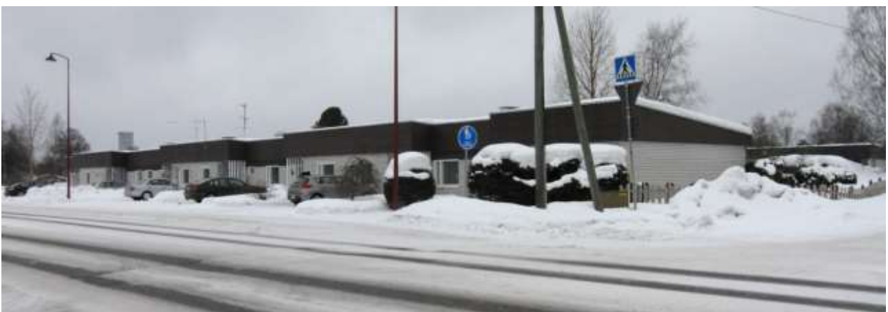
Kuva 13. Vilhulantien varren kapearunkoinen, porrastettu rivitalo 1960- ja 1970-lukujen vaihteesta. Rakennus sijaitsee tarkastelualueen ulkopuolella Vilhulantien länsipuolella.
