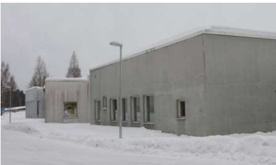
Kuva 82. Uudisosan koillisjulkisivu. Rakennuksen massoittelu tuo esille sisätilojen eri tyyppiset toiminnot. Rappauksen sävy vaihtelee rakennusosittain.
