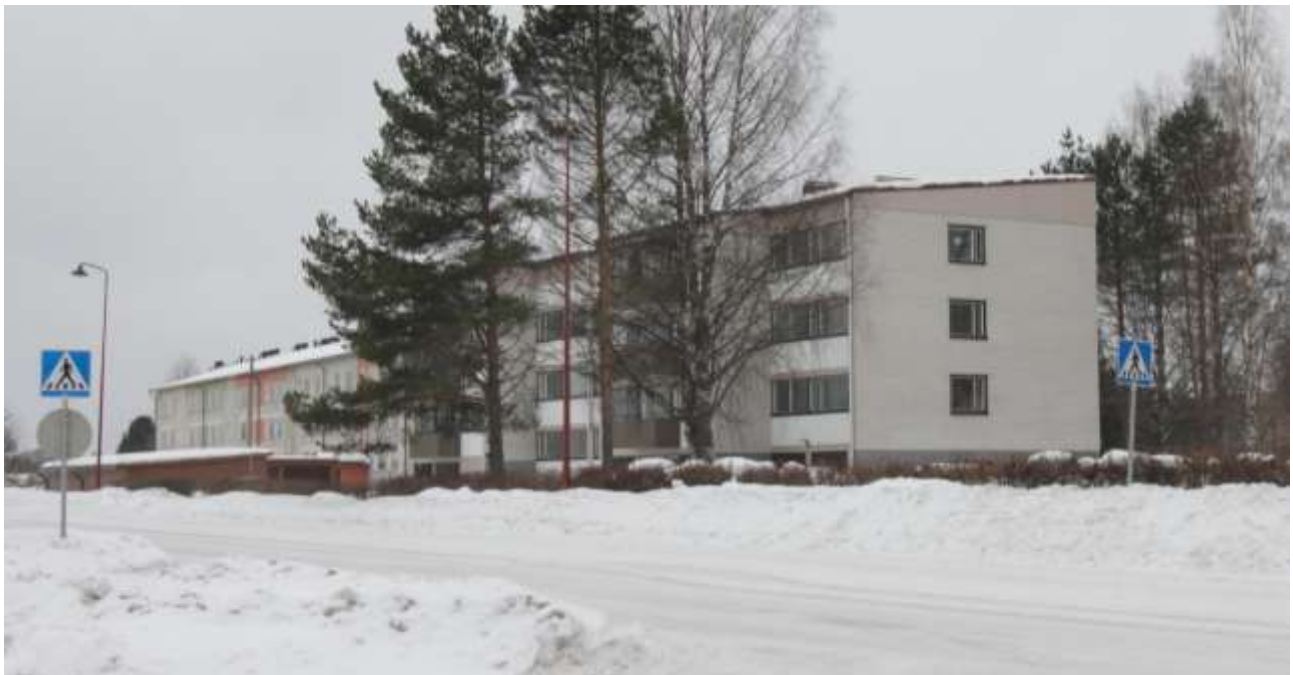
Kuva 25. 1970-luvun kerrostaloja Vihulantien ja tarkastelualueen itäpuolella, vastapäätä Kanttilaa.
