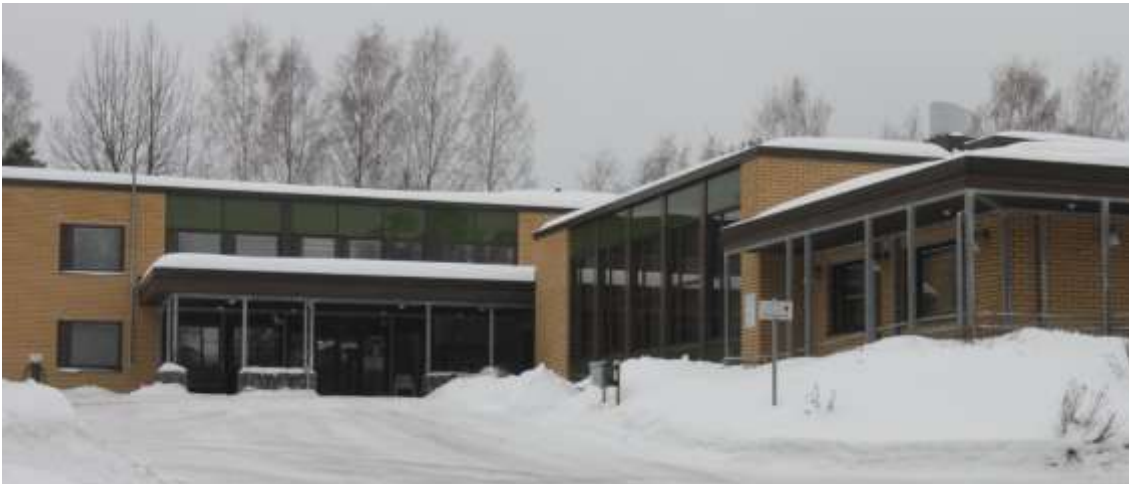
Kuva 19. Vanhainkodin sisääntulopiha Seunalantien puolella. Pääsisäänkäynnin ilmeeseen tuo arvokkuutta isot lasipinnat.
