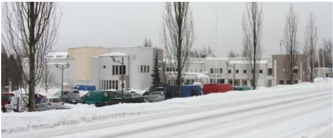
Kuva 28. Kanttilan julkisivu Vilhulantielle päin. Rakennus sijoittuu jyrkkään rinteeseen ja tori- aukea Kanttilan edustalla on selvästi Vilhulantietä alempana. Tori jää selvästi katualueesta ir- ralliseksi elementiksi.
