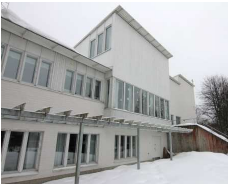
Kuva 65. Seurakuntakeskuksen uudisosan alarinteen puoleista julkisivua rytmittää ikkuna-aukotukset. Ulkonevaan rakennusmassaan sijoittuu seurakuntakeskuksen pääaulaan avautuva kahvio. Nauhaikkuna on selvä viittaus alkuperäisen osan nauhaikkunoihin.
