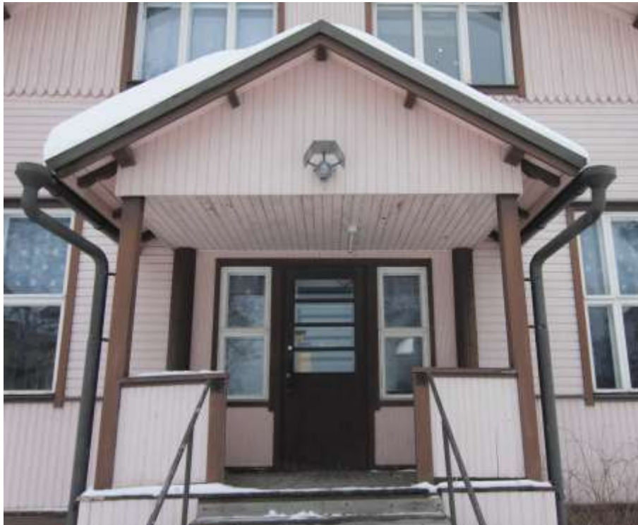
Kuva 36. Luoteisjulkisivun sisäänkäynti. Kuistin takaseinässä ja ovesa on käytetty sormipaneelia. Ovi ja ikkunat ovat ehkä 1950-luvulta.
