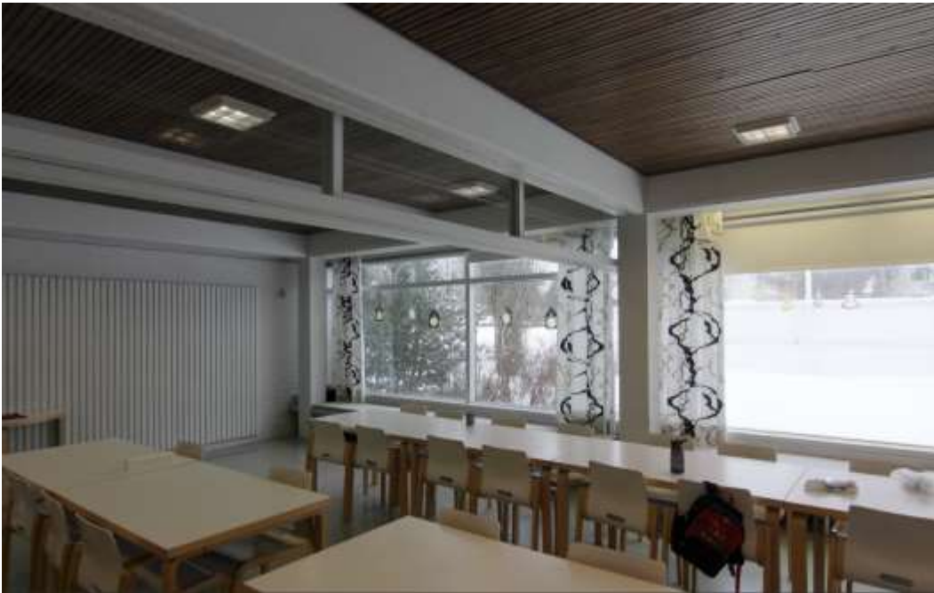
Kuva 69. Seurakuntakeskuksen alkuperäisen osan seurakuntasali. Irtokalustus ei ole alkuperäistä, muuten sisustuksen yksityiskohdat ovat säilyneet hyvin. Katon tumma puuverhous korostaa pilareita ja palkkeja.
