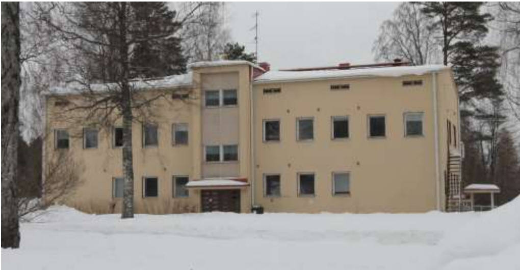
Kuva 47. Entisen kunnalliskodin mielisairaalaosaston lounaisjulkisivu.
