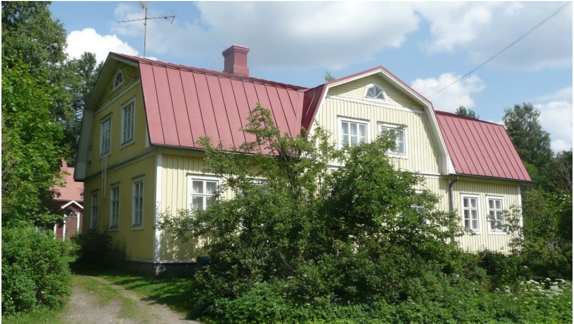
KUVA: Herttuantalo. Taitekattoinen, kaksikerroksinen rakennus on 1900-luvun alusta.
