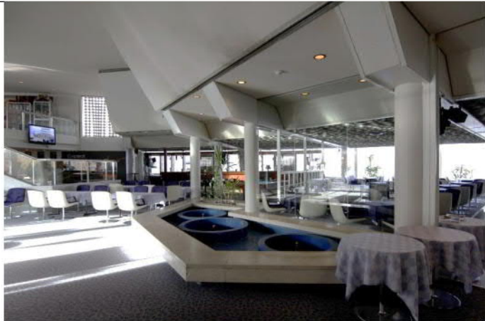
Sisääntulo aulan erottaa ravintolasalista suihkulähde, jossa tällä hetkellä ei ole vettä. Vain sisäkatto on toteutettu levytyksillä. Kantava rakenne on suorakulmainen levytyksen takana. Kattoa kannattavat massiiviset palkit on levytetty.
