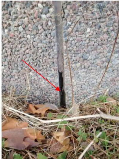
Kuvat 3 ja 4. Perusmuurilevyjen saumoissa olevia reikiä ja epätiiveyskohtia, joista suora yhteys mineraalivillaan.
