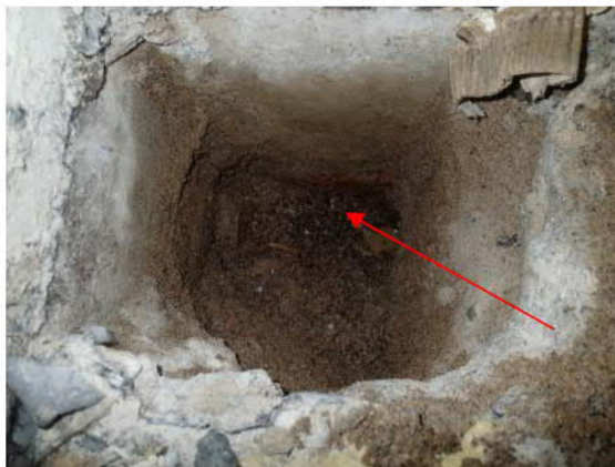
Kuvat 3 ja 4. Perusmuurilevyjen saumoissa olevia reikiä ja epätiiveyskohtia, joista suora yhteys mineraalivillaan.
