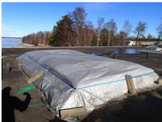
Kuva 25. Pressuilla peitelty kattoikkuna. Kuva 26. Vesikatteella seisovaa vettä jopa 50mm vahvuisina kerroksina.
