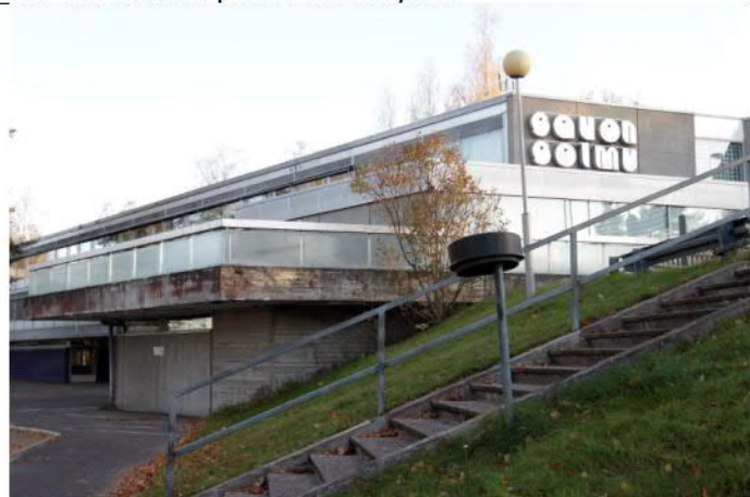
Pääsisäänkäyntiin liittyvä terassi.
