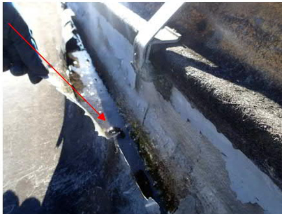
Kuva 23. Kattoikkunoiden ja yläpohjan Kuva 24. Yläpohjan kattoikkunassa näliitokset epätiiviitä. Vesi on päässyt ra-kyviä vesivuotoja. kenteiden sisään.
