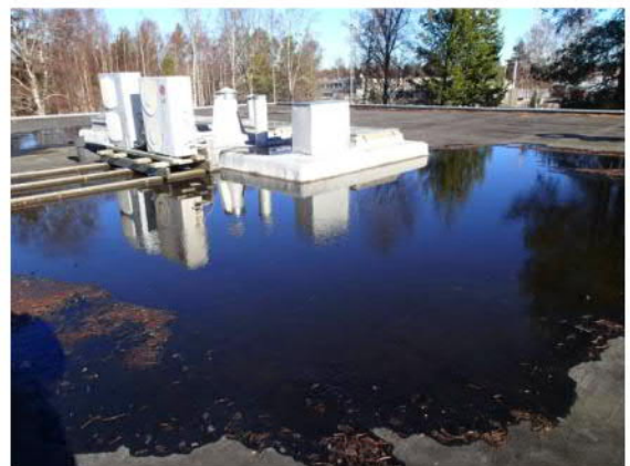
Kuva 25. Pressuilla peitelty kattoikkuna. Kuva 26. Vesikatteella seisovaa vettä jopa 50mm vahvuisina kerroksina.
