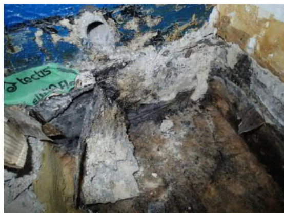
Kuva 19. Kellarin alapohjan tekniikkakanaalissa olevaa lahoa puuta sekä levyä. Kuva 20. Arkiston alapohjassa havaittavissa kosteaa mineraalivillaa sekä haurastunutta pikeä.
