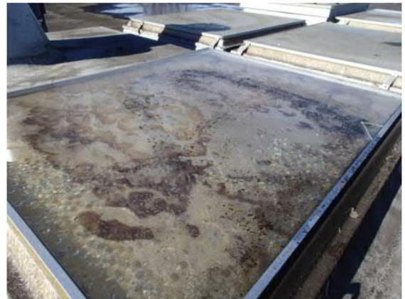
Kuva 23. Kattoikkunoiden ja yläpohjan Kuva 24. Yläpohjan kattoikkunassa näliitokset epätiiviitä. Vesi on päässyt ra-kyviä vesivuotoja. kenteiden sisään.
