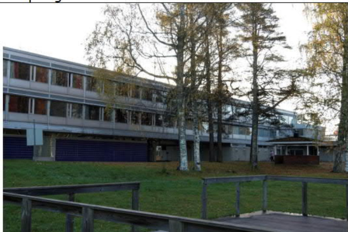
Hotellin edustalla sijaitsee huonokuntainen tanssilava ja hotellirakennuksen tyyliin sopimaton huvimaja. Kuvassa alkuperäisen huoneisto-osan julkisivu lounaaseen.
