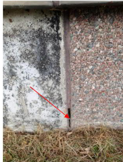
Kuvat 3 ja 4. Perusmuurilevyjen saumoissa olevia reikiä ja epätiiveyskohtia, joista suora yhteys mineraalivillaan.
