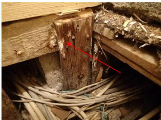
Kuva 19. Kellarin alapohjan tekniikkakanaalissa olevaa lahoa puuta sekä levyä. Kuva 20. Arkiston alapohjassa havaittavissa kosteaa mineraalivillaa sekä haurastunutta pikeä.
