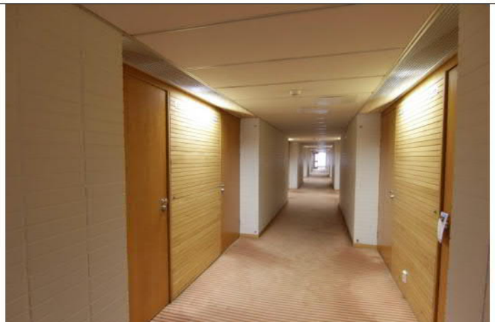
Uudisosan käytävä on väriykseltään rauhallisempi. Valaistus on upotettu alas laskettuun kattoon.
