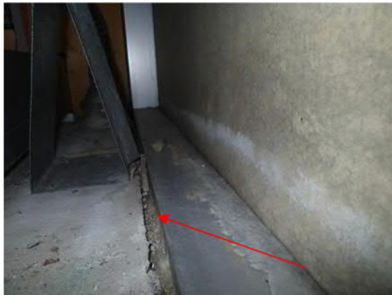
Kuva 21. Välipohjan ja ulkoseinän ikku-naelementin välissä oleva mineraalivilla-naelementin välissä oleva kovalevy. Ko-kaista. Kuva 22. Välipohjan ja ulkoseinän ikku-naelementin välissä oleva kovalevy. Kovalevyssä havaittavissa kosteusjälkiä.
