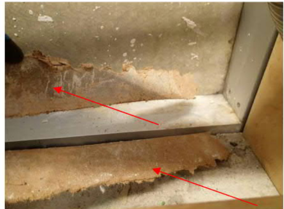
Kuva 21. Välipohjan ja ulkoseinän ikku-naelementin välissä oleva mineraalivilla-naelementin välissä oleva kovalevy. Ko-kaista. Kuva 22. Välipohjan ja ulkoseinän ikku-naelementin välissä oleva kovalevy. Kovalevyssä havaittavissa kosteusjälkiä.
