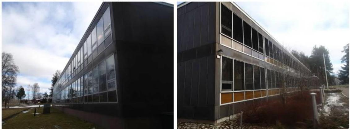
Kuvat 1 ja 2. Takapihalla oleva nurmikko on kiinni perusmuurissa ja etupihalla on syvennykset sekä kasvillisuutta lähellä ulkoseinää.
