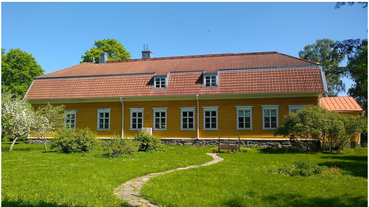
Kuva 4. Iso-Pappilan päärakennus, takapiha
