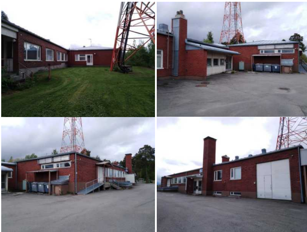
Kuva 5. Toimistorakennus osoitteessa Kukkaroniementie 4.
