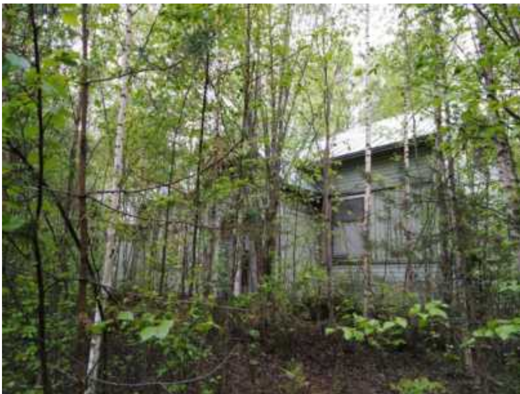
Kuva 30. Ratapiirin toimistorakennus ulkoapäin talousrakennuksesta päin katsottuna.
