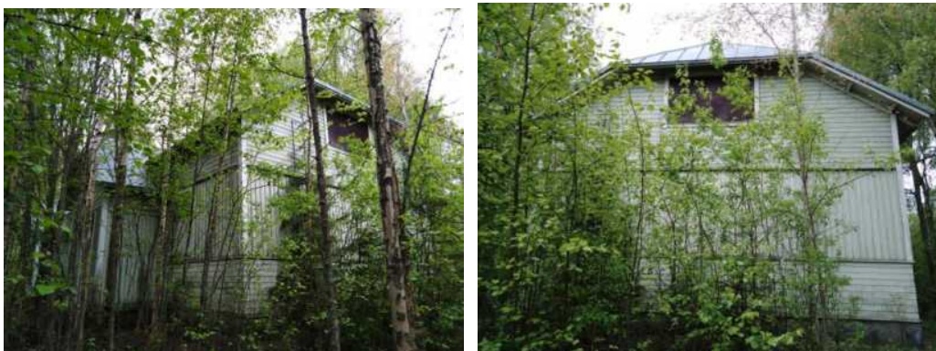
Kuva 31. Toimistorakennuksen julkisivuja koillisesta ja lounaasta.
