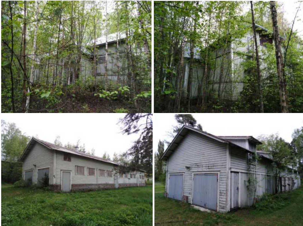
Kuva 8. Suojelutarveselvitettävät ratapiirin toimistorakennus ja sen talousrakennus.
