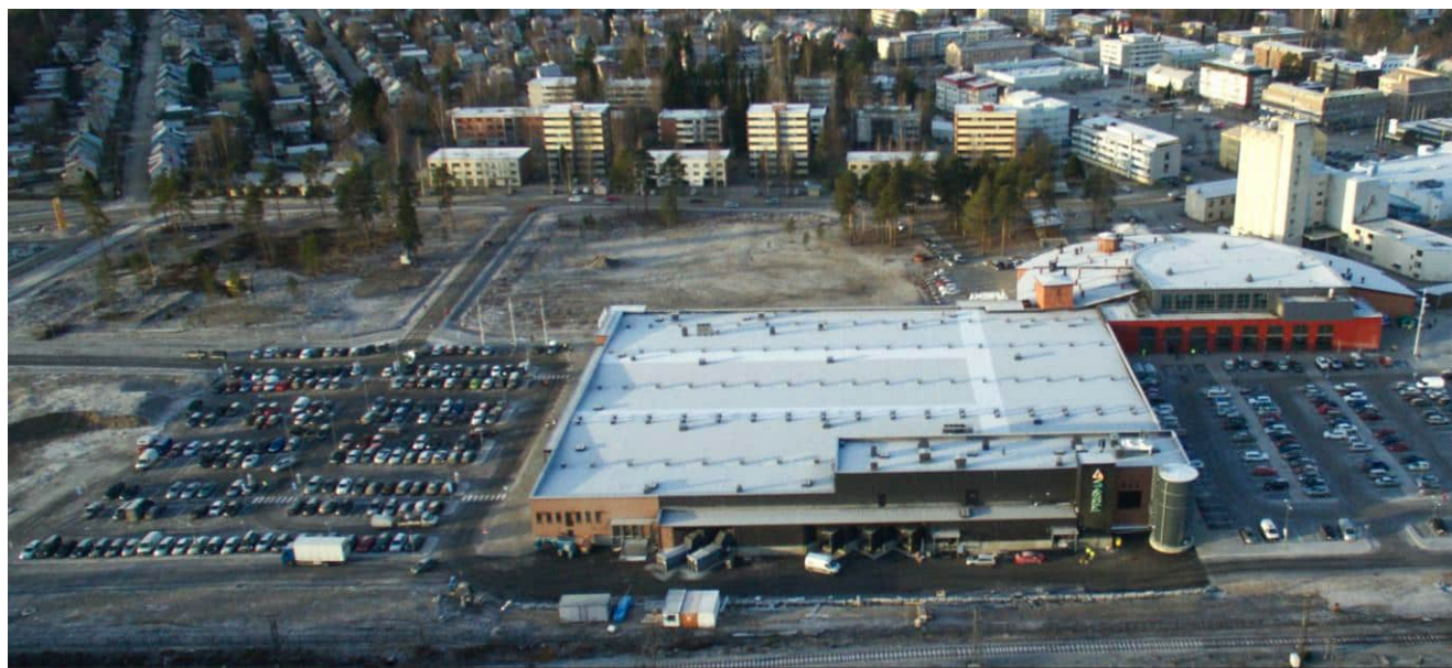
Kuva 2. Ilmakuva. Oikealla Veturitalli ja Prisma. Suunnittelualue on Veturitallin vasemmalla puolella sijaitseva rakentamaton alue.
