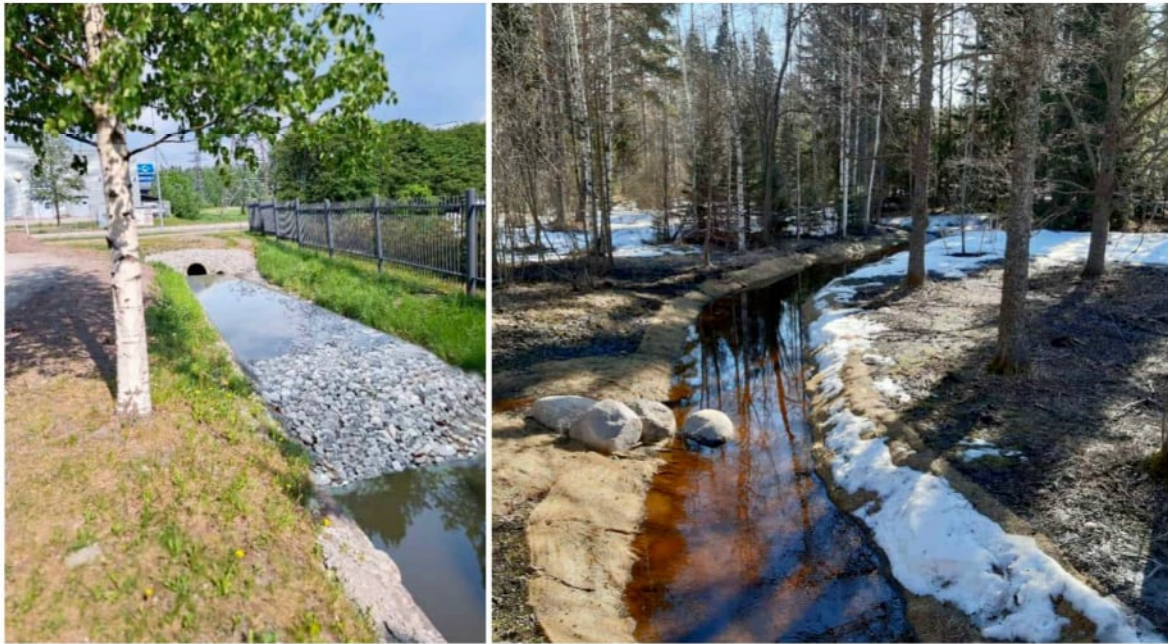
Kuva 16. Vasemmalla havainnollistus ojan yhteyteen toteutetusta väliaikaisesta suotopadosta kiintoaineksen pois- tamiseksi työmaavesistä. Oikealla eroosiosuojakankaalla suojattu oja. © Destia Oy 2024.
