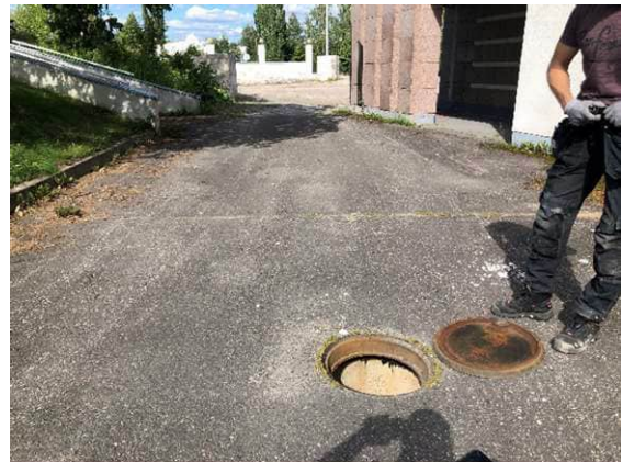
Kuva 2 Pysäköintialue ja osa kulkuväylistä asfaltoitu
