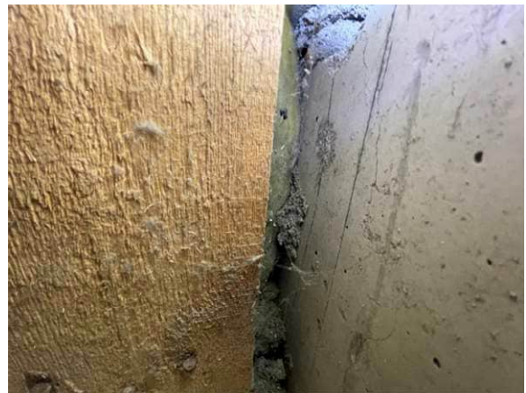
Kuva 28 RA1, puurungossa tuuletusrako, seinän lämmöneriste kiinni betonissa
