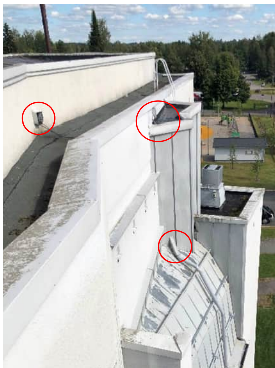
Kuva 15 Vedenpoisto toteutettu monimutkaisesti, ylemmien tasojen vedet johdetaan alemmille tasoille ja syökytorvet kulkevat osittain rakenteiden sisällä
