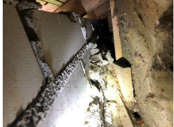
Kuva 33 RA10, avauskohdan takana näkyvissä kattovasat
