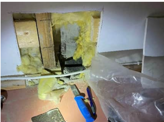
Kuva 20 RA3, lämmöneriste asennettu betonia vasten
