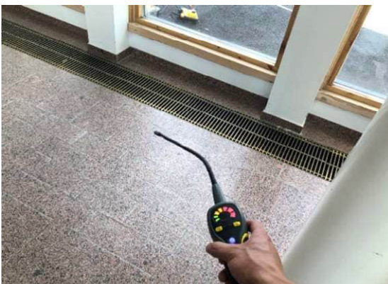
Kuva 46 Tilassa 1088 merkittävää ilmavuotoa, tila täyttyi merkkiainekaasulla
