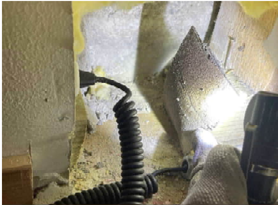
Kuva 19 RA2, sokkelihalkaisussa mineraalivillaa, puurunko ja lämmöneriste asennettu betonia vasten
