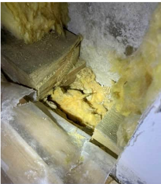
Kuva 31 RA9, alasidepuun alla sokkelihalkaisuna mineraalivillaa
