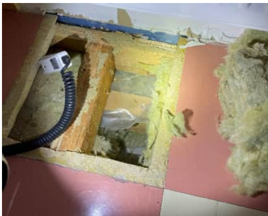
Kuva 25 RA7, alapohja koolattu betonilaatan päälle, lämmöneristeenä mineraalivillaa, ulkoseinän höyrynsulku kääntyy lattiakoolausten väliin
