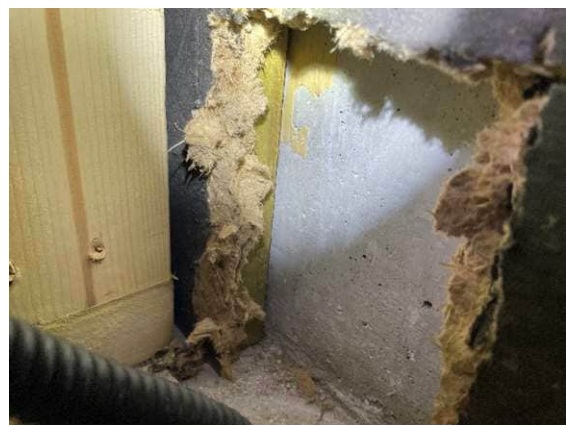
Kuva 23 RA5, lautakoolaus betonia vasten
