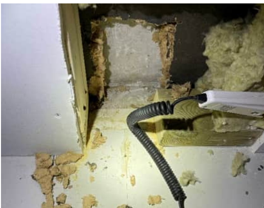
Kuva 22 RA5, seinä rakennettu lattiapinnoitteen päälle
