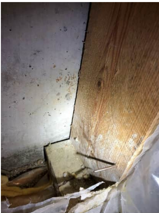
Kuva 29 RA8, puurunko ja lämmöneriste kiinni betonissa
