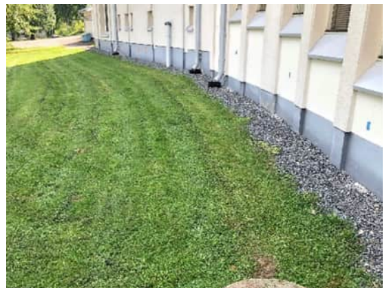
Kuva 4 Nurmipintaisten alueiden seinustalla sepelikaista
