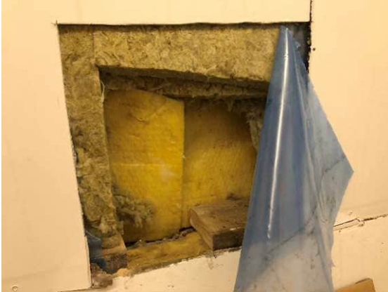
Kuva 32 RA10, sisäpinnassa höyrynsulkumuovi, takana tuulensuojana kova villa
