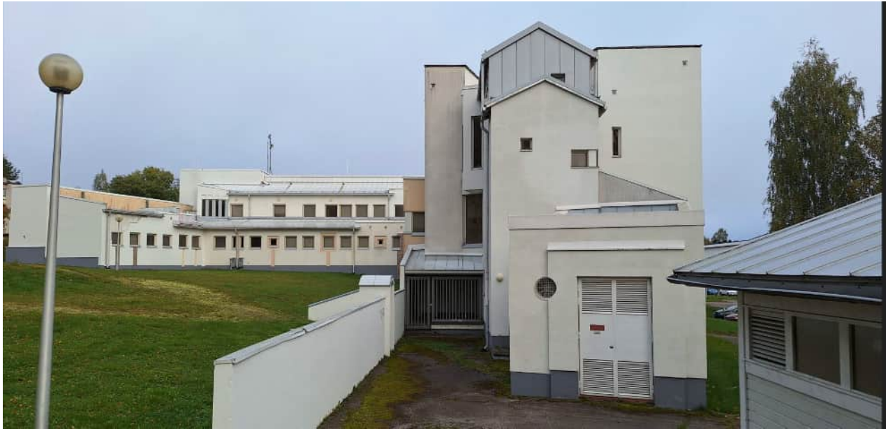
Kuva 9. Kanttila, julkisivu kaakkoon (kuva 2025)
