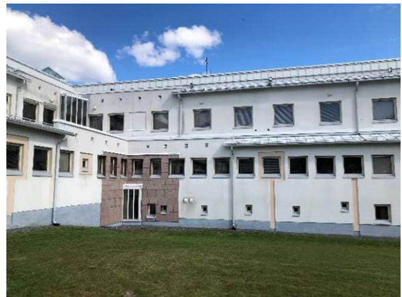
Kuva 8 Yleiskuva julkisivusta, julkisivussa paikoin graniittilaattaa
