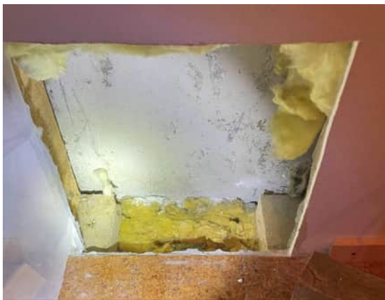
Kuva 27 RA1, seinä mineraalivillaeristeinen, sokkelihalkaisuna mineraalivillaa
