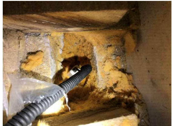
Kuva 41 RA18, sokkelihalkaisuna mineraalivillalla
