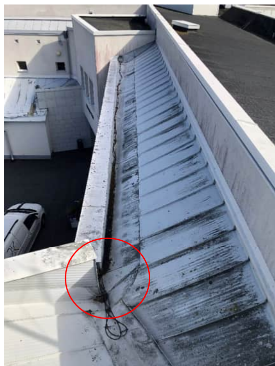
Kuva 16 Vedenpoisto toteutettu monimutkaisesti ja sisäpuolisella vedenpoistolla
