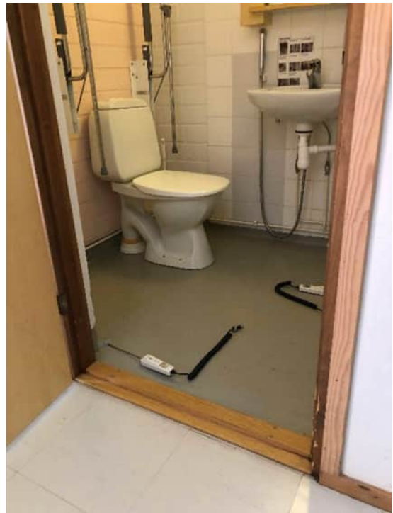
Kuva 18 WC lattia muovimattoa, seinät laatoitettuja
