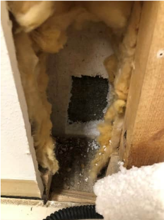
Kuva 21 RA4, seinärakenne puurakenteinen, betonia vasten EPS
