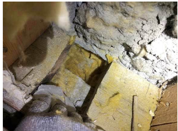
Kuva 39 RA17, sokkelin lämmöneristeenä on mineraalivilla
