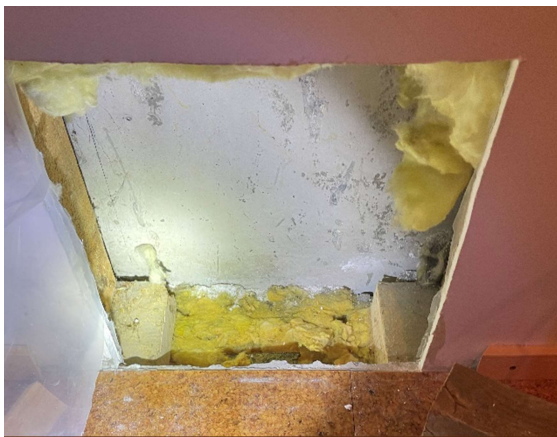
Kuva 27 RA1, seinä mineraalivillaeristeinen, sokkelihalkaisuna mineraalivillaa
