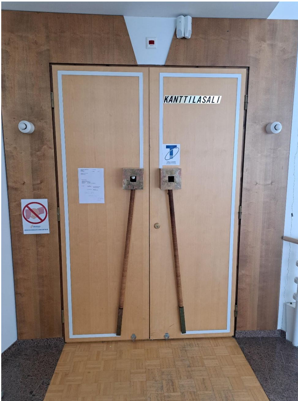
Kuva 61 Kuva Kanttilasta, 2024 (Reponen Heikki, Pieksämäen kaupunki). Kanttilasalin ovissa ei ole havaittavissa merkittäviä muutoksia vuoden 2018 inventointiin nähden. Lattiamateriaali oven edustalla on hieman kuluneempi kuin vuoden 2018 kuvanottohetkellä. Kanttilasalin sisäänkäynnin viereisessä seinässä on havaittavissa maalipinnan halkeilua.
