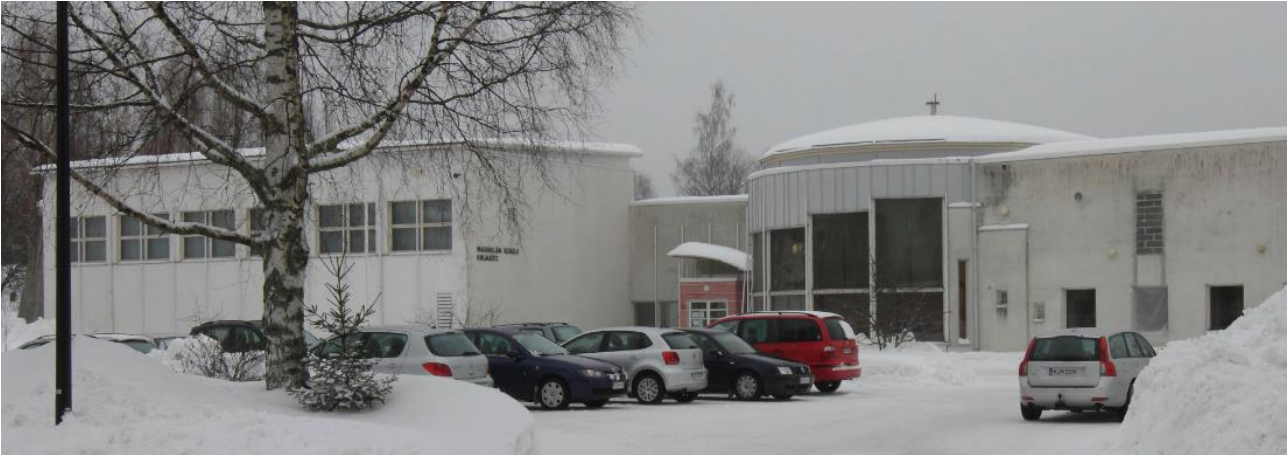
Kuva 46 Vuonna 2019 purettu Maaselän koulu. Vasemmalla liikuntahalli, keskellä pääsisäänkäynti ja oikealla ruokala. Kuvassa koulun julkisivu kaakkoon (Kervinen FCG, 2018).
