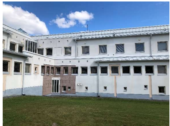
Kuva 8 Yleiskuvaa julkisivusta, julkisivussa paikoin graaniittilaattaa
