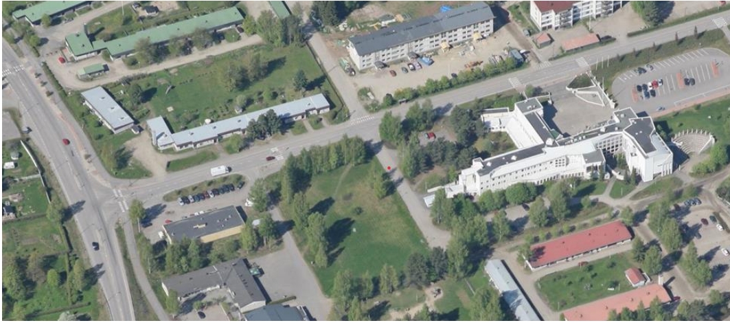
Kuva 3: Yleiskuva suunnittelualueesta. Oikealla sijaitseva valkoinen rakennus Kanttila. (2012)
