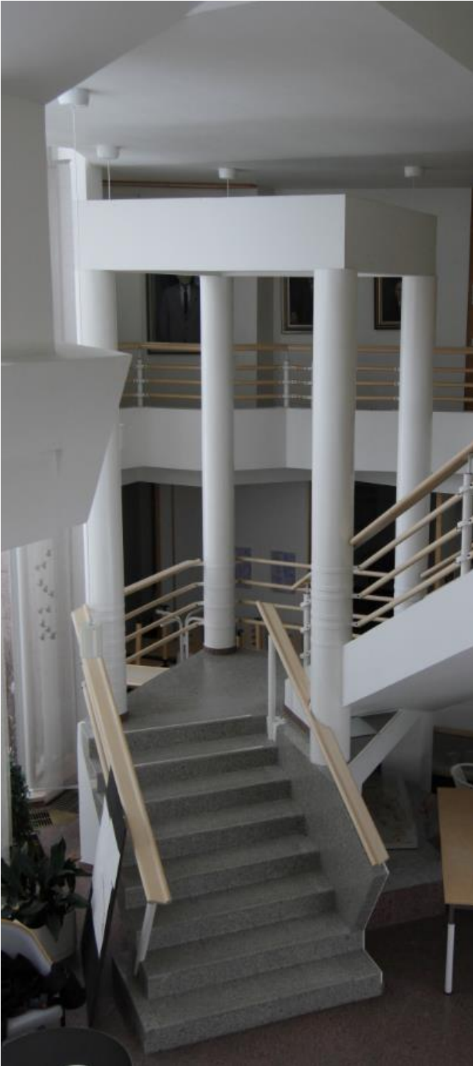
Kuva 29 Kuva vuoden 2018 rakennetun kulttuuriympäristön selvityksestä (Kervinen Minttu, FCG). Virasto-osan portaat yläkerroksesta pääkerrokseen. Kaide on suunniteltu rakennukseen. Rakennuksen sisätiloissa ei ole tapahtunut merkittäviä muutoksia kuten saneerauksia tai tilallisia muutoksia vuoden 2018 inventoinnin jälkeen.
