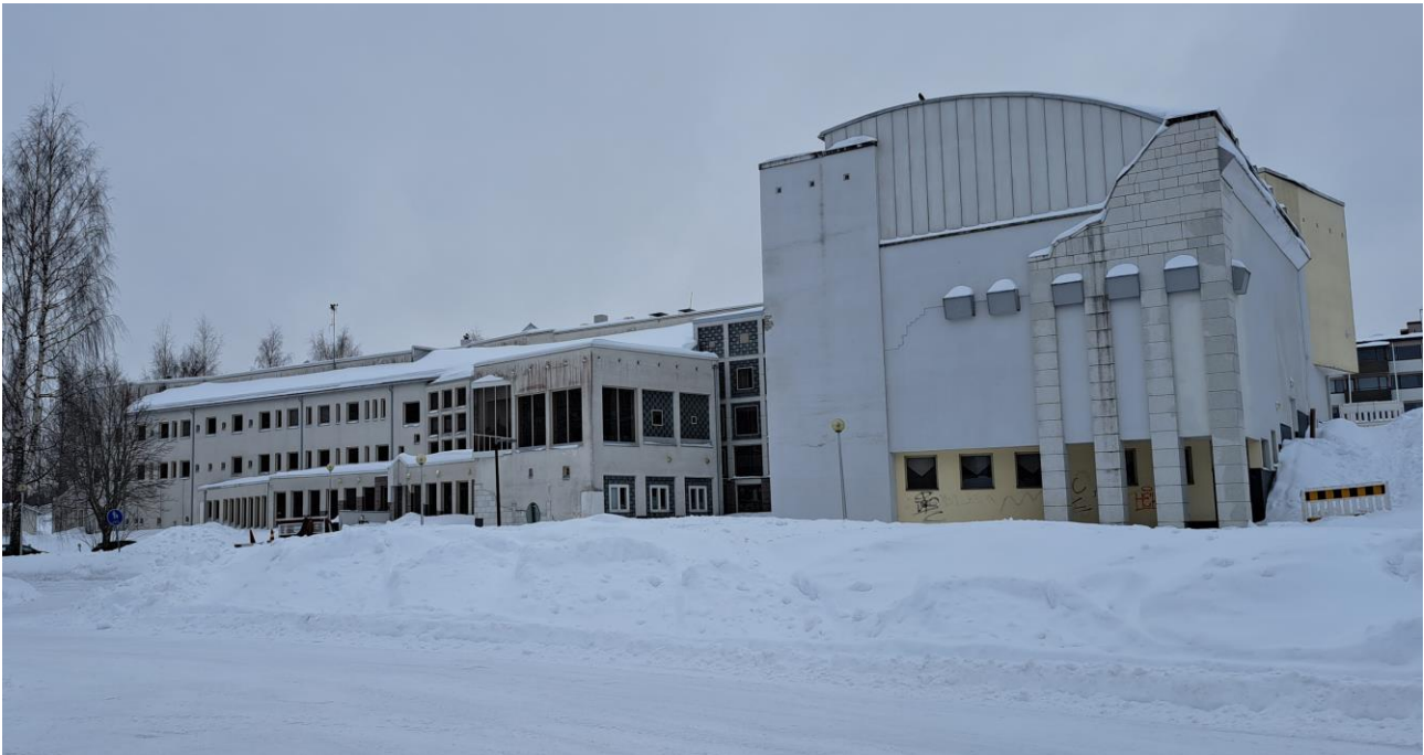
Kuva 19 Vuoden 2024 kuva (Reponen Heikki, Pieksämäen kaupunki) Kanttilan monimuotoisesta koillisjulkisivusta. Rappaus on ja betonilevyt ovat paikoin kärsineet, ja seiniin on kohdistunut ilkivaltaa, mm. graffiteja.
