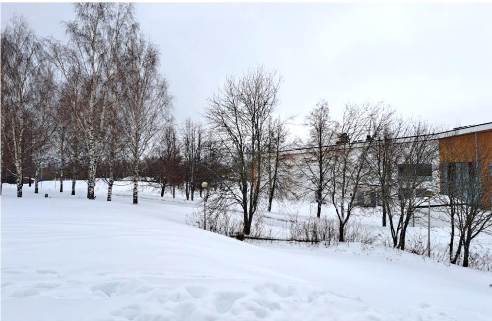
Kuva 63 Kuva Kanttilasta, 2024 (Reponen Heikki, Pieksämäen kaupunki). Amfiteatteri ja sen betonirakenteet on purettu Kanttilan luoteispäädystä. Kuvan oikeassa reunassa taustalla näkyy vuonna 2021 valmistunut Maaselän päiväkotikoulu.
