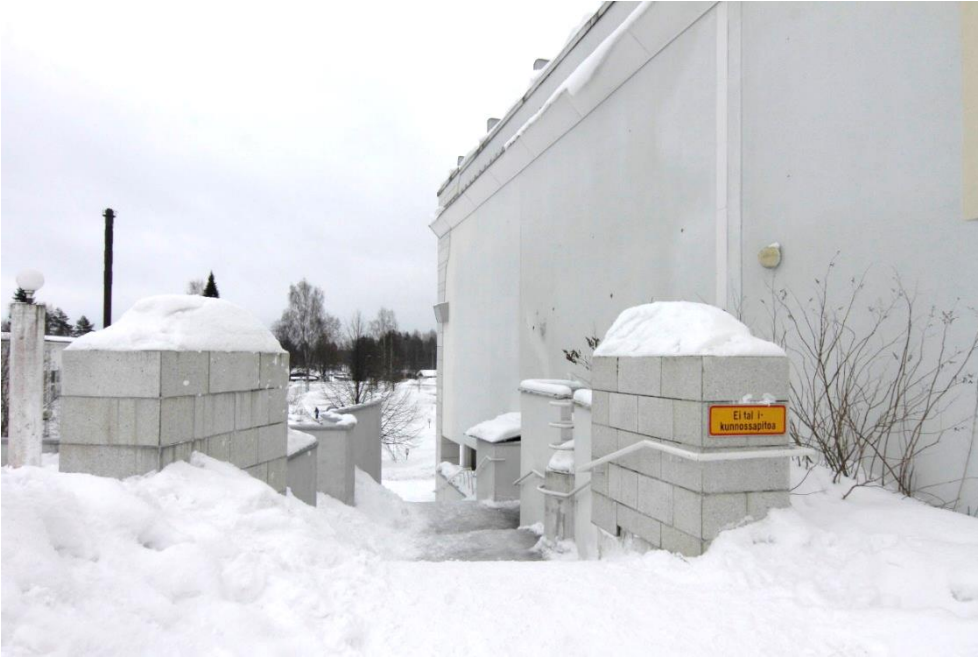
Kuva 69 Kuva vuoden 2018 rakennetun kulttuuriympäristön selvityksestä (Kervinen Minttu, FCG). Kanttilan luoteispäädyn portaat kuvattuna koilliseen päin. Osa portaiden vierellä kulkevista betonirakenteista on vuorattu vaaleanharmaalla Palazzo-betonilevyllä.
