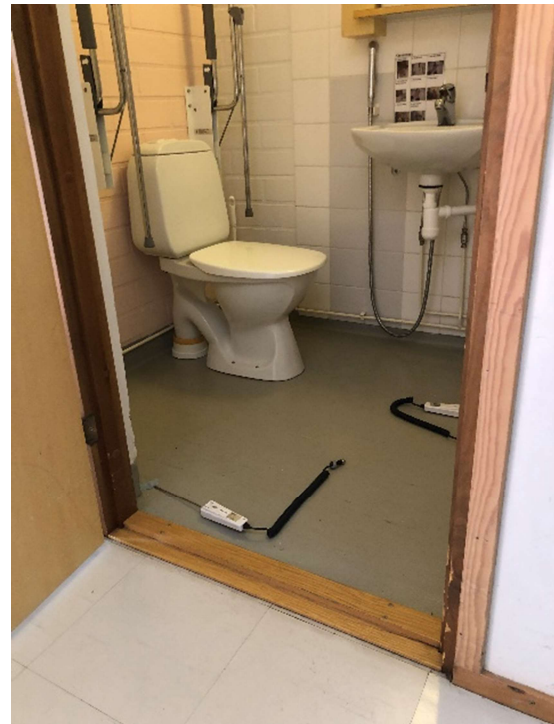
Kuva 18 WC lattia muovimattoa, seinät laatoitettuja
