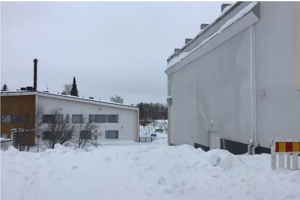
Kuva 70 Kuva Kanttilasta, 2024 (Reponen Heikki, Pieksämäen kaupunki). Kanttilan luoteispäädyn portaat on purettu. Kanttilan luoteispäädystä ei muuten näy merkittäviä muutoksia aiempaan inventointiin nähden. Kuvassa vasemmalla näkyy vuonna 2021 valmistunut uusi Maaselän päiväkotikoulu.
