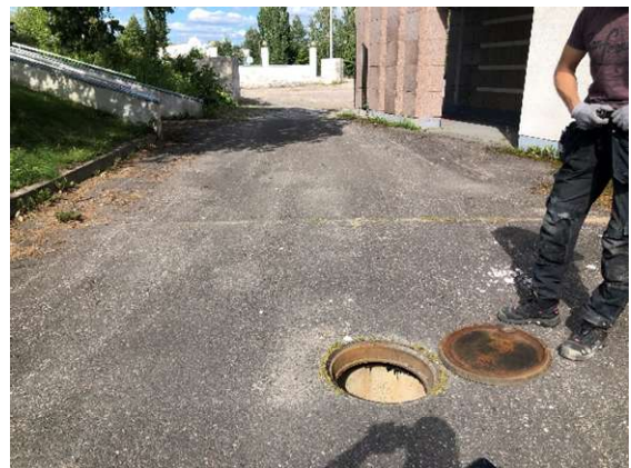
Kuva 2 Pysäköintialue ja osa kulkuväylistä asfaltoitu
