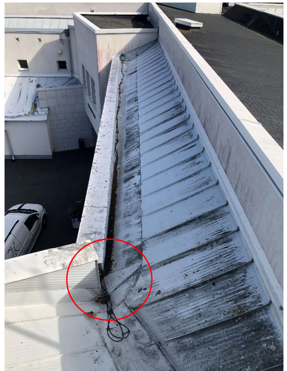
Kuva 16 Vedenpoisto toteutettu monimutkaisesti ja sisäpuolisella vedenpoistolla
