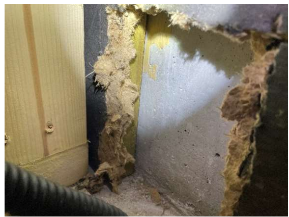
Kuva 23 RA5, lautakoolaus betonia vasten
