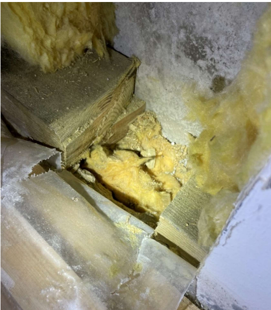
Kuva 31 RA9, alasidepuun alla sokkelihalkaisuna mineraalivillaa
