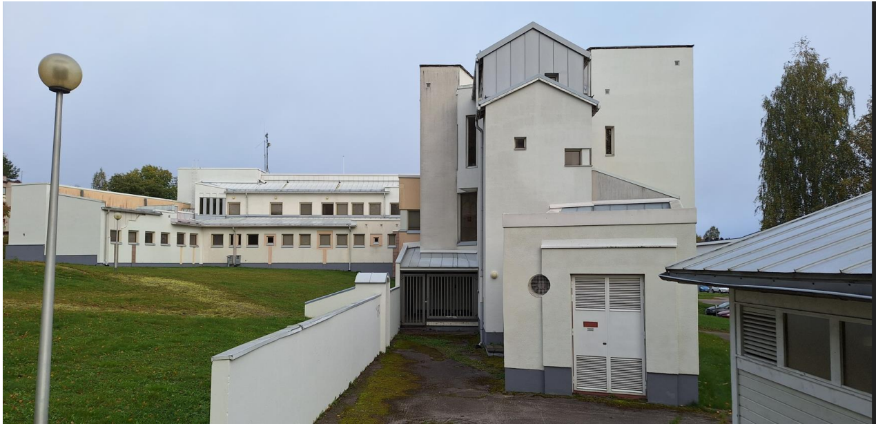
Kuva 9. Kanttila, julkisivu kaakkoon (kuva 2025)
