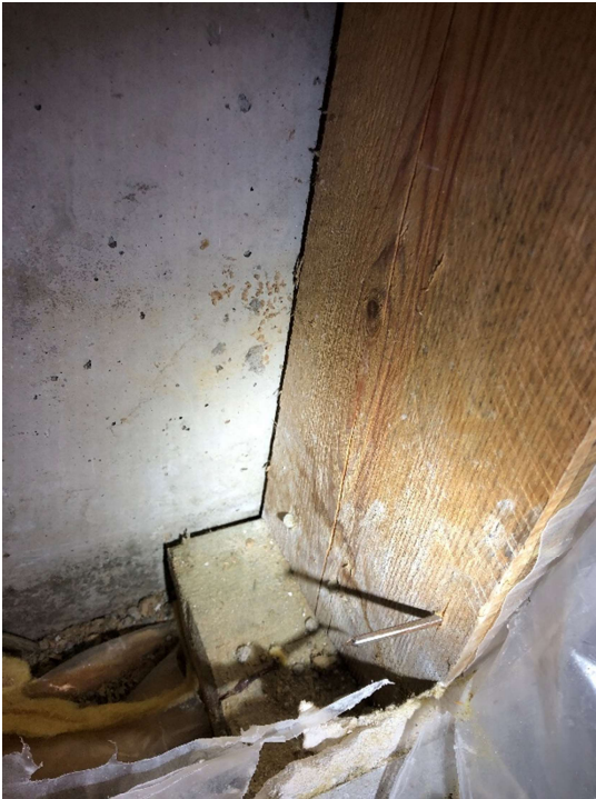
Kuva 29 RA8, puurunko ja lämmöneriste kiinni betonissa
