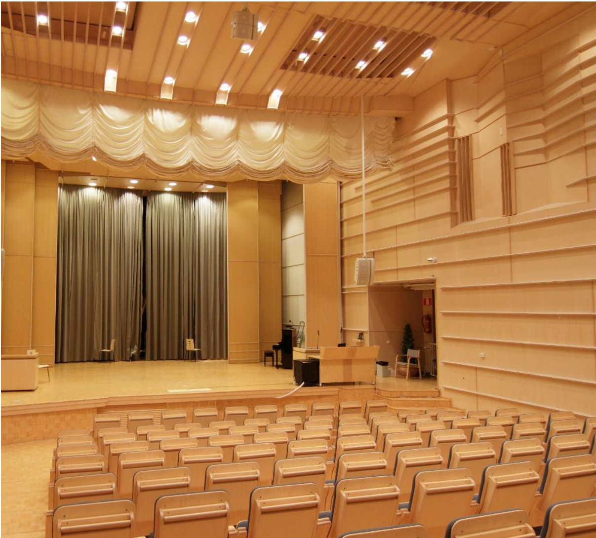
Kuva 56 Kuva vuoden 2018 rakennetun kulttuuriympäristön selvityksestä (Kervinen Minttu, FCG). Auditorion seinät ja katto on verhoiltu koivuviilutetuin lastulevyin. Lattia on saarniparkettia. Salin muotoilu noudattaa muun rakennuksen henkeä, mutta seinien taitteet palvelevat myös akustiikkaa. Salin akustisen suunnittelun on tehnyt arkkitehti Alpo Halme.
