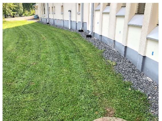
Kuva 4 Nurmipintaisten alueiden seinustalla sepelikaista
