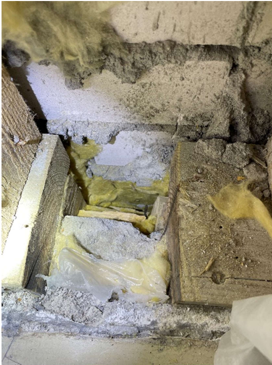
Kuva 36 RA16, tuuletusrako tukossa laastipurseista
