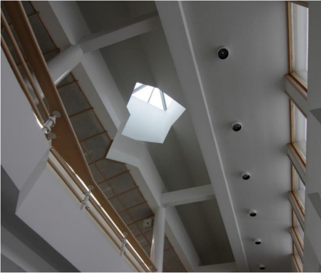
Kuva 27 Kuva vuoden 2018 rakennetun kulttuuriympäristön selvityksestä (Kervinen Minttu, FCG). Pääaulan monimuotoista tilasommittelua, jota korostaa kattoikkuna.
