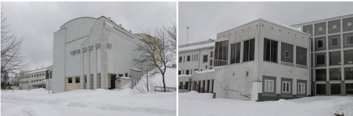
Kuva 17 ja Kuva 18 Kuvat ovat vuoden 2018 rakennetun kulttuuriympäristön selvityksestä (Kervinen Minttu, FCG). Vasemmalla Kanttilan auditoriosiiپی rakennuksen pohjoispäässä. Julkisivussa on käytetty rappausta ja massiivikiviladontaa jäljitteleviä Palazzo-julkisivulaattoja. Oikealla Kanttilan keskusaulan puiston puoleinen lasijulkisivu sekä muusta rakennusmassasta kuutiona erottuva kahvio-osa. Alun perin maantasoon puiston puolelle on sijoittunut kansalaisopiston tiloja.
