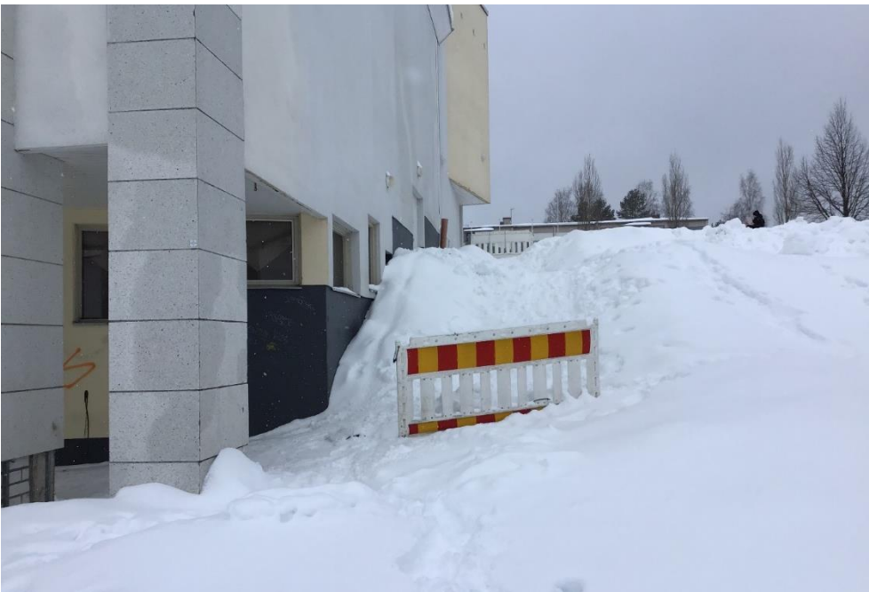
Kuva 68 Kuva Kanttilasta, 2024 (Reponen Heikki, Pieksämäen kaupunki). Portaat ja betonirakenteet on purettu Kanttilan luoteispäädystä. Portaiden paikasta on muistuttamassa väliaikainen kulkua rajoittava työmaa-aita mäen ylä- ja alapäässä. Kuvan vasemmassa alareunassa näkyy, että Palazzo-betonilevyvuorausta on irronnut rakennuksen pohjoisnurkalla sijaitsevan pylvään pinnasta.
