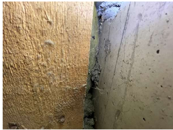
Kuva 28 RA1, puurungossa tuuletusrako, seinän lämmöneriste kiinni betonissa
