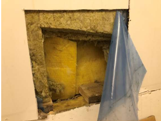
Kuva 32 RA10, sisäpinnassa höyrynsulkumuovi, takana tuulensuojana kova villa
