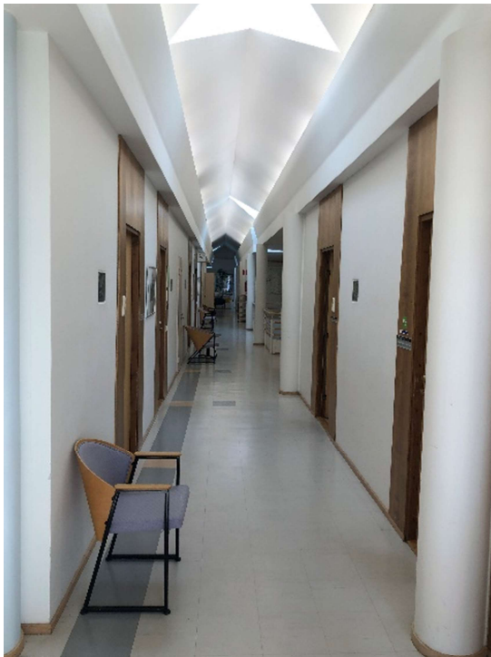
Kuva 17 Yleiskuvaa käytävältä, lattia vinyylilaattaa ja sei- nät levytettyjä ja maalattuja
