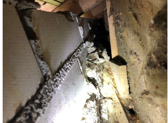
Kuva 33 RA10, avauskohdan takana näkyvissä kattovasat
