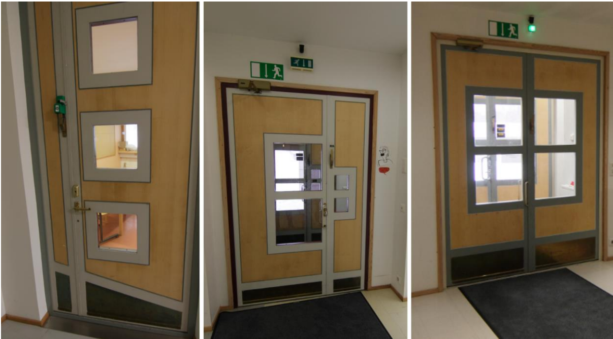
Kuva 37 Kuva vuoden 2018 rakennetun kulttuuriympäristön selvityksestä (Kervinen Minttu, FCG). Kanttilan sisäovet on suunniteltu rakennukseen. Tuulikaappien sisäovet ovat suunnittelultaan yksilöllisiä samoin kuin kokoustilojen ovet. Toimistohuoneiden ovia korostaa puuviilutus niiden ympärillä. Ovissa ei ole tapahtunut merkittäviä muutoksia.
