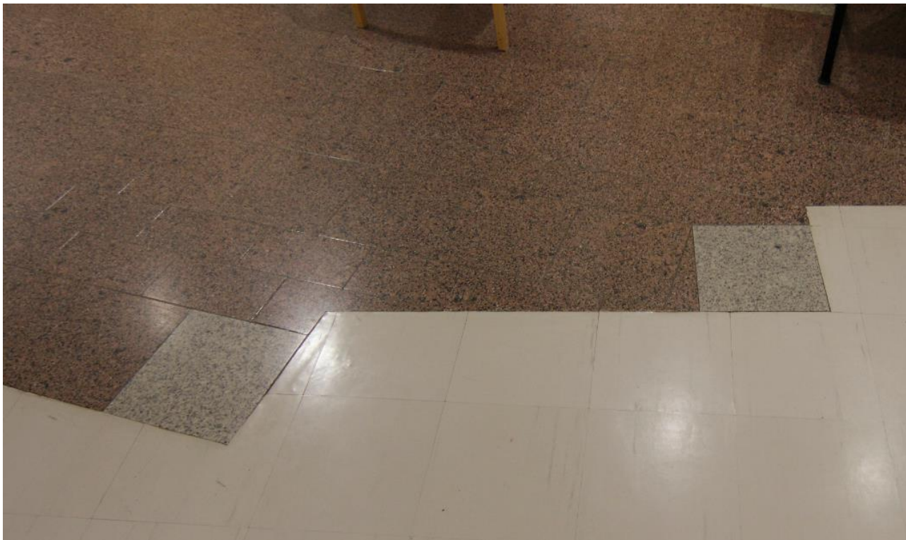
Kuva 33. Kuva vuoden 2018 rakennetun kulttuuriympäristön selvityksestä (Kervinen Minttu, FCG). Pääaulan lattiamateriaalina on käytetty graniittia, joka vaihtuu virasto-osassa vinyylivatsilaatoiksi.
