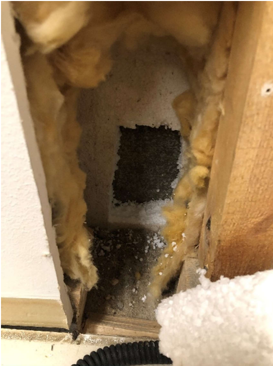
Kuva 21 RA4, seinärakenne puurakenteinen, betonia vasten EPS
