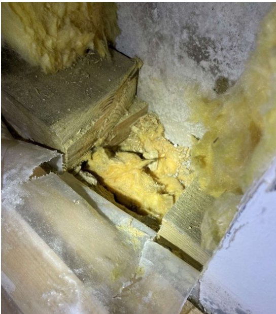
Kuva 31 RA9, alasidepuun alla sokkelihalkaisuna mineraalivillaa
