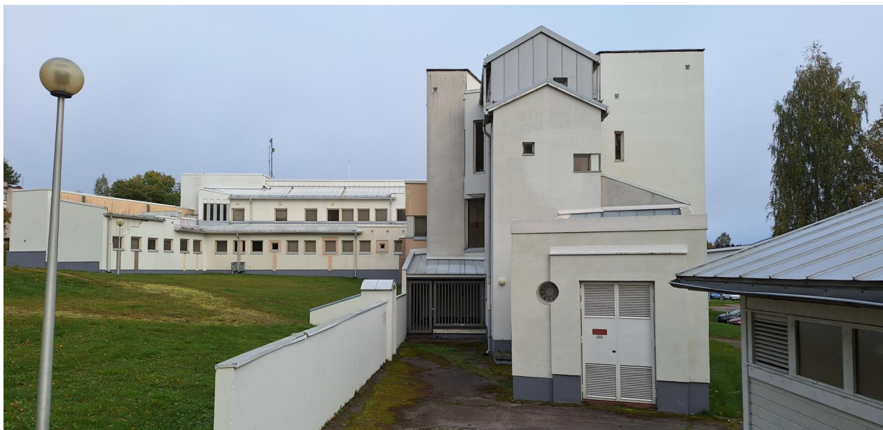
Kuva 9. Kanttila, julkisivu kaakkoon (kuva 2025)
