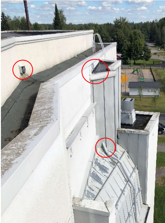
Kuva 15 Vedenpoisto toteutettu monimutkaisesti, ylempien tasojen vedet johdetaan alemmille tasoille ja syökyrsorvet kulkevat osittain rakenteiden sisällä
