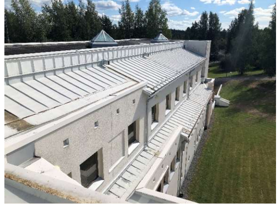
Kuva 14 Vinot osat toteutettu peltikatteella, pelleissä ruostumaa
