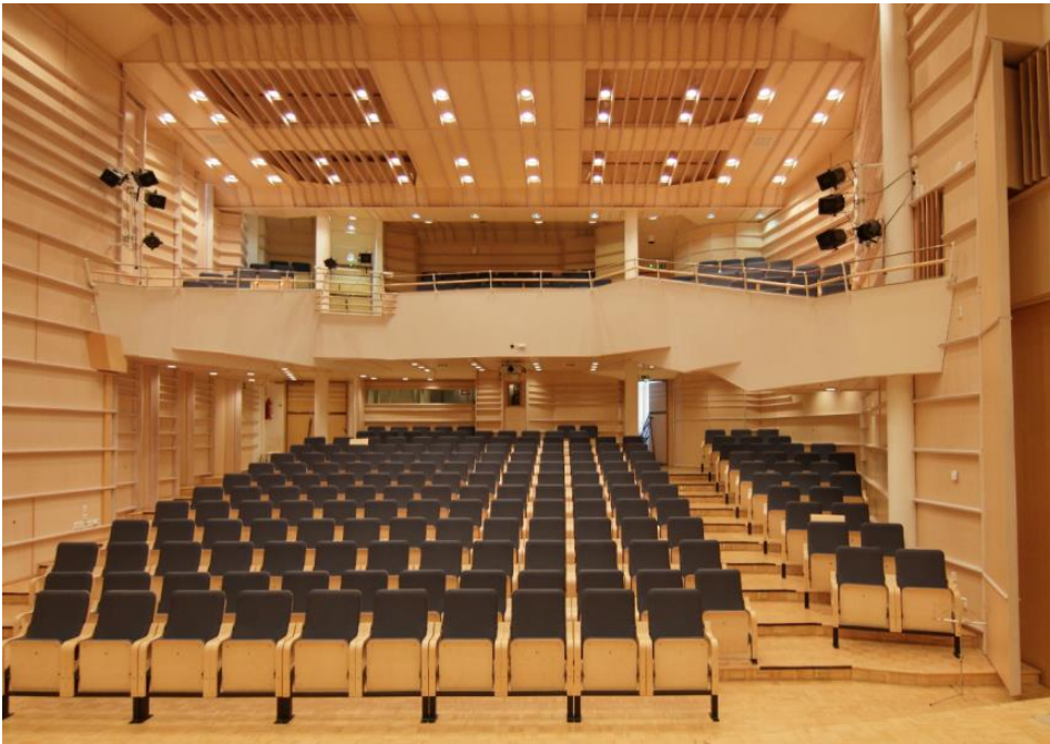
Kuva 58 Kuva vuoden 2018 rakennetun kulttuuriympäristön selvityksestä (Kervinen Minttu, FCG). Auditorion seinät ja katto on verhoiltu koivuviilutetuin lastulevyin ja lattia on saarniparkettia. Salin takaosassa on parvi istumapaikkoineen. Parvelle kulku tapahtuu toisesta kerroksesta.
