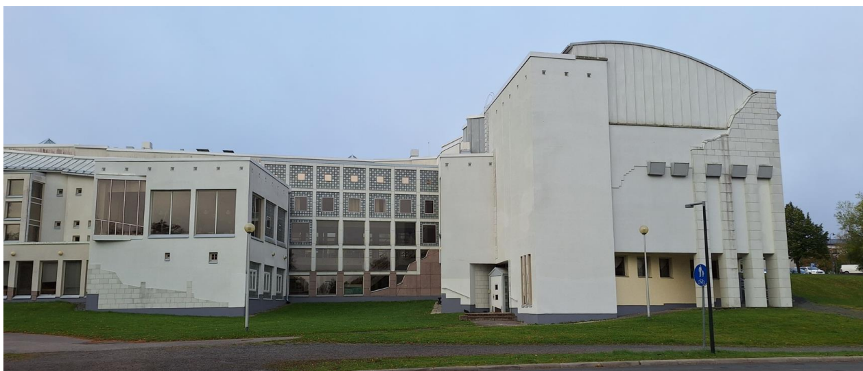
Kuva 7. Virastotalo Kanttila, koillisjulkisivu (kuva 2025)
