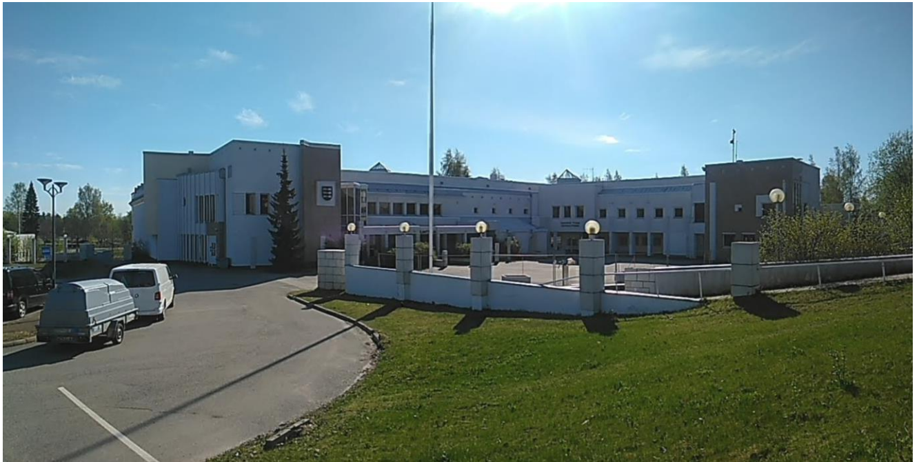
Kuva 1. Kanttila Vilhulantielle päin
