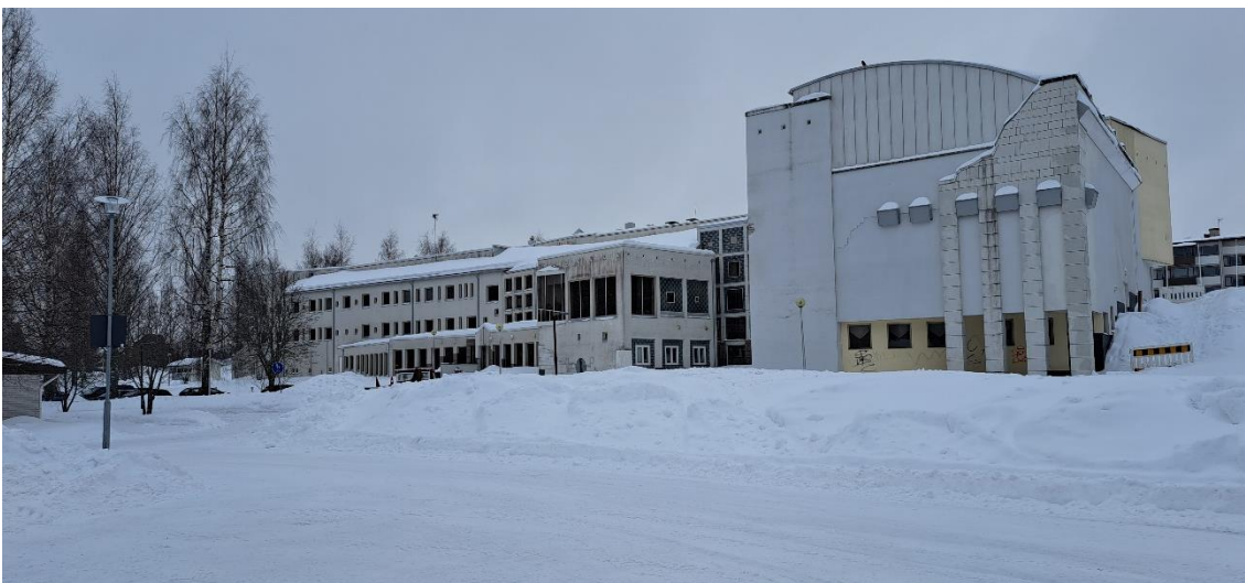
Kuva 51 Kuva Kanttilasta, 2024 (Reponen Heikki, Pieksämäen kaupunki). Kuvassa on havaittavissa useassa paikassa julkisivussa säärasituksen aiheuttamia kosmeettisia vaurioita kuten valumajälkiä ja likaa. Kuvan oikean laidan betonilaattavuorauksessa on havaittavissa likaisia valumajälkiä katolta, ja kuvan keskiosassa näkyvässä vaaleassa rappauksessa on selkeitä pinnan tummentumia. Rappaus on myös paikoitellen irtoillut seinästä, kuten esimerkiksi kuvan oikeassa laidassa näkyvästä auditoriosiiven korkeimmasta seinäelementistä on havaittavissa. Rappauksen alta näkyy paljas tiilipinta. Auditoriosiiven keltaiseen julkisivupintaan on töherrelty graffiteja. Vuoden 2018 inventoinnin jälkeen kuvan oikeassa laidassa sijainneet portaat on purettu rakennuksen luoteispäädystä. Portaiden paikalle on rakennettu väliaikaiset kaiteettomat rappuset, jotka ovat kuvanottohetkellä hangen alla. Portaiden ylä- ja alapäässä on väliaikainen työmaa-aita.
