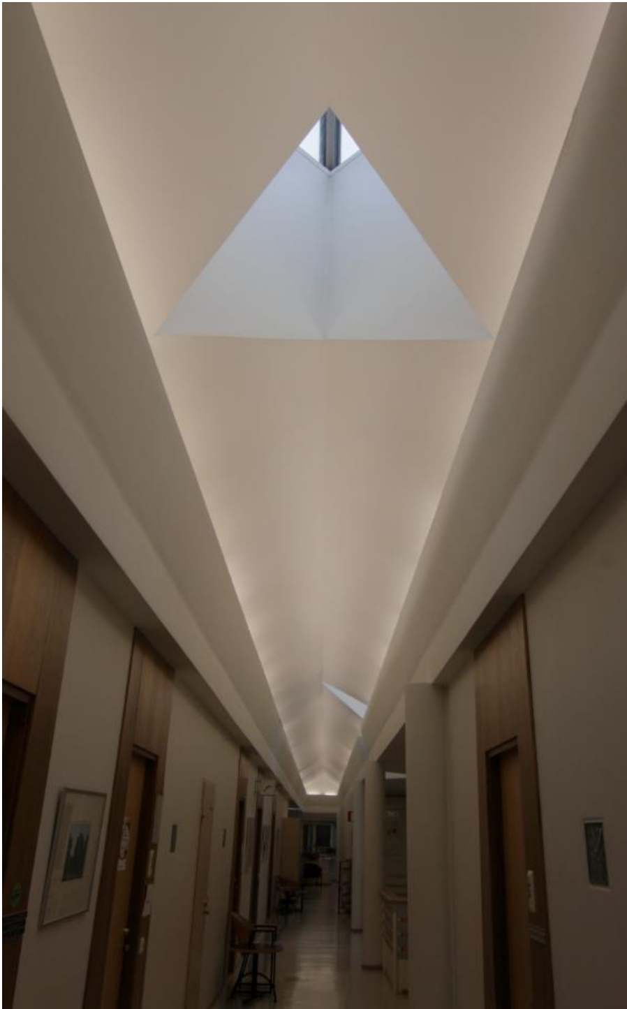
Kuva 36. Kuva vuoden 2018 rakennetun kulttuuriympäristön selvityksestä (Kervinen Minttu, FCG). Käytävä virastosiiven yläkerroksessa. Valaistus heijastetaan epäsuorasti katon kautta. Käytävää rytmittää kattoikkunat. Kuvan ottamisen jälkeen virastosiiven sisätiloissa ei ole tapahtunut merkittäviä muutoksia. Virastosiiven yläkerros on edelleen teknisen toimen käytössä, ja kerroksessa ei ole tehty remonttia tai sisätilamuutoksia.
