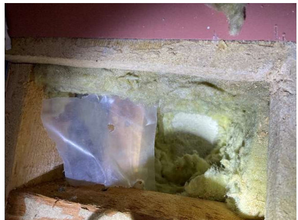
Kuva 26 RA7, mineraalivillan alla betonilaatta
