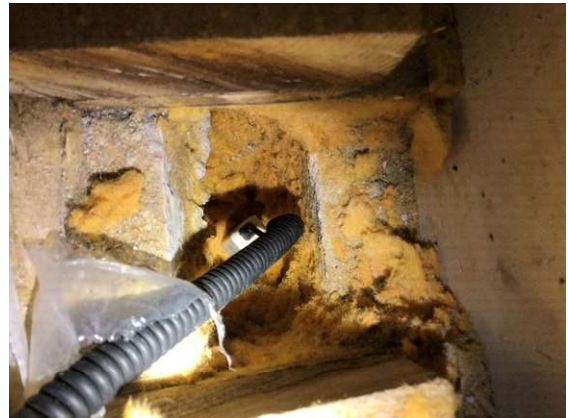
Kuva 41 RA18, sokkelihalkaisuna mineraalivilla
