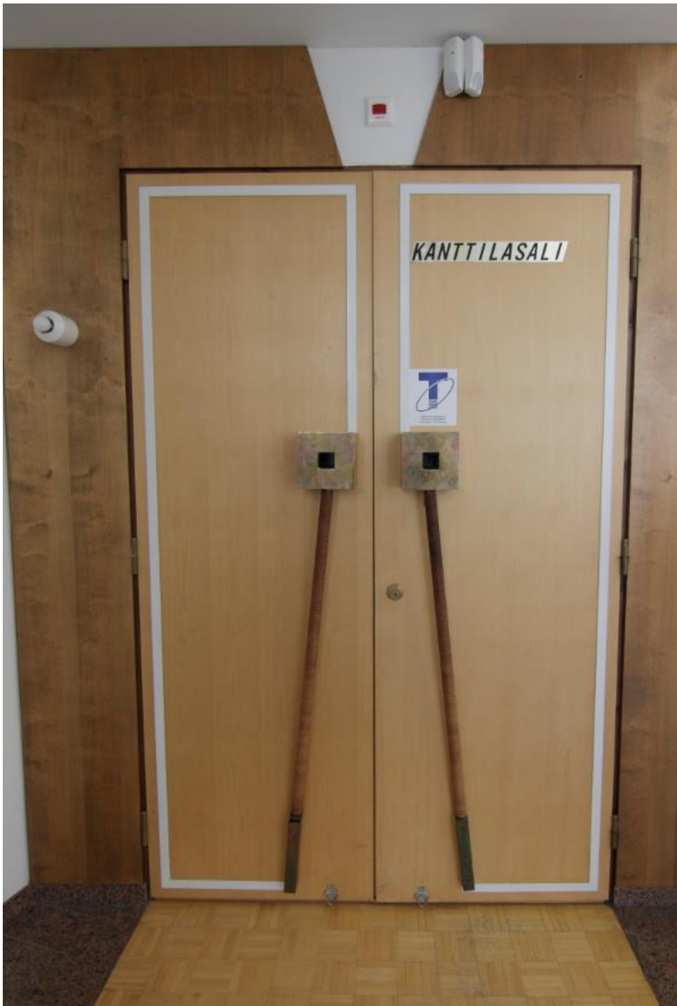
Kuva 60 Kuva vuoden 2018 rakennetun kulttuuriympäristön selvityksestä (Kervinen Minttu, FCG). Kanttilasalin ovet, kuten muutkin rakennuksen sisäövet, on suunniteltu kohteeseen ja ne ovat yksilölliset. Sisäänkäyntiä korostaa seinän puuviilutus oven ympäriltä. Vaaleita ovilehtiä kiertää valkoinen koristelista. Ovenkahvat ovat pitkät ja näyttävät. Ovenkahvojen yksityiskohtana on pienet tirkistysreiät saliin.
