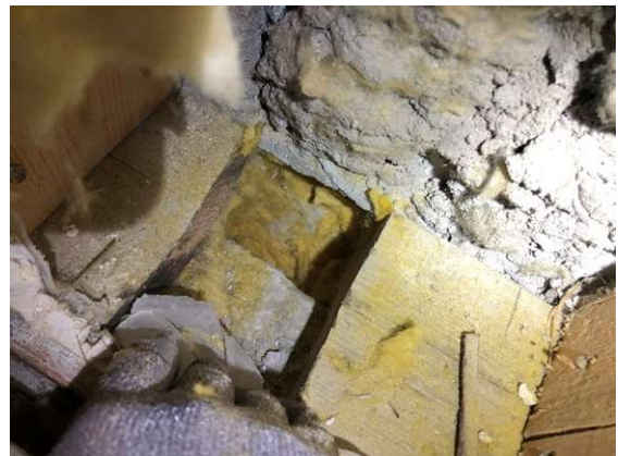
Kuva 39 RA17, sokkelin lämmöneristeenä on mineraalivilla
