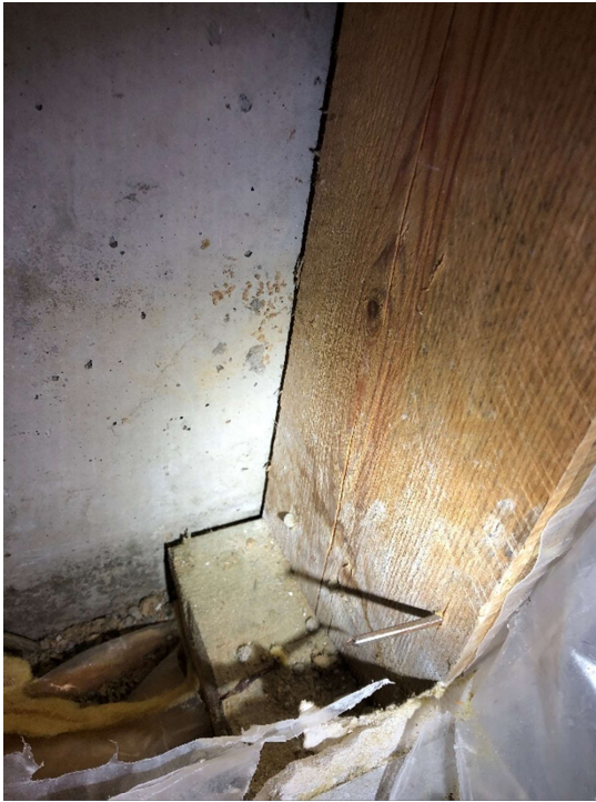
Kuva 29 RA8, puurunko ja lämmöneriste kiinni betonissa
