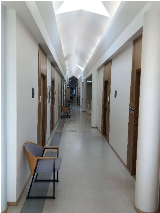
Kuva 17 Yleiskuvaa käytävältä, lattia vinyylilaattaa ja sei- nät levytetyjä ja maalattuja
