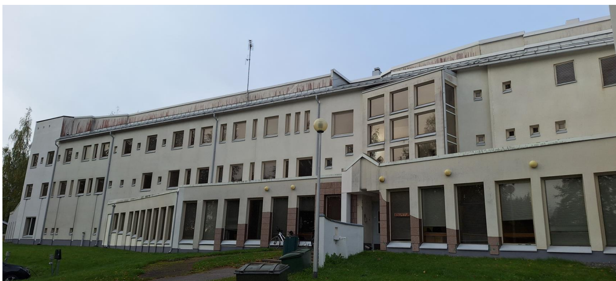
Kuva 8. Kanttila, koillisjulkisivu (kuva 2025)
