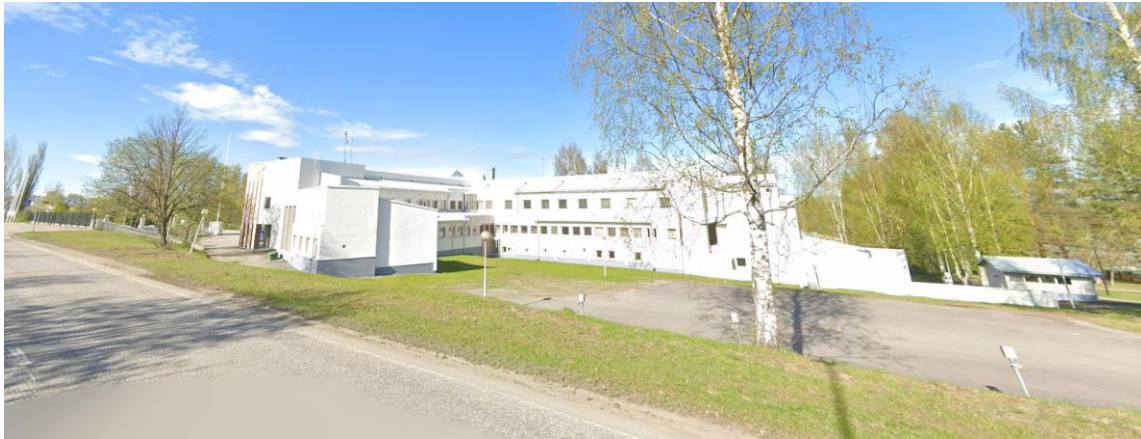
Kuva 3. Kanttila ja pysäköintialue Vilhulantieltä kuvattuna (Google Streetview)
