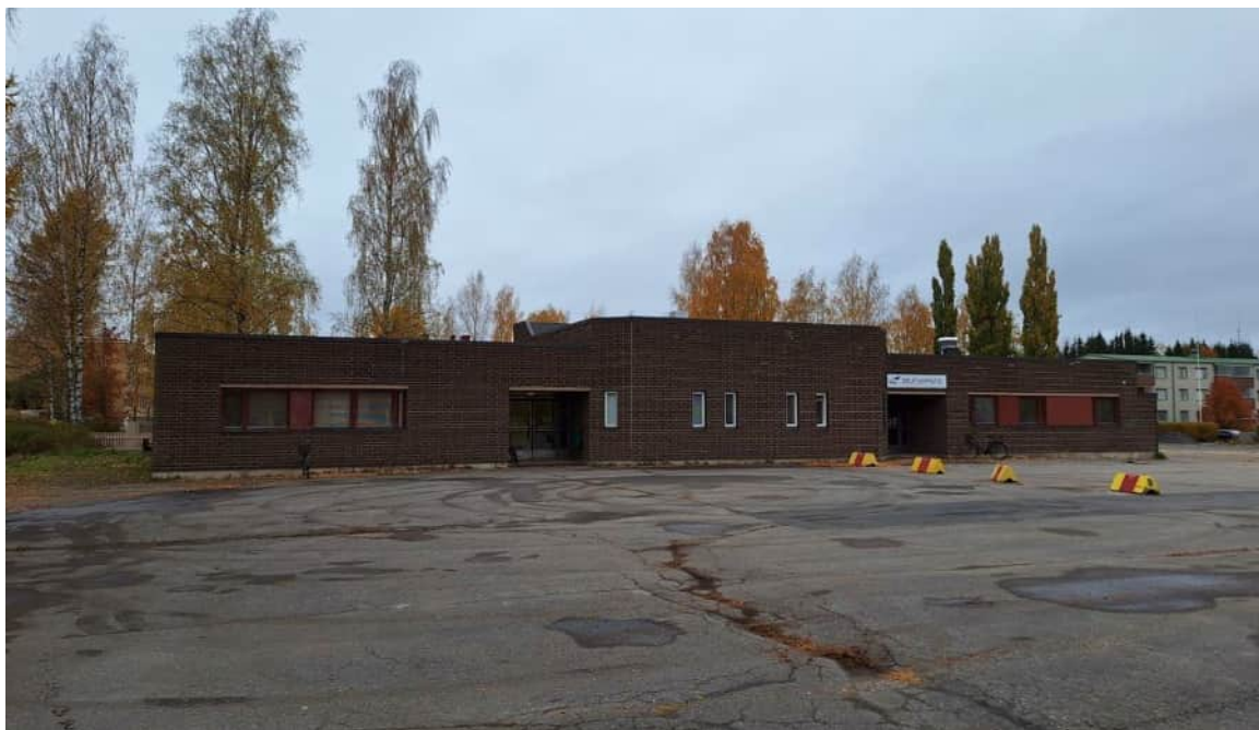
Kuva 7. Suunnittelualueella sijaitseva rakennus (kuva 2025)
