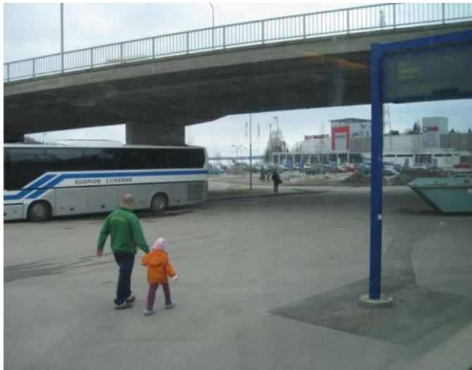
KUVA 16: Jalankulkuympäristöä sillan varjossa.
