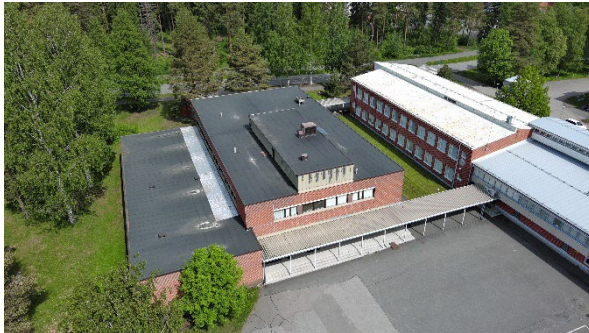
Kuva 4. Rakennuksia alueen pohjoisosassa
