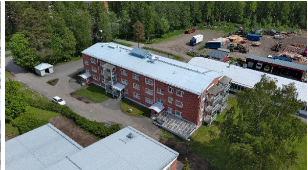
Kuva 5. Asuinkerrostalo alueen pohjoisosassa
