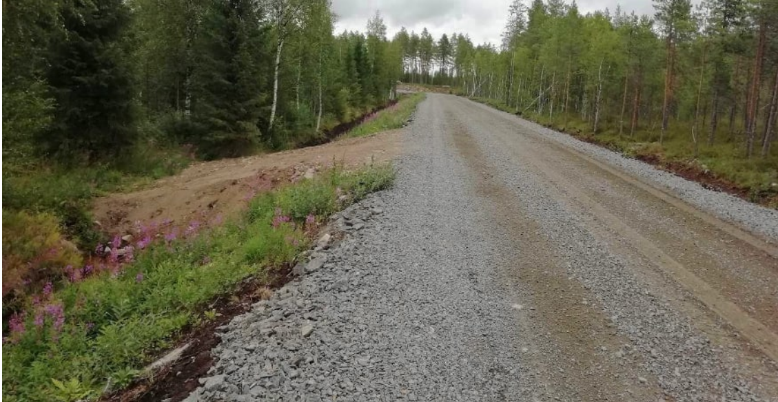
KUVA 42. Esimerkki toteutetusta tuulivoimalapuiston sisäisestä tiestä. Teitä rakennetaan liittymät metsäpalstoille.
