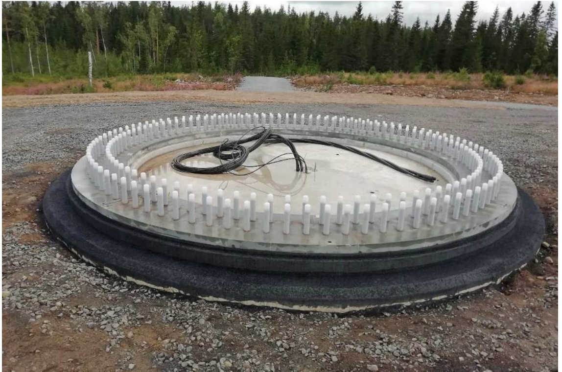
KUVA 41. Toteutettu esimerkki perustuksen maanpäällisestä osasta
