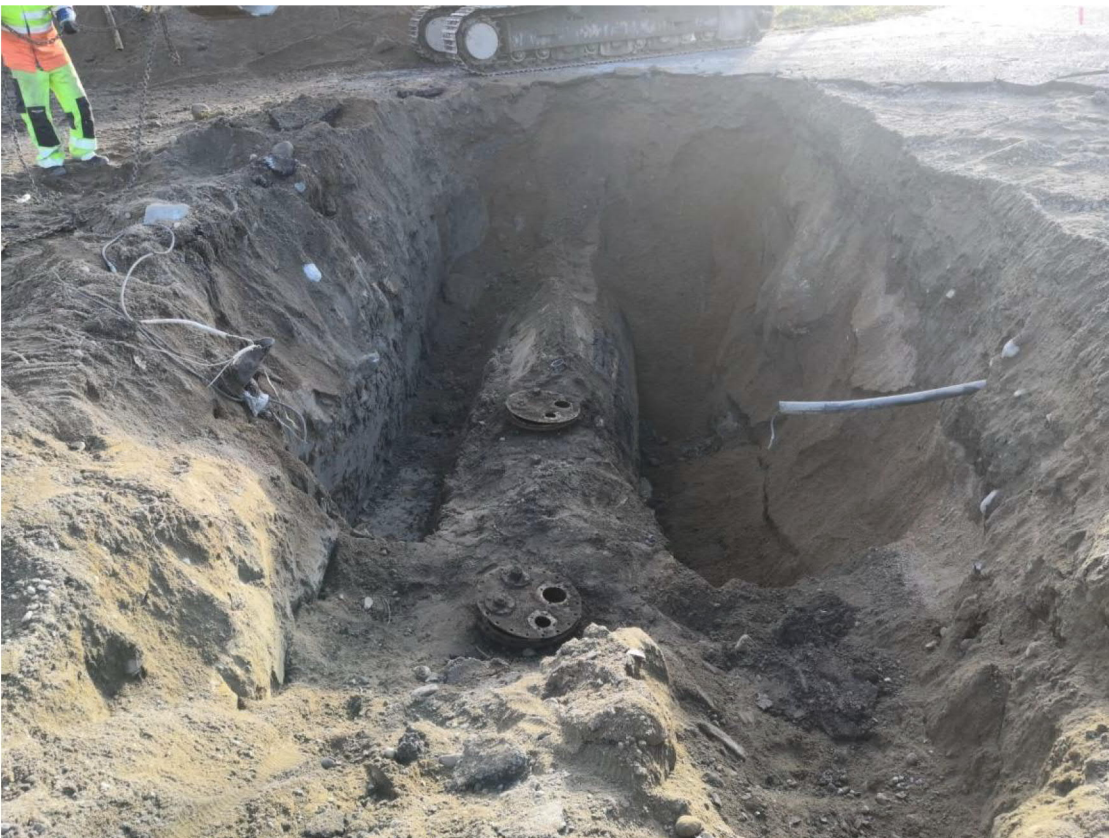
Kuva 2. Polttoainesäiliöt poistovaiheessa
