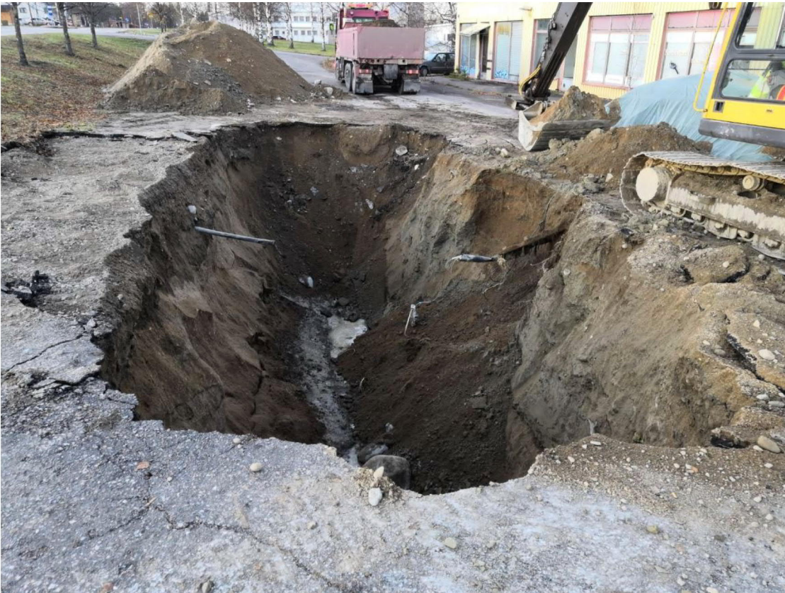
Kuva 4. Kaivanto kunnostuksen lopussa
