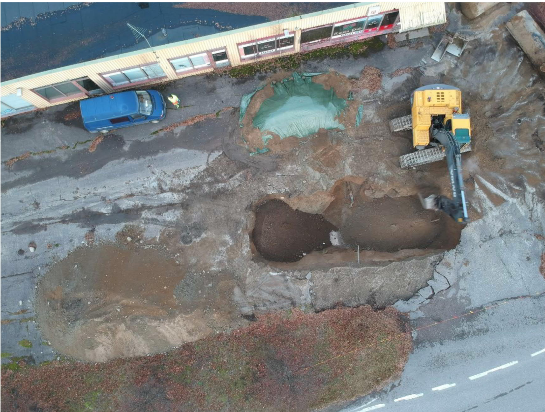
Kuva 6. Kohde kunnostuksen lopussa ja kaivannon täytön alkaessa
