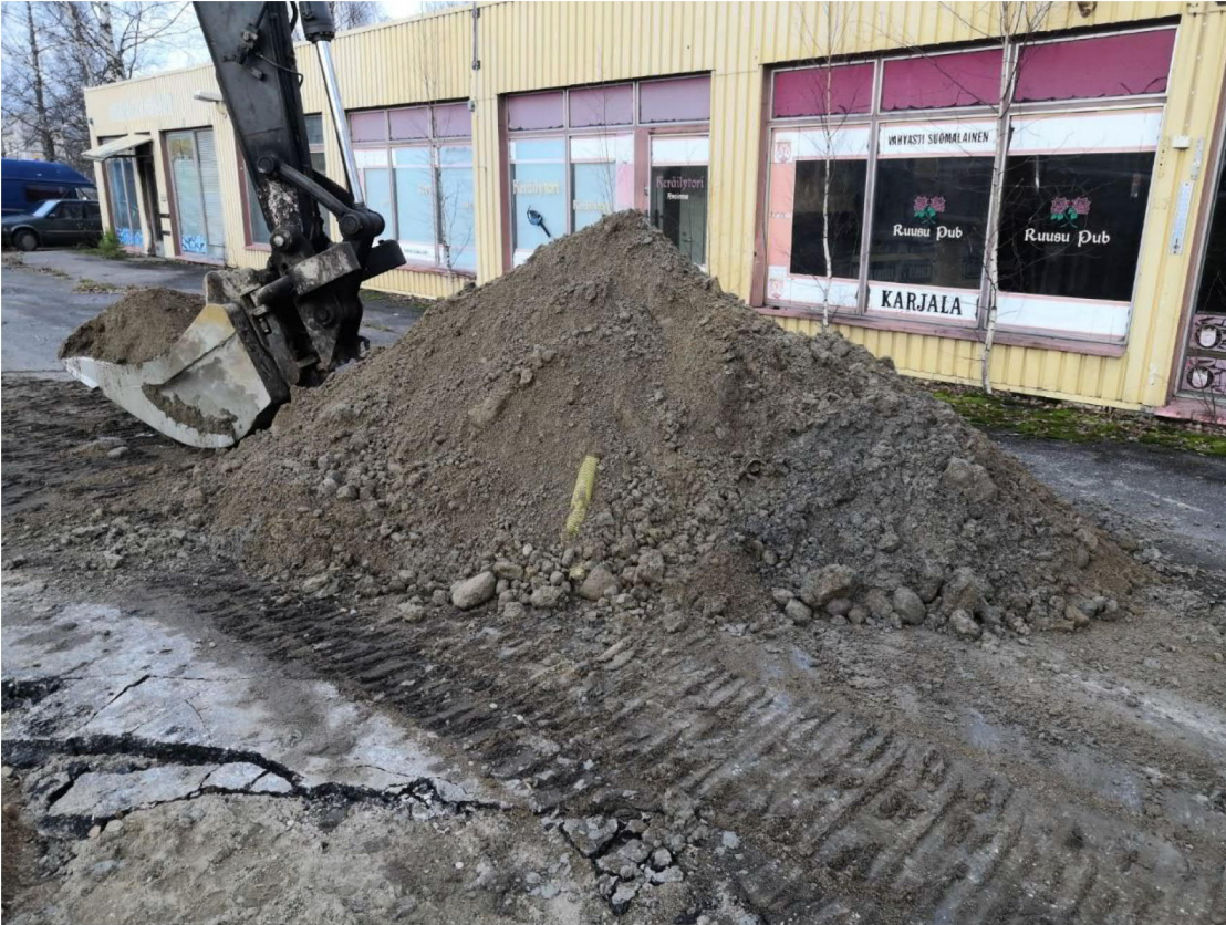
Kuva 5. Poiskuljetettu maa-aines kunnostuksen alkaessa
