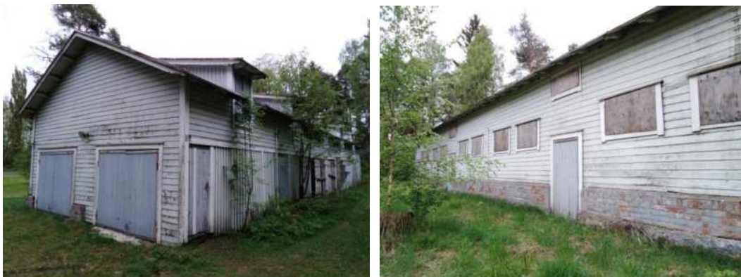
Kuva 35. Julkisivut luoteeseen ja koilliseen.
