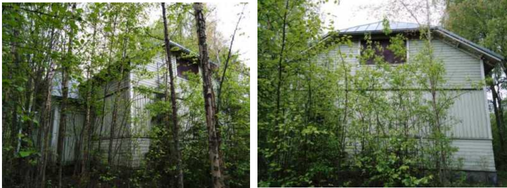
Kuva 31. Toimistorakennuksen julkisivuja koillisesta ja lounaasta.
