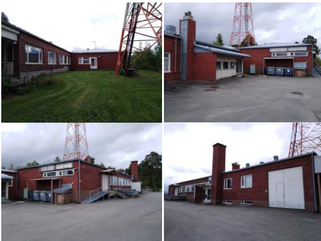
Kuva 5. Toimistorakennus osoitteessa Kukkaroniementie 4.
