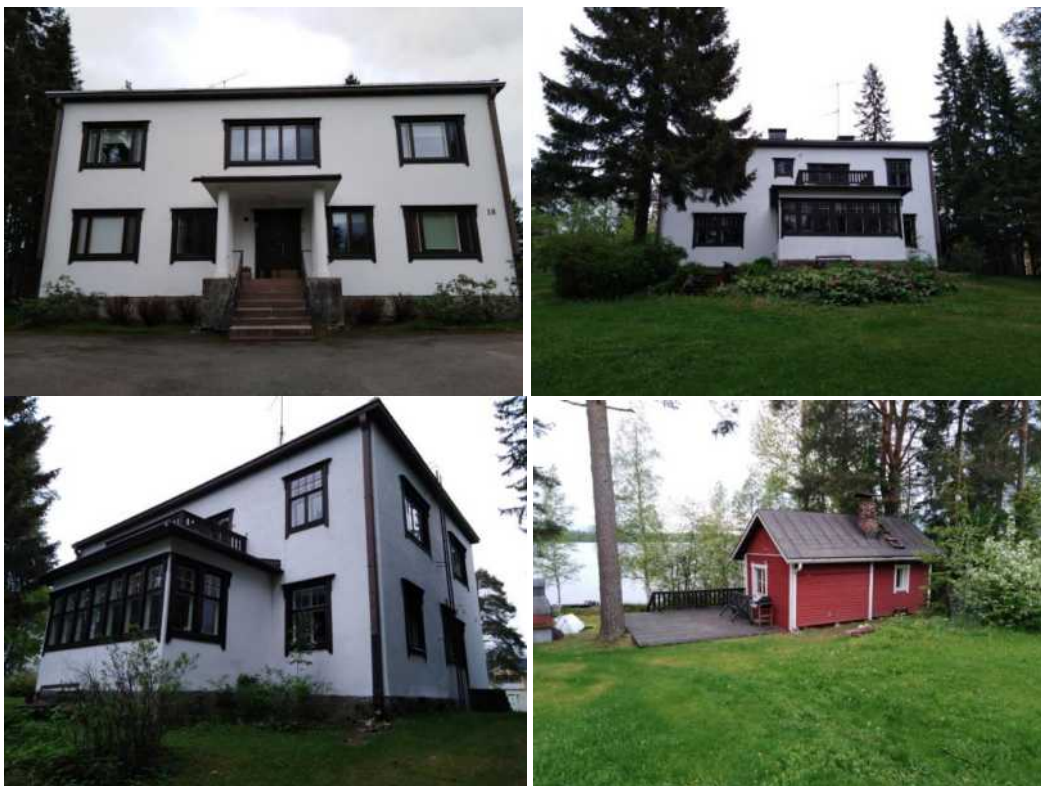
Kuva 12. Yksityiskäytössä oleva asuinrakennus ja sen piharakennus osoitteessa Tahintie 18.
