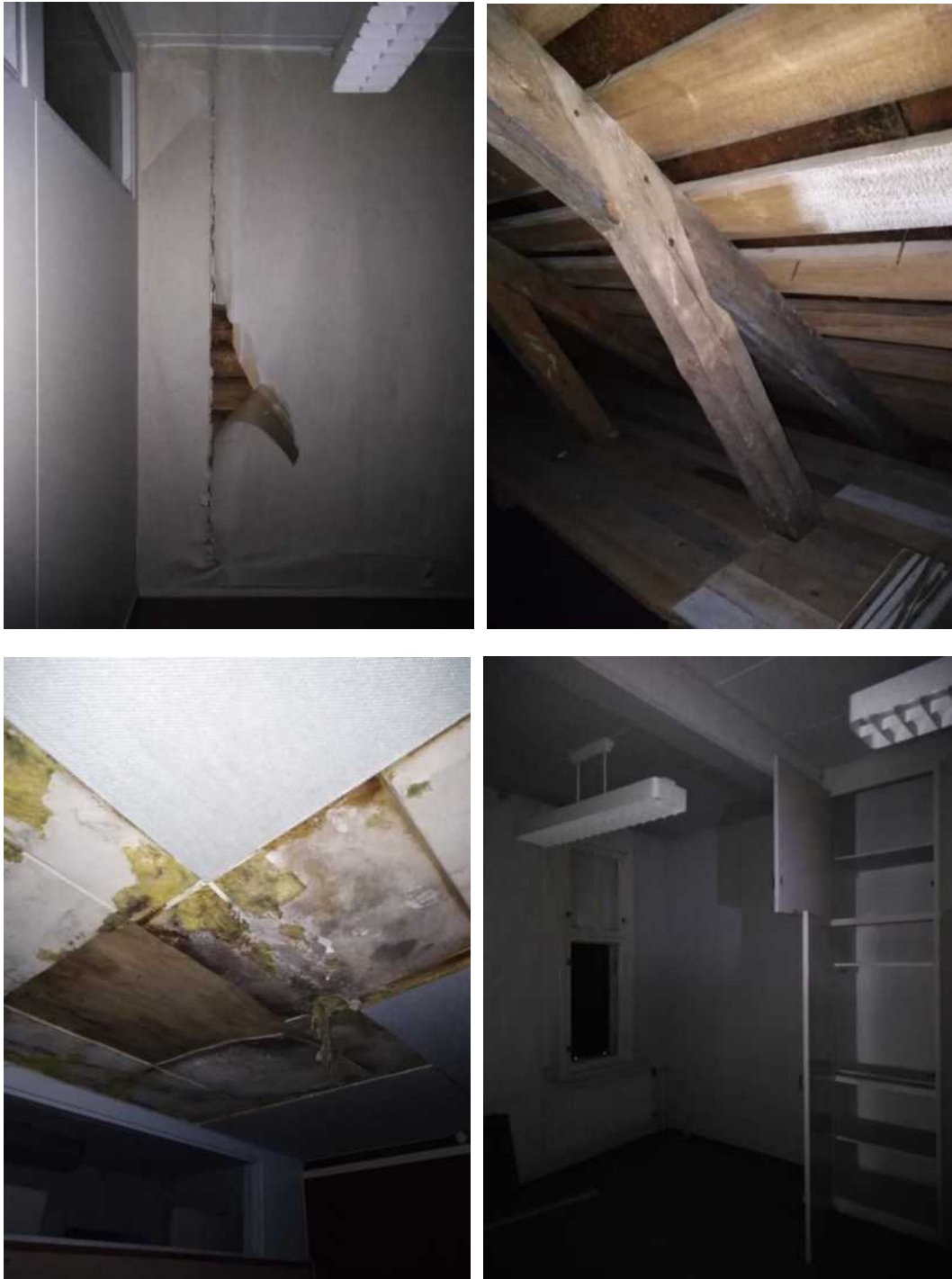
Kuva 33. Sisätilojen rakenteita, kosketusvaurioita ja kiinteitä kalusteita.
