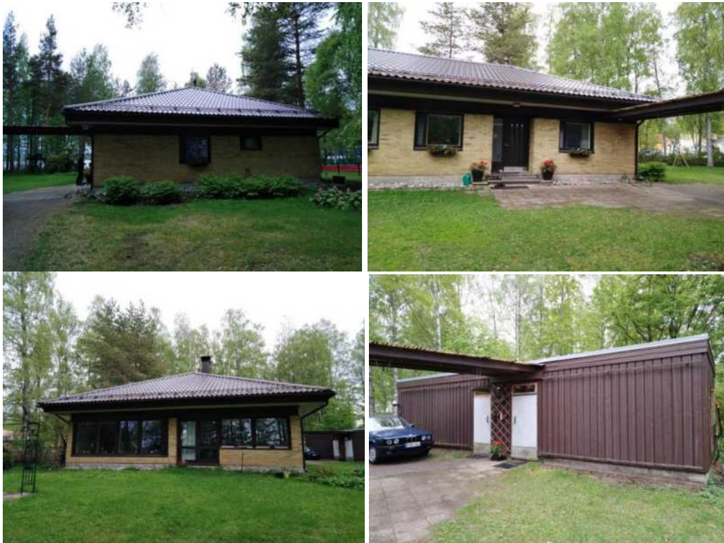
Kuva 20. Yksityiskäytössä oleva asuinrakennus ja sen piharakennus osoitteessa Tahintie 34.
