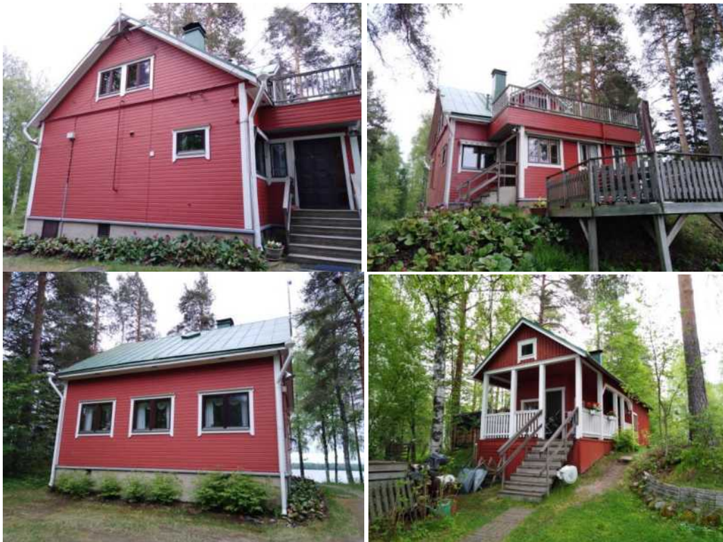
Kuva 19. Yksityiskäytössä oleva asuinrakennus ja sen piharakennus osoitteessa Tahintie 32.
