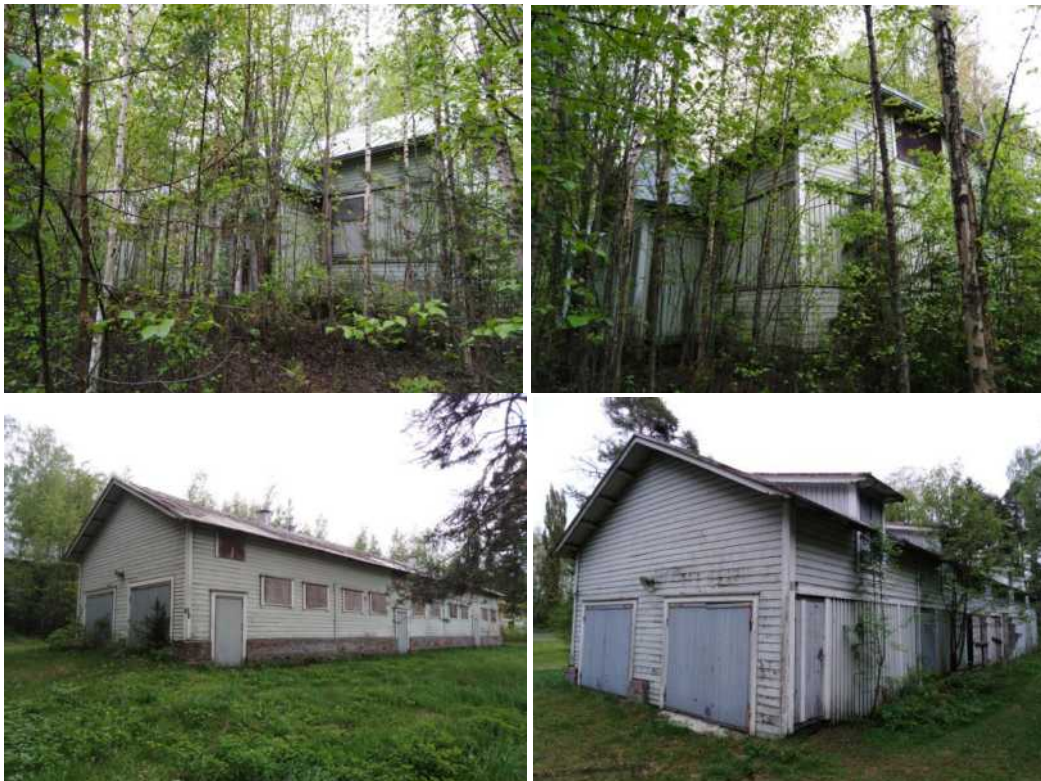
Kuva 8. Suojelutarveselvitetävät ratapiirin toimistorakennus ja sen talousrakennus.
