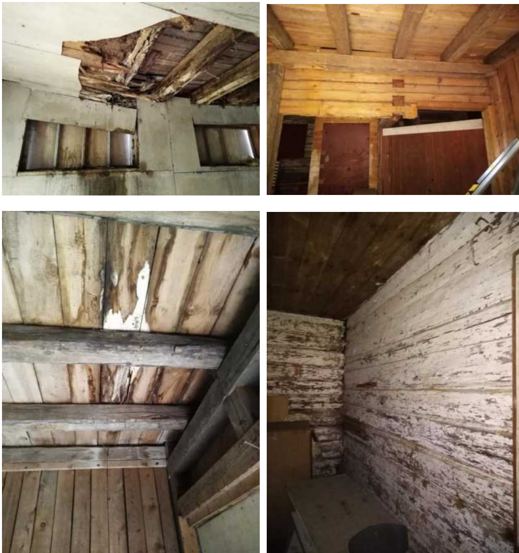
Kuva 37. Sisätilojen kosteusvaurioita ja rakenteita.
