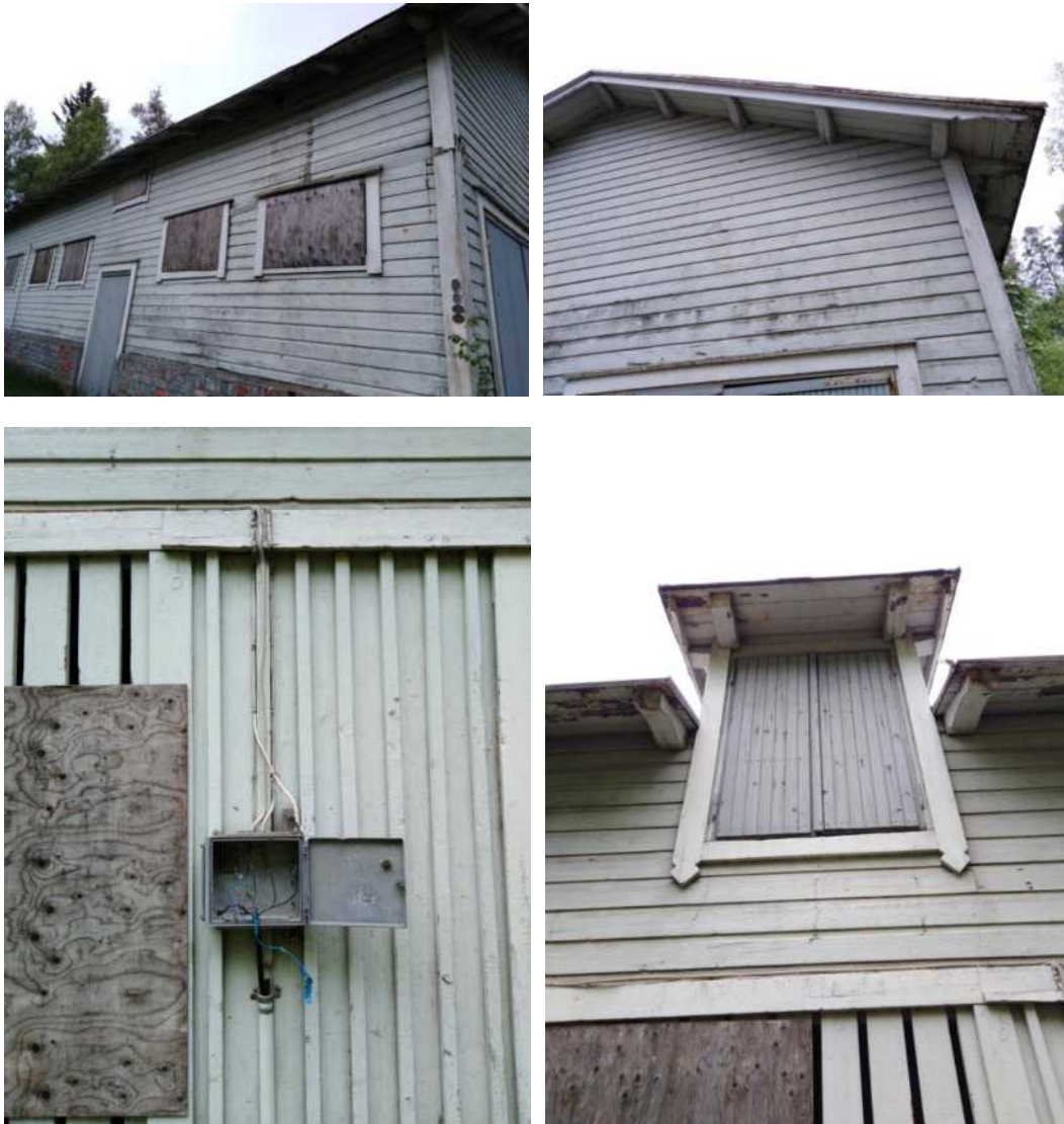
Kuva 36. Julkisivudetaljeja kosteusvaurioista, vesikaton rakenteista, julkisivuverhoilusta sekä luukuista ja ikkunoista.
