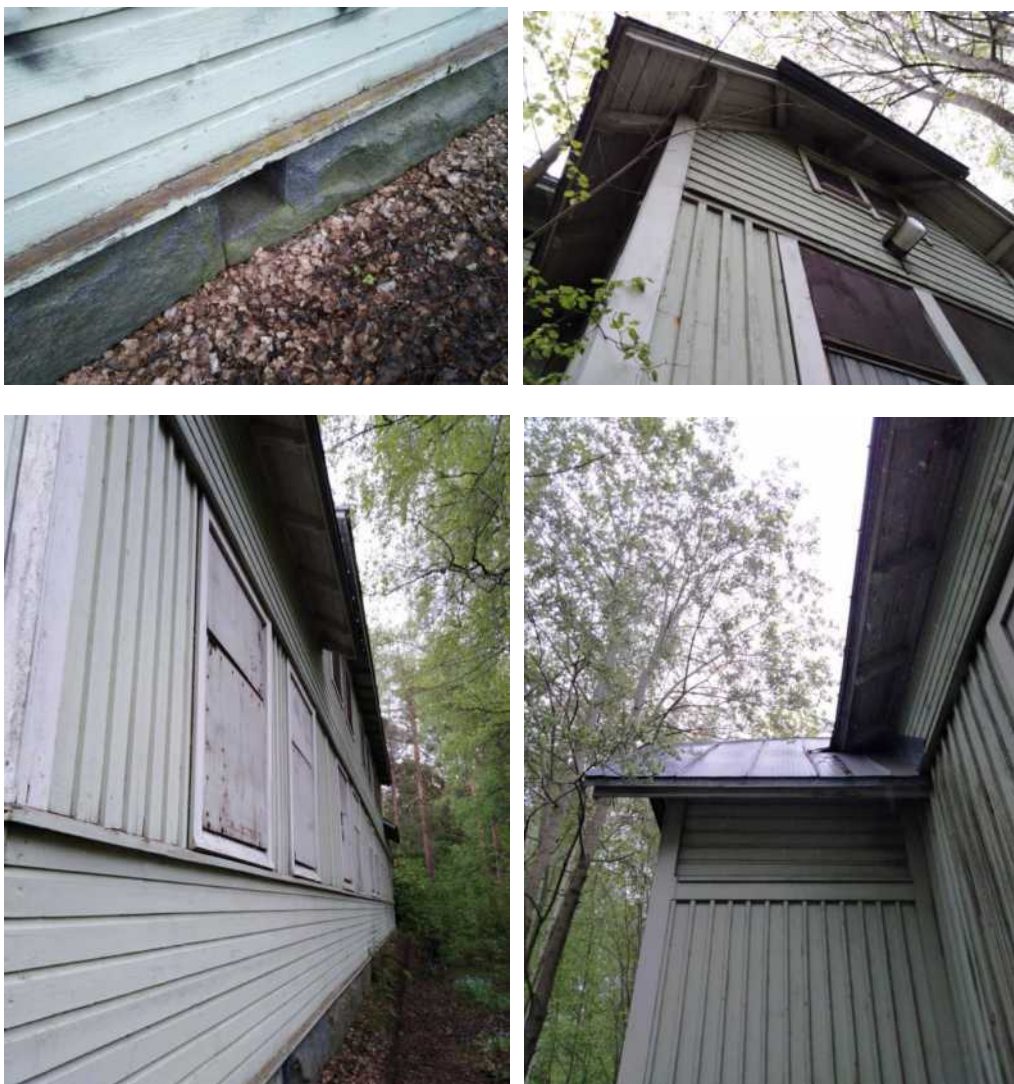
Kuva 32. Julkisivudetaljeja perustuksesta, laudoituksesta, ikkunoista sekä vesikatosta.
