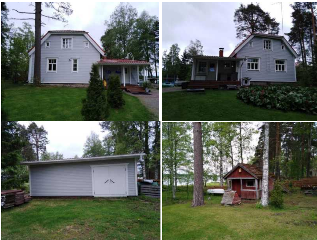
Kuva 16. Yksityiskäytössä oleva asuinrakennus ja sen piharakennukset osoitteessa Tahintie 26.
