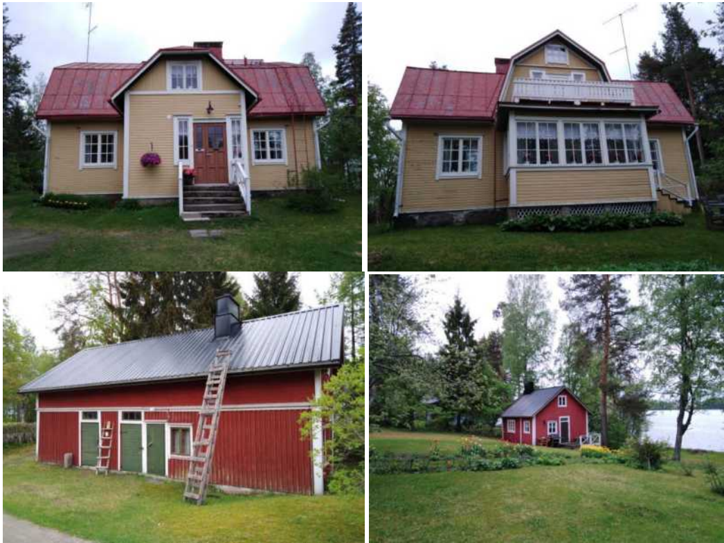
Kuva 14. Yksityiskäytössä oleva asuinrakennus ja sen piharakennukset osoitteessa Tahintie 22.
