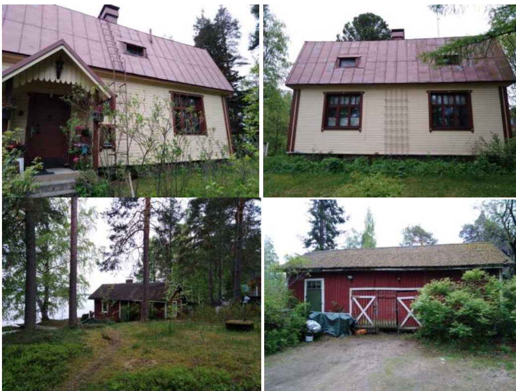
Kuva 18. Yksityiskäytössä oleva asuinrakennus ja sen piharakennukset osoitteessa Tahintie 30.
