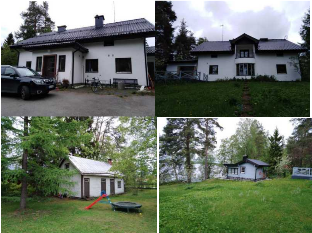
Kuva 13. Yksityiskäytössä oleva asuinrakennus ja sen piharakennukset osoitteessa Tahintie 20.
