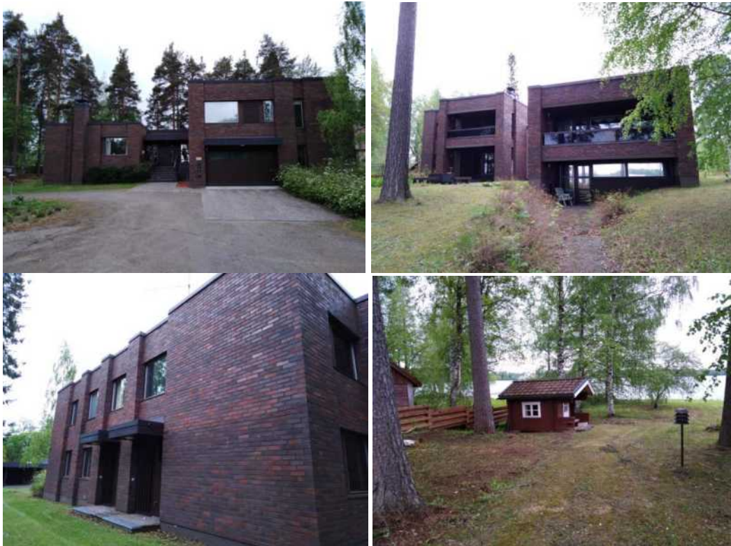
Kuva 17. Yksityiskäytössä oleva asuinrakennus ja sen piharakennus osoitteessa Tahintie 28.
