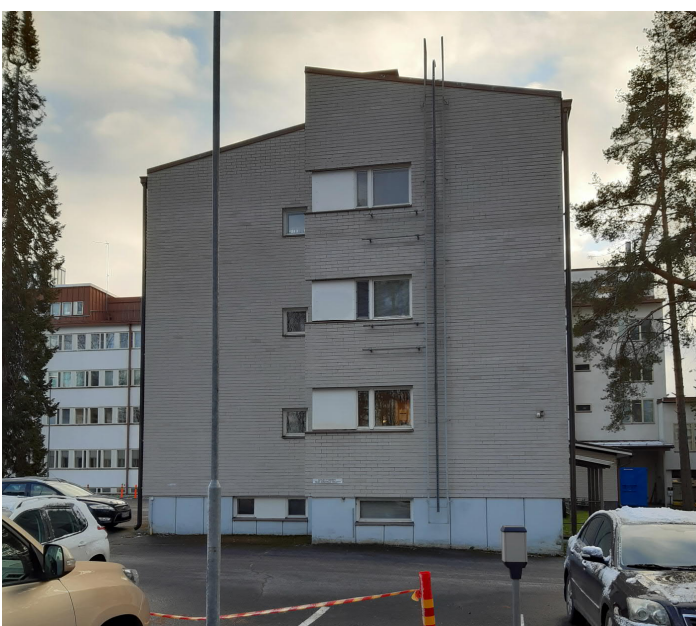
Kuva 27. Aluesairaalan henkilökunnan asuntolan pohjoispääty 2021
