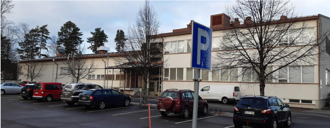
Kuva 20. Aluesairaalan talousrakennuksen kaakkoissivu 2021
