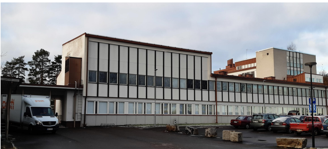
Kuva 14. Aluesairaalan koillissivu (eteläpää) 2021
