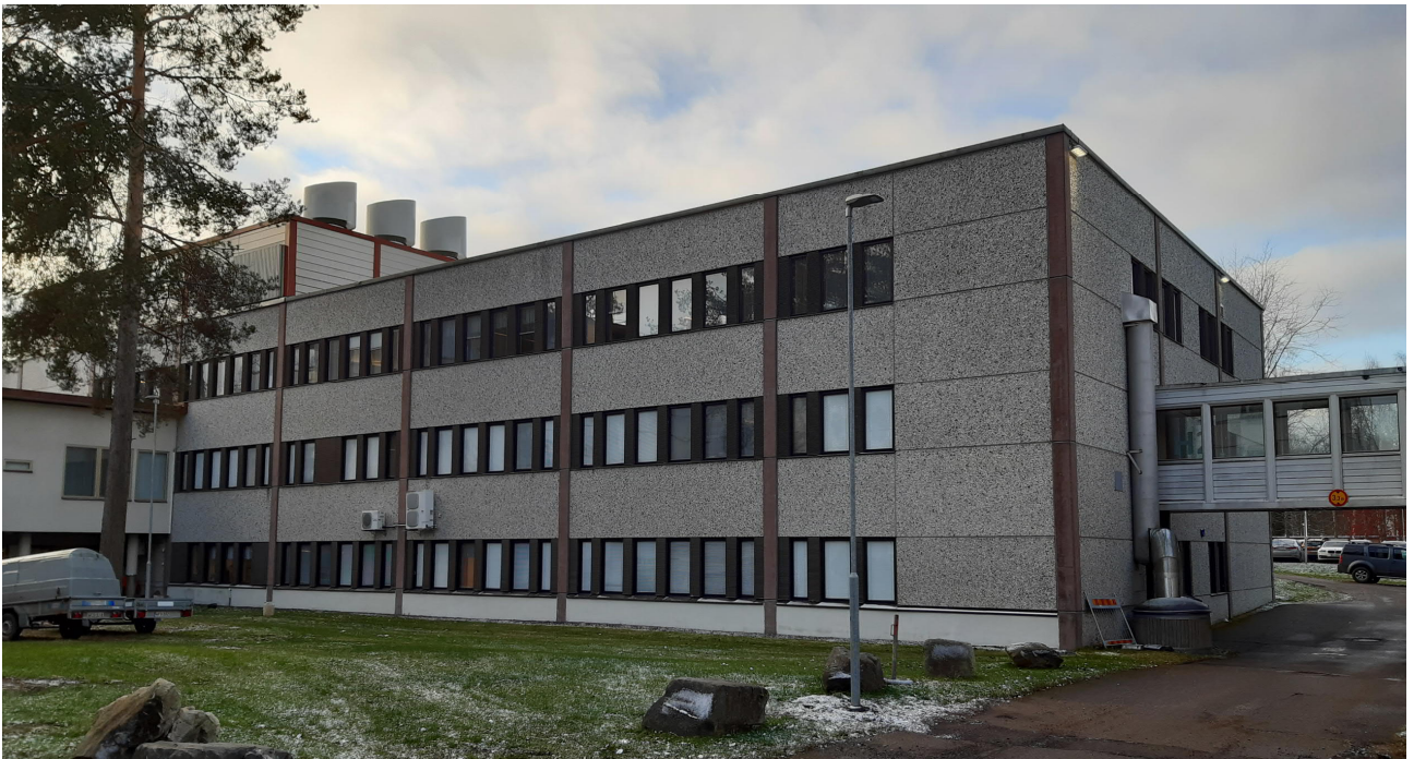
Kuva 35. Pääterveysasema koilliseen (pohjoispääty) 2021
