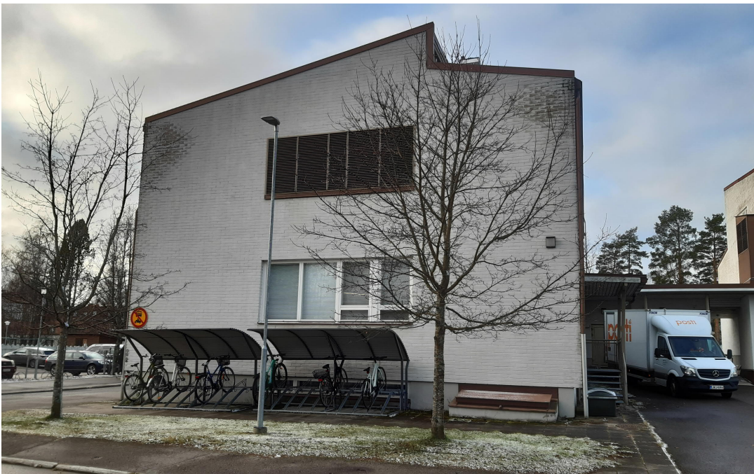
Kuva 21. Aluesairaalan talousrakennuksen itä puoleinen pääty 2021
