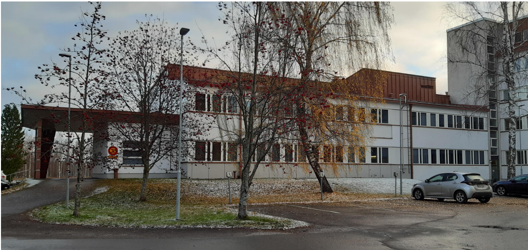
Kuva 15. Aluesairaalan lounaissivu (pohjoispääty) 2021
