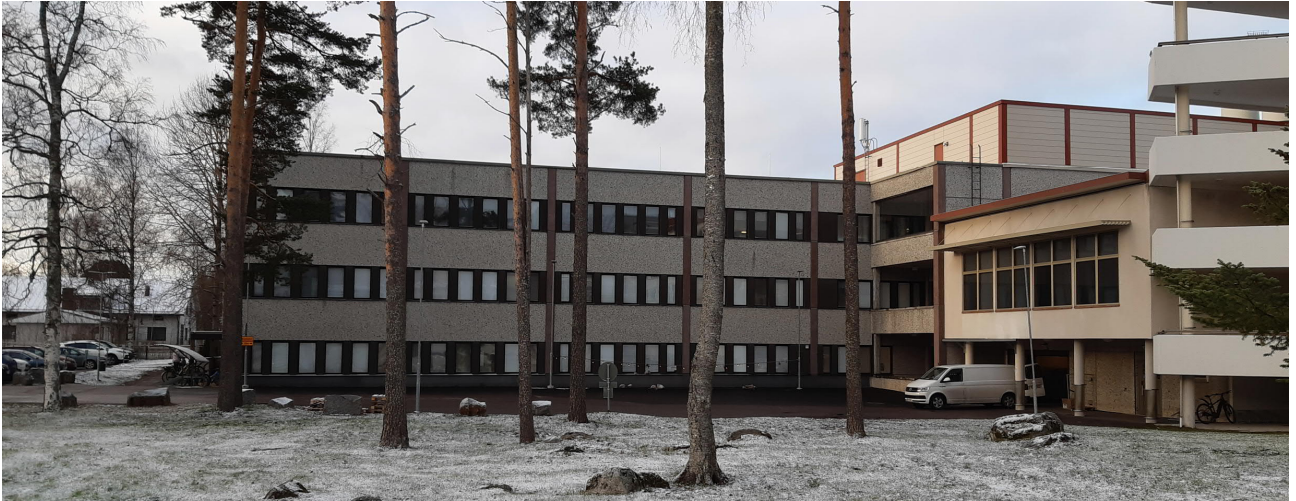
Kuva 34. Pääterveysasema koilliseen (Heinäkatu) 2021
