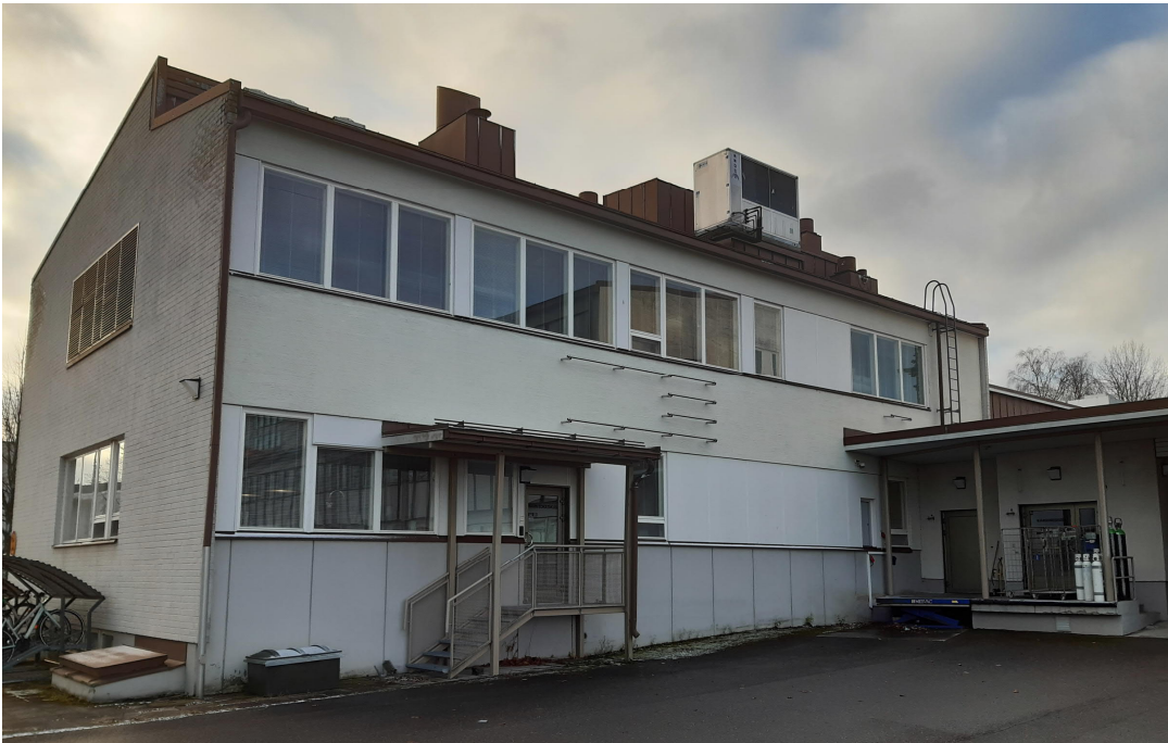
Kuva 23. Aluesairaalan talousrakennuksen luodesivu (Sairaalantie) 2021
