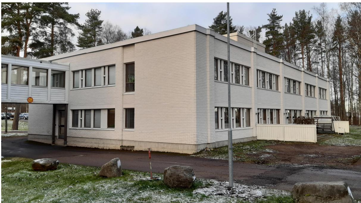
Kuva 38. Mielenterveystoimisto eteläpääty ja koillissivu 2021
