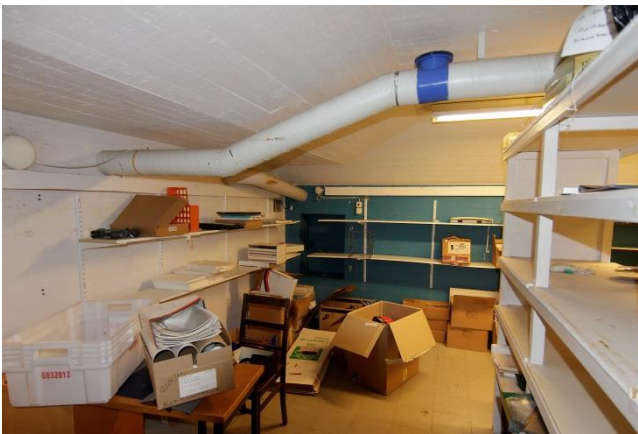
Väestönsuojahuoneita on käytetty varastona. Päätyseinä on maalattu siniseksi.
