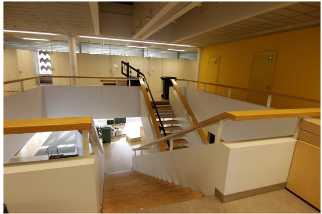
Kaupungintalon pääportaikko. Toisessa porrassuoksussa on myöhemmin rakennettu henkilöhissi, jonka musta kaide rikkoo alkuperäisen yhteisen vaikutelman.
