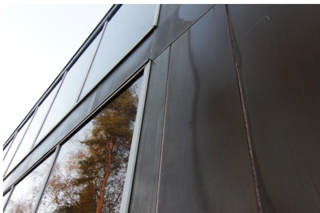
Julkisivun metalliverhoilua päädysä.
