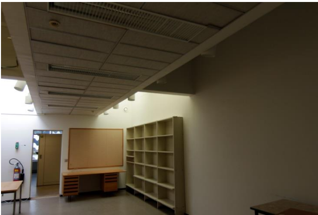
Yläkerroksen länsipään varasali suunniteltu arkistohuone. Osa kattoikkunoista on levytetty piiloon kosteusongelmien takia.
