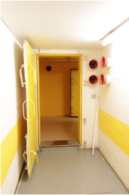
Väestönsuojoiin johtava käytävä. Väestönsuojan ovi on kirkkaankeltainen, ilmanvaihtoputkien päät oransseja.
