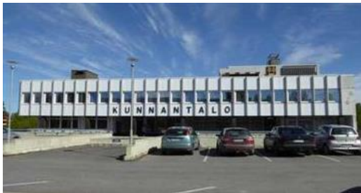
Kuva 1. Mäntyharjun kunnantalo on valmistunut vuonna 1966. Hallinto- ja liikekortteli on heijastuma 60-luvun keskustasuunnittelusta ja aikaa leimanneesta kaupungistumisesta. Kuvälähde Etelä-Savon kulttuuriperintötietokanta, http://www.esku.fi/asp/kohde_det.aspx?KOHDE_ID=22704 .
