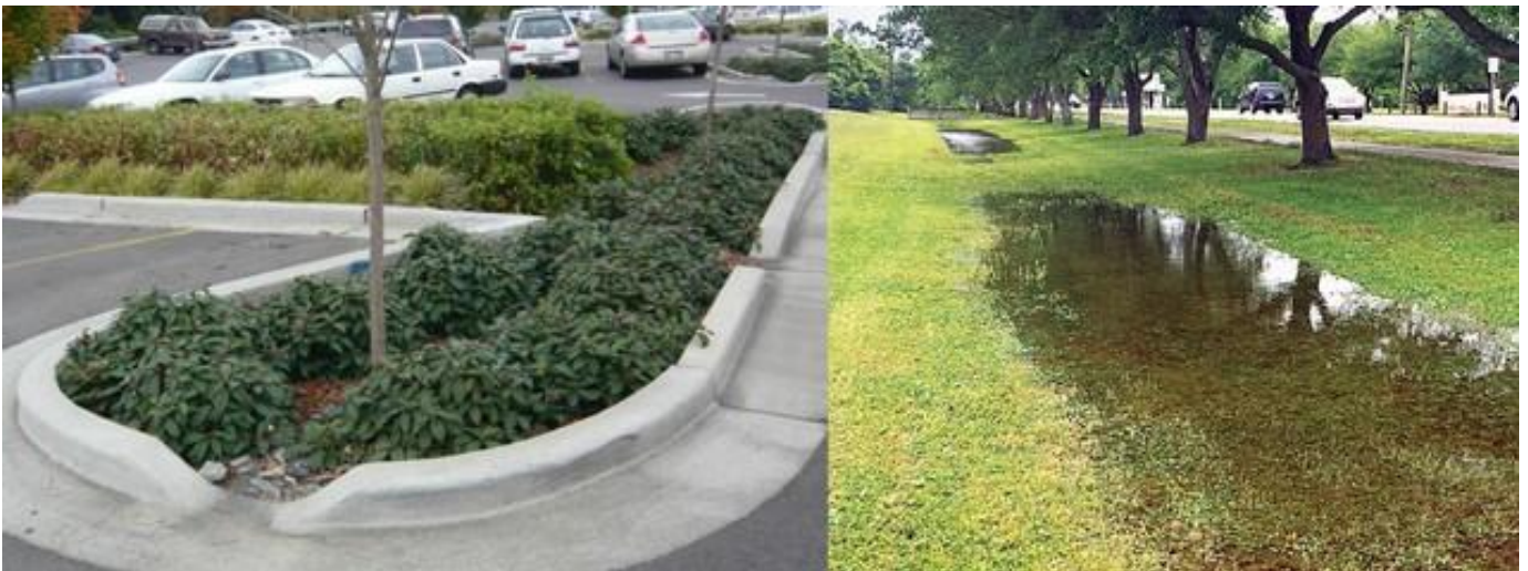
Kuva 7. Hiekanpään pysäköintialueen hulevesiä esitetään viivytettävän oikean puoleisen tapaisella viivytyspainanteella. Hulevesien viivytys on kuitenkin mahdollista myös pysäköintialueen sisällä vasemman kuvan mukaisella rakenteella.
