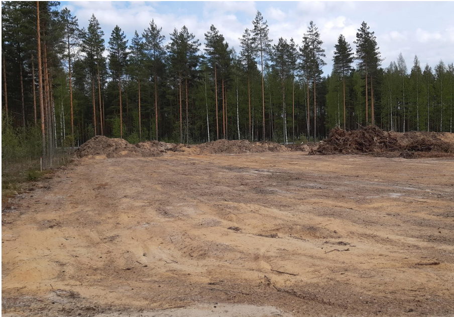
Kuva 2. Pintamaiden poistaminen käynnissä korttelin 409 eteläosassa
