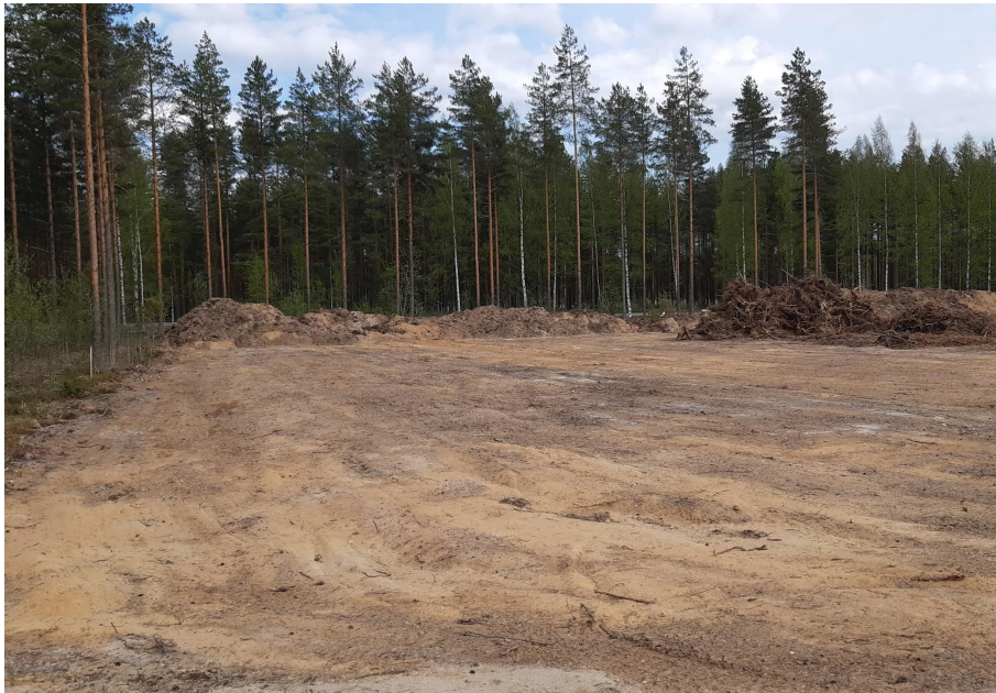
Kuva 2. Pintamaiden poistaminen käynnissä korttelin 409 eteläosassa
