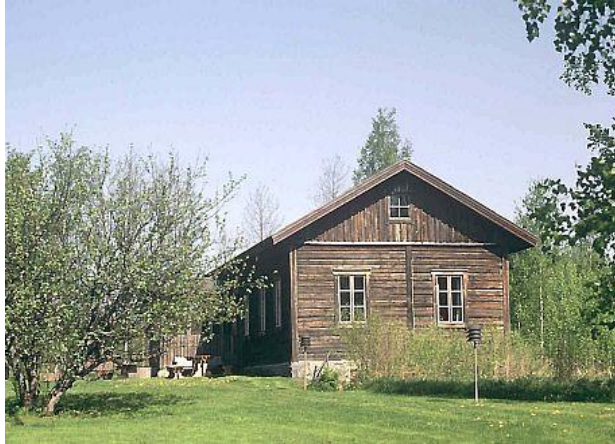
Kuva 18. Mattilan päärakennus. Lähde: Etelä-Savon kulttuuriperintötietokanta.
