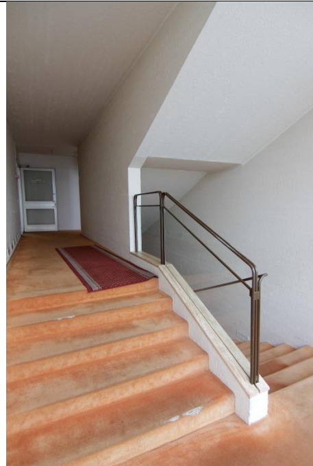
Portaikko uudisosan ja alkuperäisen huoneisto-osan välillä. Kuvassa keskikerros.
