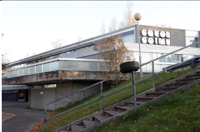
Pääsisäänkäyntiin liittyvä terassi.
