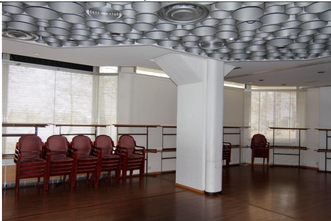
Alkuperäisen huoneisto-osan alle rakennettujen kokoustilojen iso kokoushuone. Alkuperäiset, huoneisto-osaa kannattelevat pilarit on jätetty näkyville. Sisäkatossa on käytetty alumiiniputkia samaan tapaan kuin ruokasalissa.
