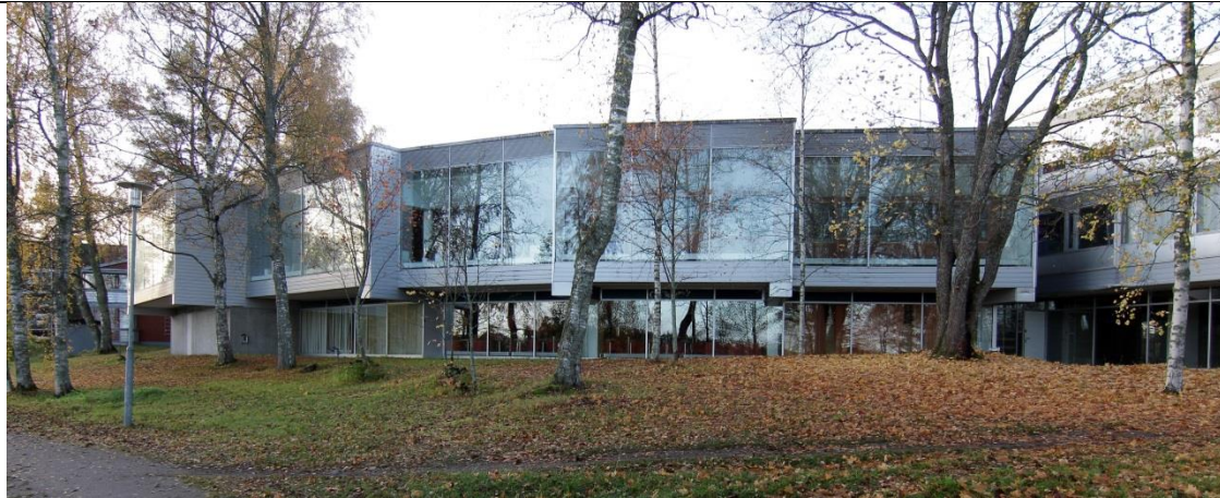
Hotellin ravintola- ja kongressisiiven viuhkamainen muoto hahmottuu parhaiten koillisjulkisivusta Asemanlahden suunnalta.
