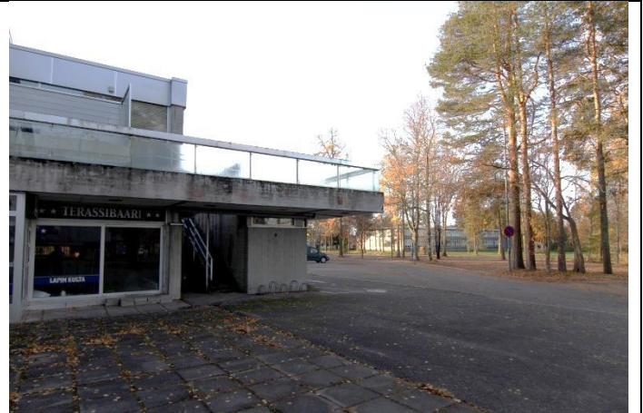
Pääsisäänkäyntiin liittyvän terassin alla on sijainnut allasbaari. Taustalta näkyy kaupungintalo.
