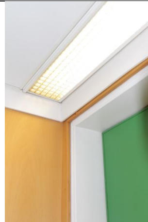
Alkuperäisen huoneisto-osan hotellihuoneiden ovet ovat myös tumman vihreät. Huoneiden eteisen valaistus on upotettu alas laskettuun kattoon.
