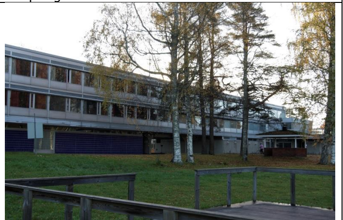
Hotellin edustalla sijaitsee huonokuntoinen tanssilava ja hotellirakennuksen tyyliin sopimaton huvimaja. Kuvassa alkuperäisen huoneisto-osan julkisivu lounaaseen.
