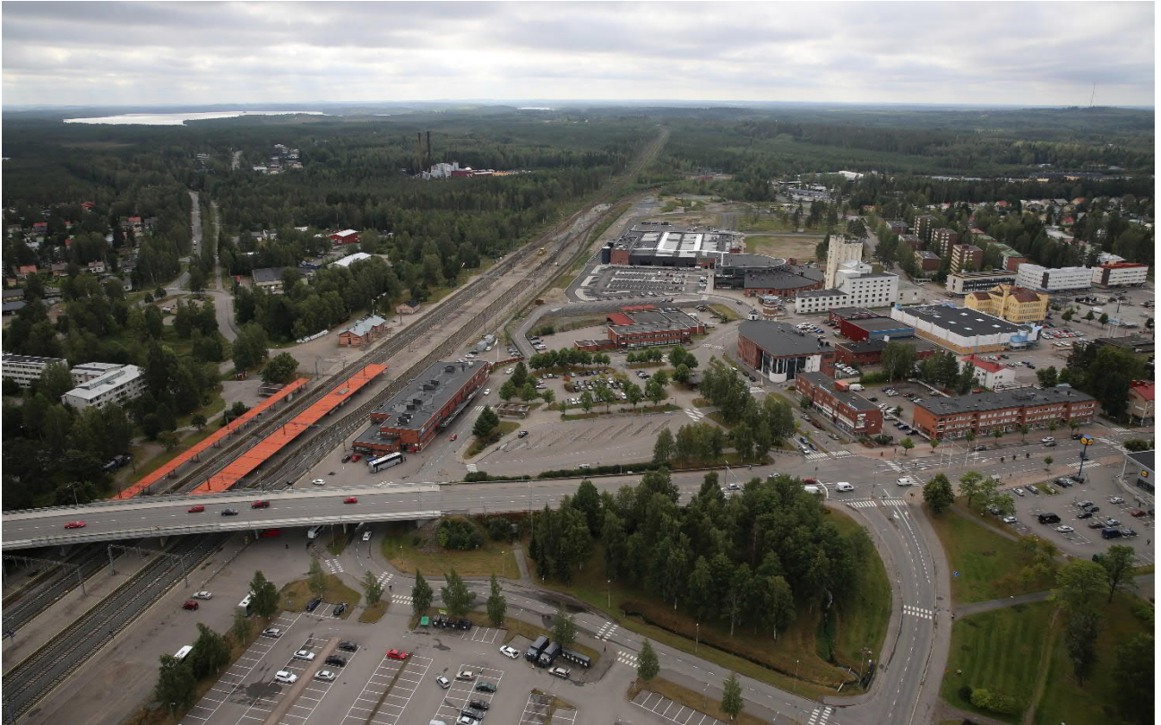
Pieksämäen asema ja Asema-aukio pohjoisesta nähtynä.
