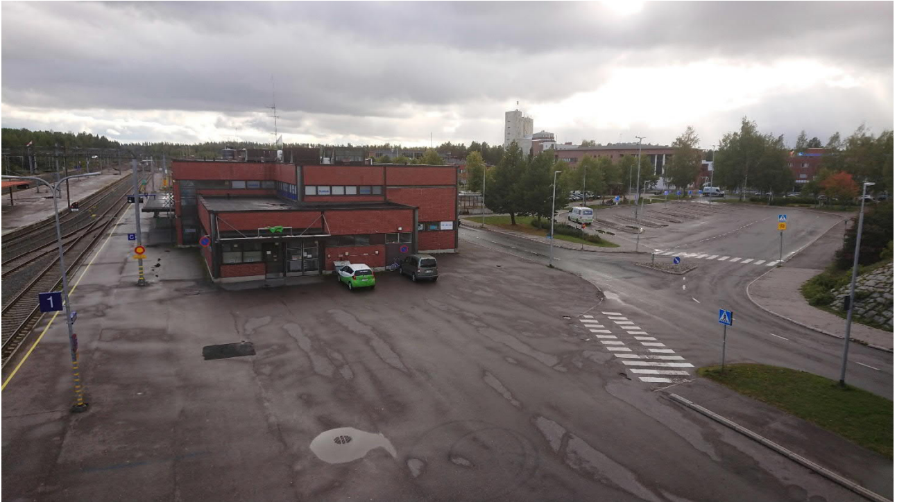
Asema ja asema-aukio pohjoisesta päin. Alue on asfalttikenttämäinen ja jäsentymätön alue.
