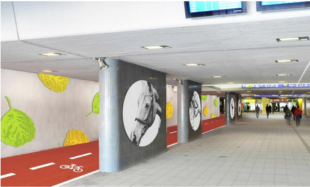
Esimerkki alikulkutunnelista, joka on leveä ja jossa on pilareilla erotettu pyöräkaista ja vaalea väreillä ja kuvilla jäsennetty. Espoon Leppävaaran Leppätunneli. Suunnittelu WSP.
