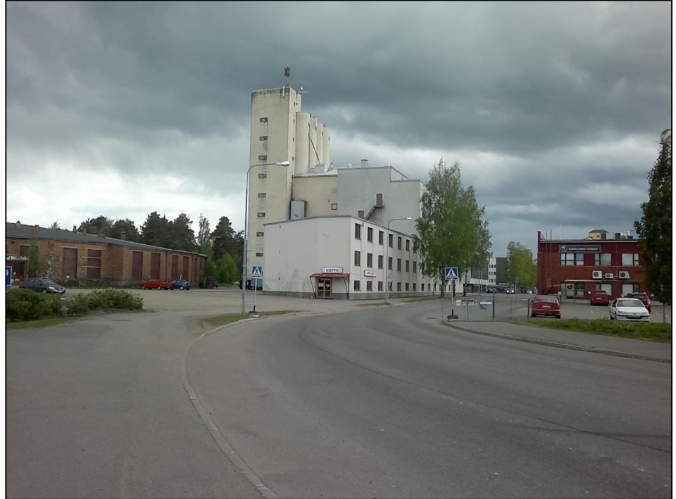
Kuva 5. Myllykatu Vanhan varikkoalueen kohdalla.
