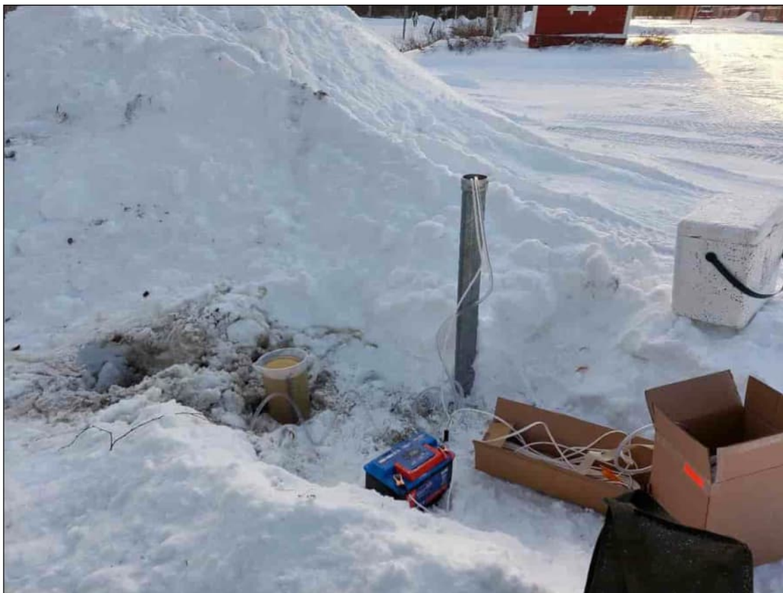
Kuva 9. Pohjaveden havaintoputken PVP2 huuhtelupumppaus käynnissä.
