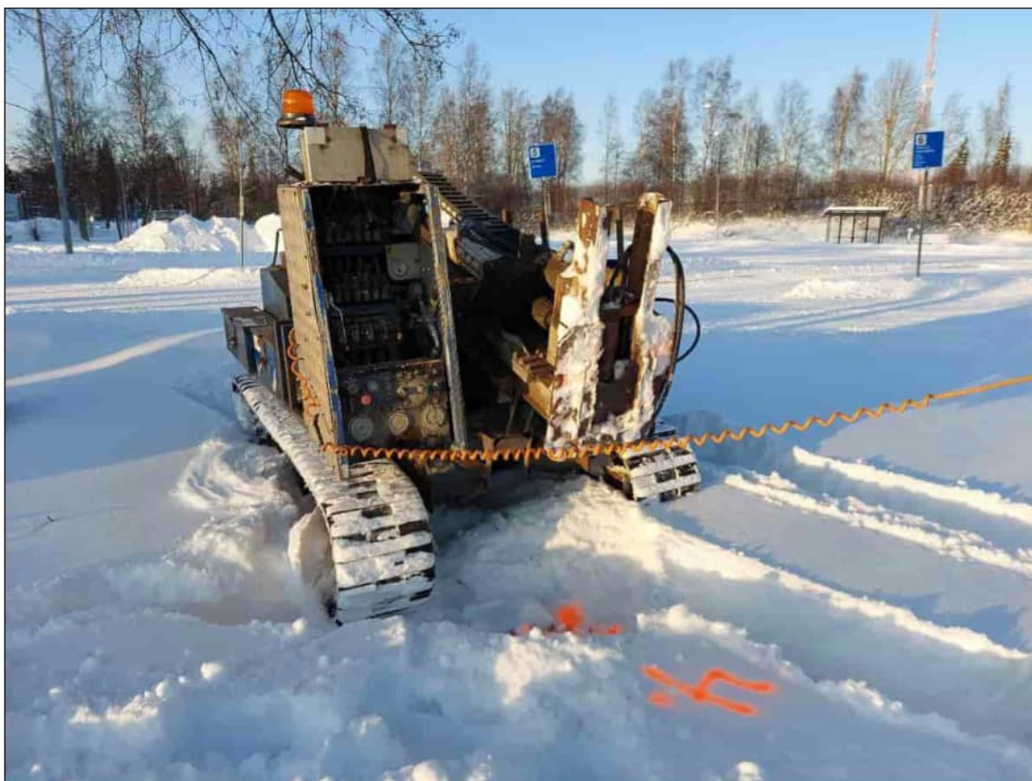
Kuva 4. Kaira näytepisteellä SE2 (geotutkimuksien näytepiste Pt4).
