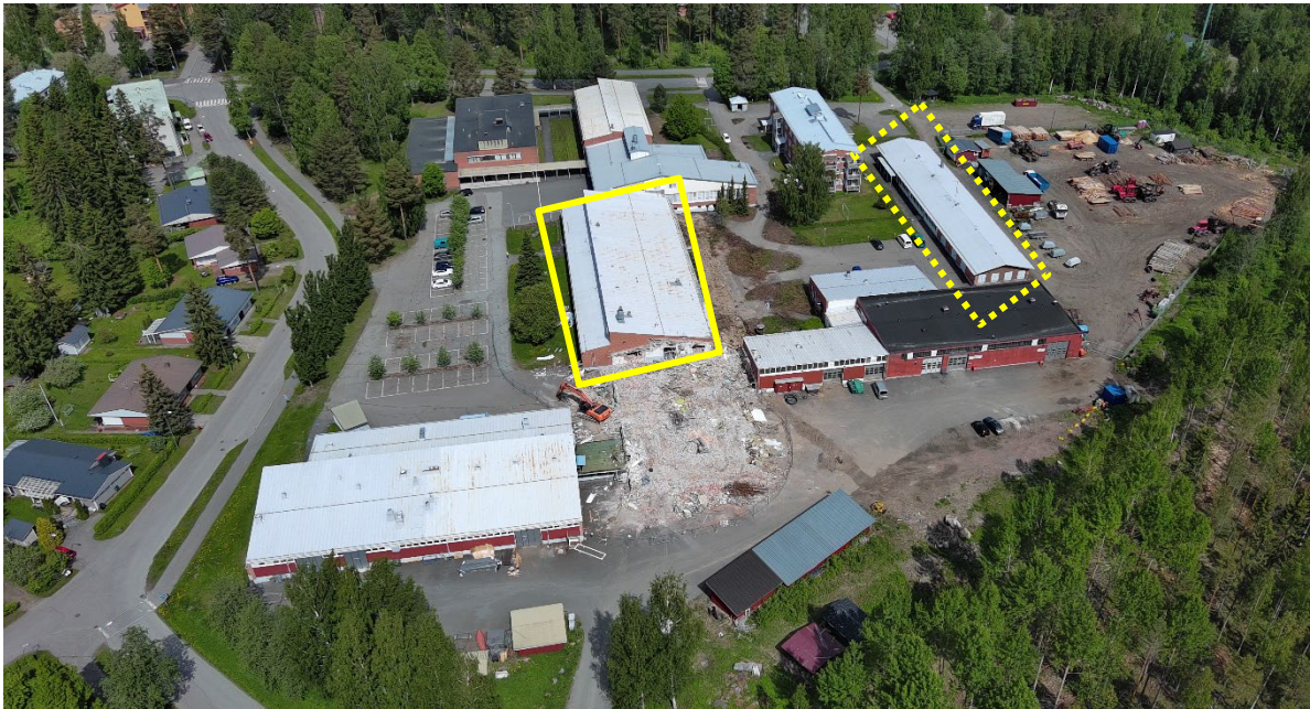
Kuva 2. Suunnittelualueen rakennuskantaa. Alueen rakennuksia on purettu. Keltaisella merkitty rakennus on purettu niin, että siitä on jäljellä kellari (tilanne maaliskuussa 2023) ja keltaisella katkoviivalla merkitty rakennus tullaan purkamaan (viistoilmakuva 2022).
