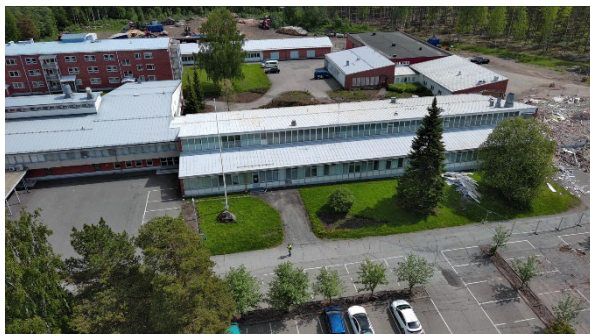
Kuva 6. Rakennuksia alueen keskiosassa. Pitkä rakennusmassa on kellarialueita lukuun ottamatta purettu.
