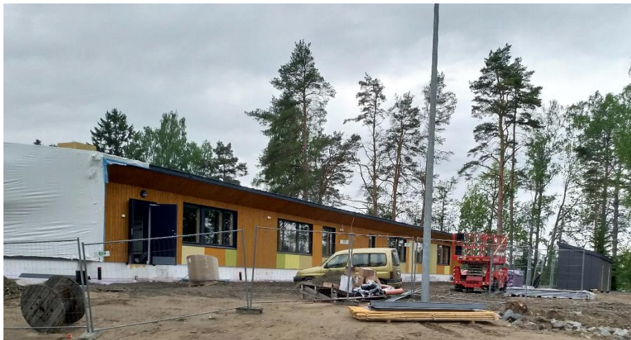
Kuva 5. Suunnittelualueen rakennuskantaa, rakenteilla oleva uusi koulu- ja päiväkotirakennus
