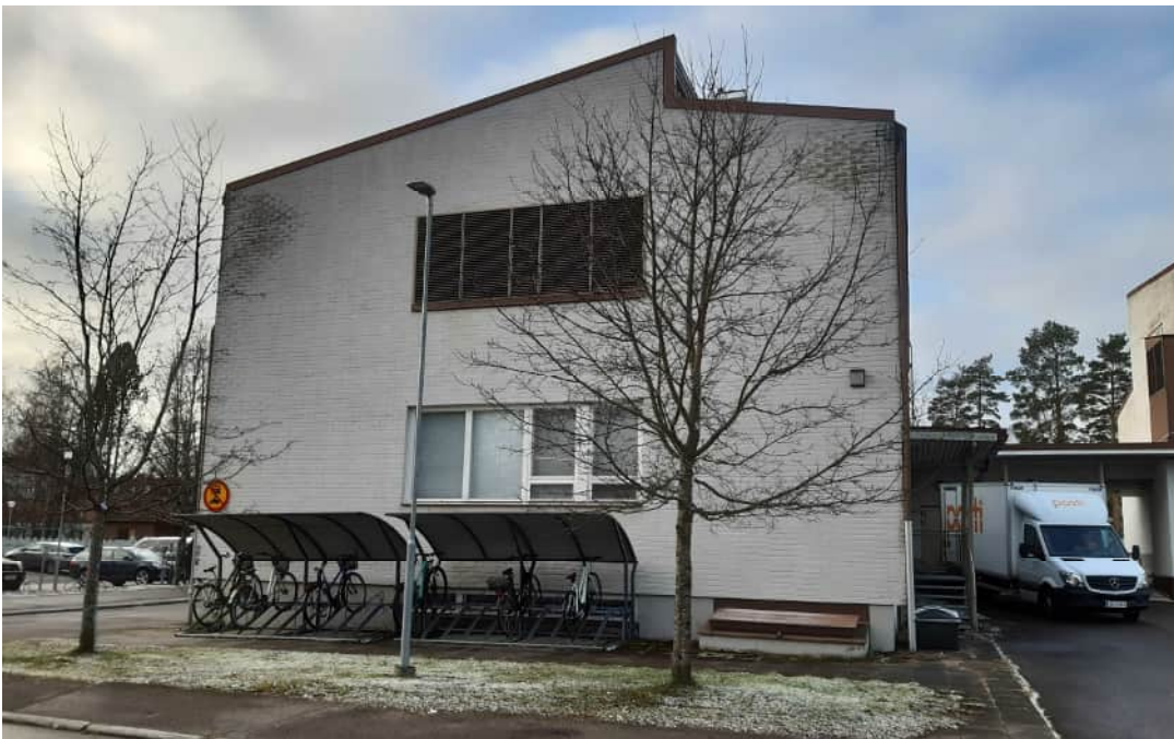
Kuva 21. Aluesairaalan talousrakennuksen itä puoleinen pääty 2021
