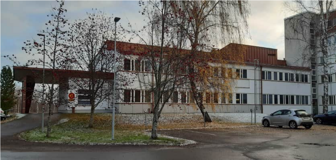
Kuva 15. Aluesairaalan lounaissivu (pohjoispääty) 2021
