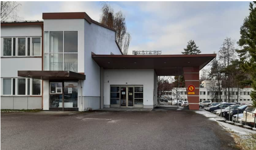
Kuva 13. Aluesairaalan pohjoispääty, ensiapu 2021
