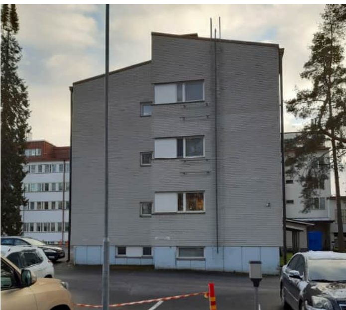
Kuva 27. Aluesairaalan henkilökunnan asuntolan pohjoispäätä 2021
