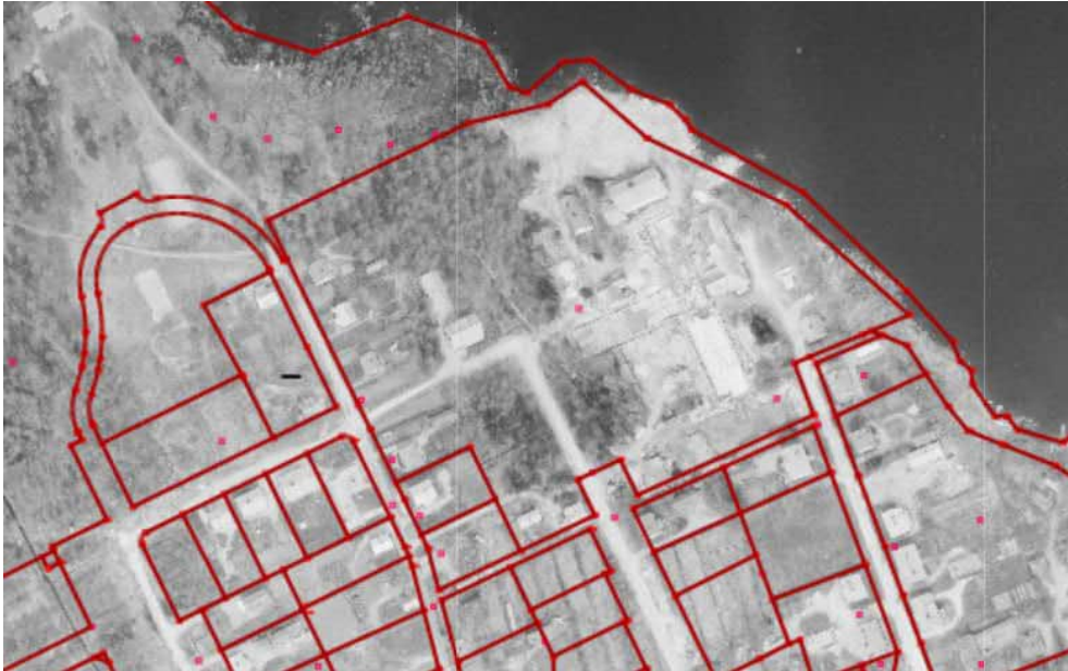
Kuva 30. Ilmakuva vuodelta 1962. Uuden sairaalan rakennustyöt ovat käynnistyneet Sairaalantien puoleisessa osassa tonttia. Vanha kulkutautisairaala ja synnytysosasto ovat jo purettuina ja vanhan vesialueen täyttö on aloitettu
