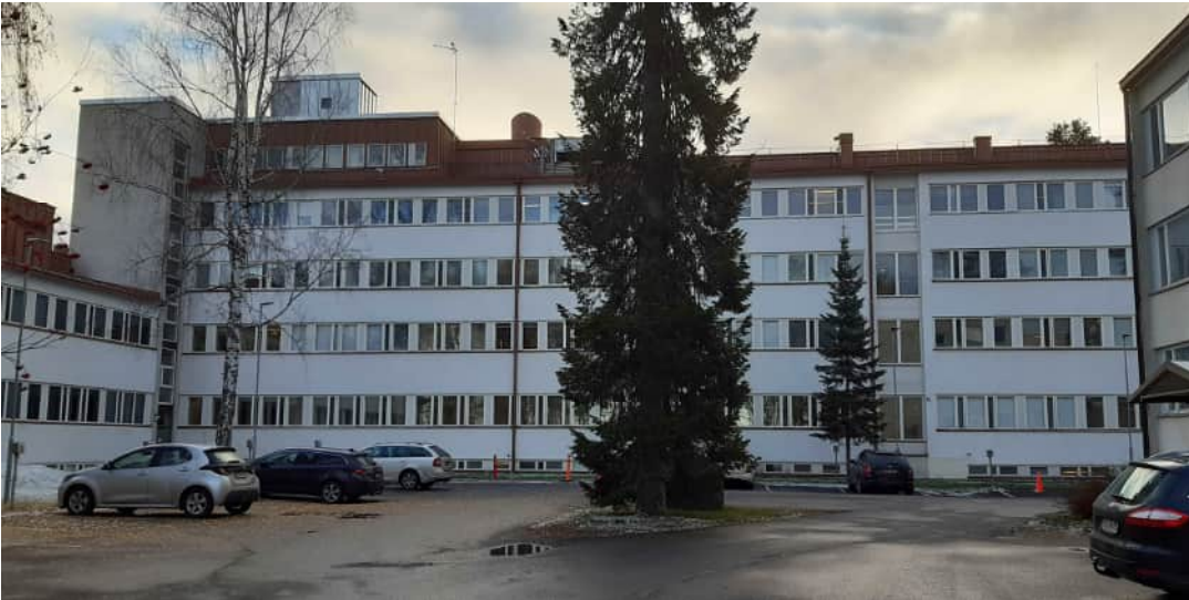
Kuva 16. Aluesairaalan korkea osa sisäpihalta kuvattuna 2021
