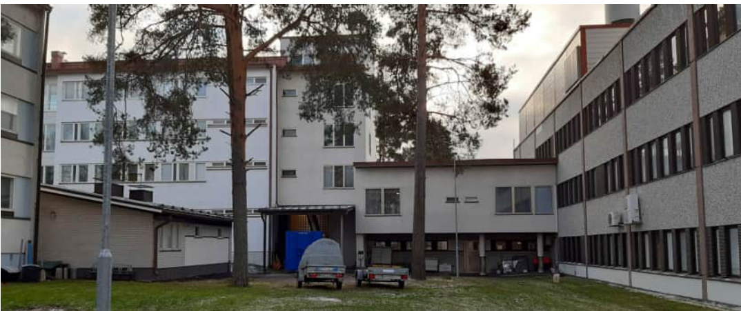
Kuva 17. Aluesairaalan ja terveyskeskuksen liittymäkohta sisäpihalta kuvattuna 2021
