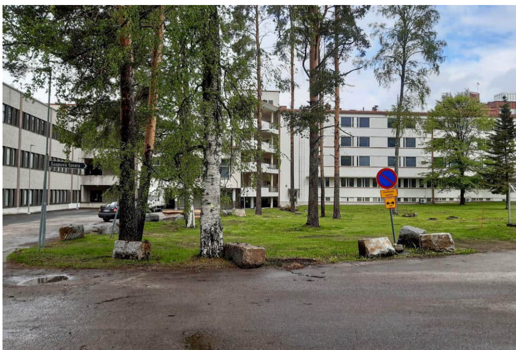
Kuva 5. Piha-alueet, joita ei käytetä liikennöintiin, ovat nurmetettuja (6/2021)
