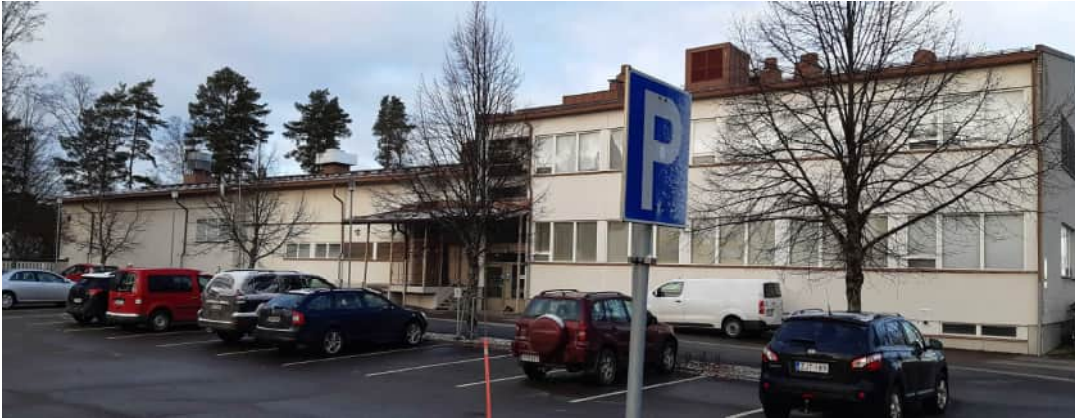
Kuva 20. Aluesairaalan talousrakennuksen kaakkoissivu 2021
