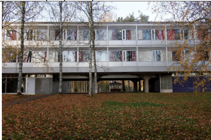
Alkuperäisen huoneisto-osan julkisivu koilliseen. Vasemmalla uima-allasosasto, oikealla laajennuksen yhteydessä rakennettuja kokoustiloja, joiden takia rakennus ei enää hahmotu pilarien päällä leijuvana.
