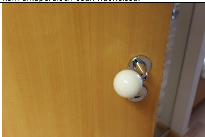
Uudisosan hotellihuoneiden kylpyhuoneiden ovet ovat puuta. Kahvat ovat samaa mallia kuin alkuperäisissä huoneissa, mutta väriltään valkoisia.
