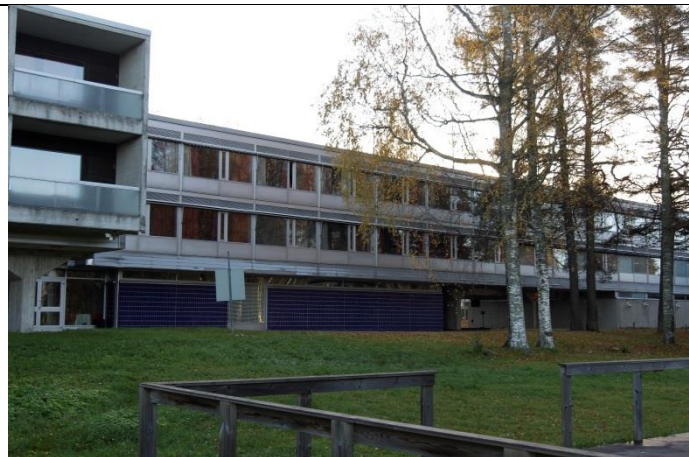
Alkuperäinen hotellihuoneet käsittänyt osa on alkujaan ollut pilarien päällä ja maisema on jatkunut rakennuksen ali. Laajennuksen yhteydessä huoneisto-osan alle on rakennettu neuvottelutiloja ja alkuperäinen vaikutelma keveästä, ilmassa leijuvasta rakennusosasta on menetetty. Nauhaikkunoilla ja julkisivun alumiini vuorauksella on korostettu rakennusosan keveää ilmettä. Kuvassa julkisivu lounaaseen.
