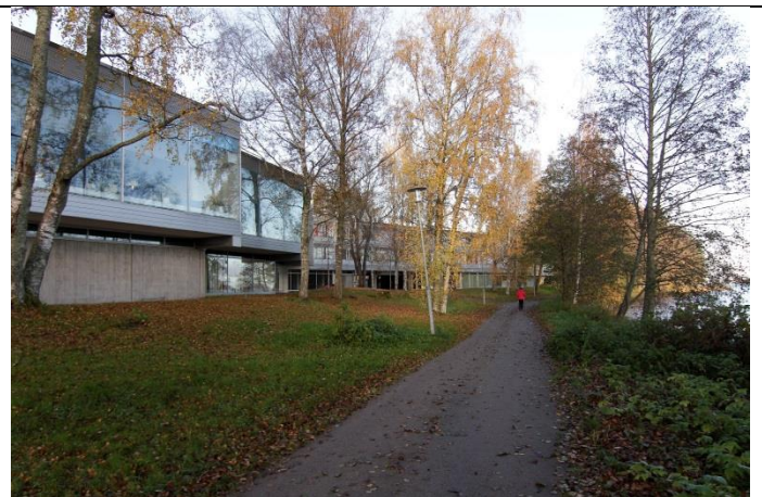
Hotellin koillisjulkisivua. Rannassa on kevyenliikenteen reitti.
