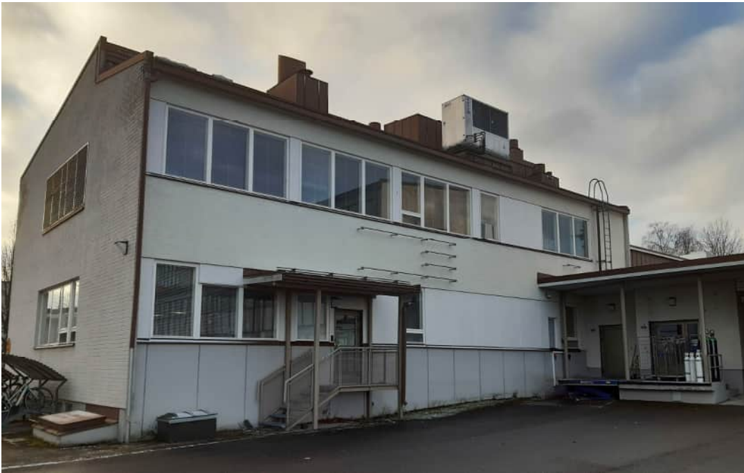
Kuva 23. Aluesairaalan talousrakennuksen luodesivu (Sairaalantie) 2021
