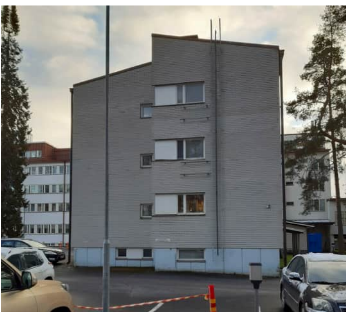
Kuva 27. Aluesairaalan henkilökunnan asuntolan pohjoispääty 2021
