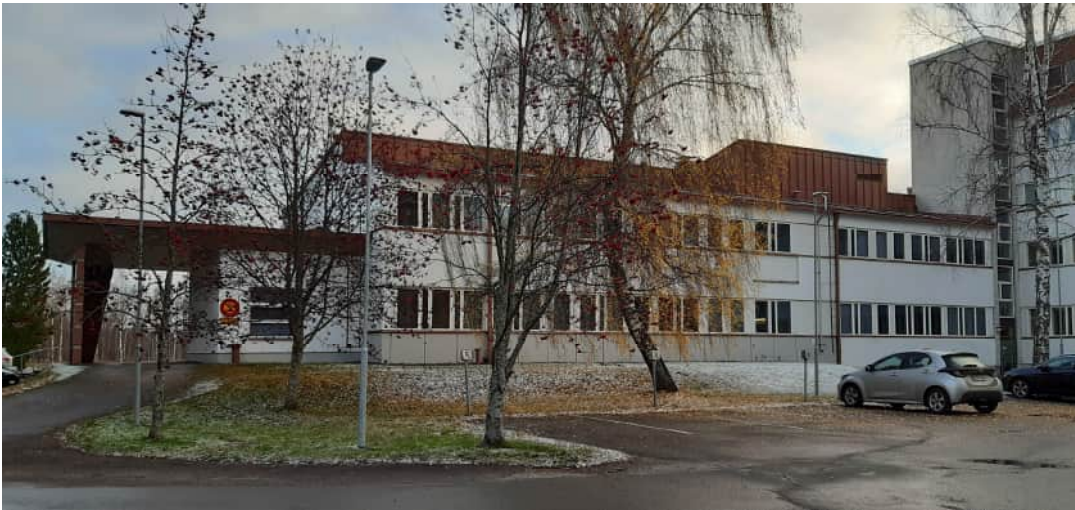
Kuva 15. Aluesairaalan lounaissivu (pohjoispääty) 2021
