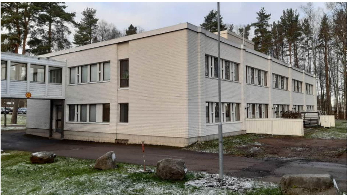
Kuva 38. Mielenterveystoimisto eteläpääty ja koillissivu 2021
