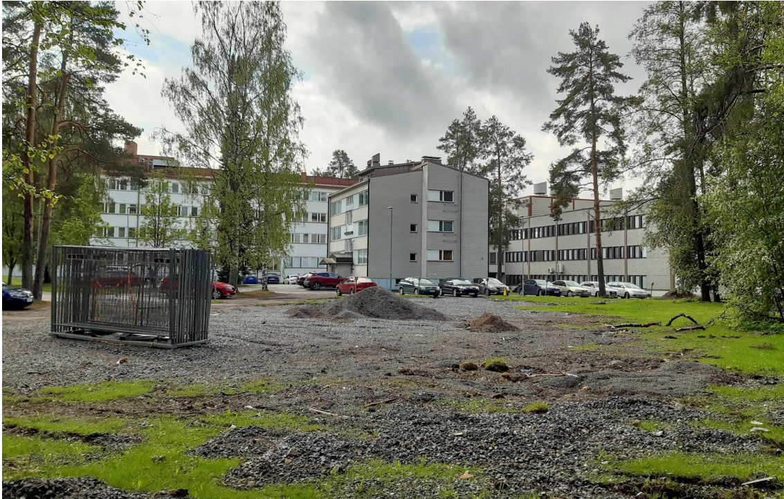
Kuva 3. Suunnittelualueen pohjoisosasta kuvattuna terveystalouden sisäpihalle päin. Tasatun sora-alueen kohdalta on purettu toimistorakennus v. 2020 (6/2021).
