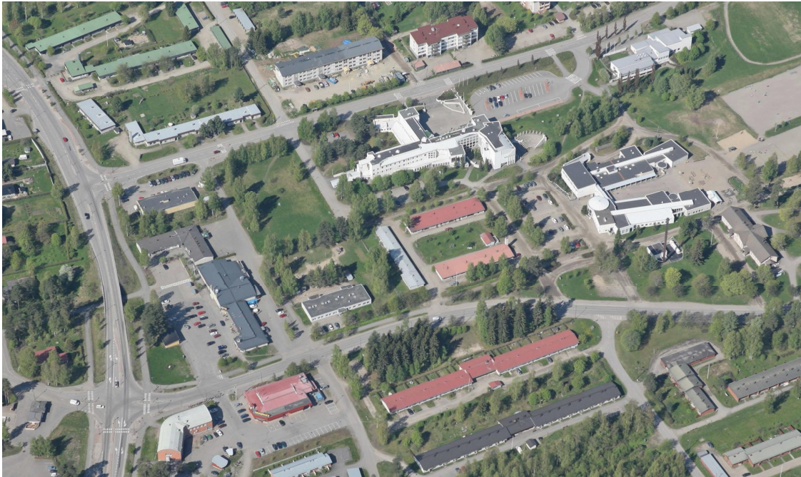
Kuva 2: Yleiskuva suunnittelualueen eteläosasta
