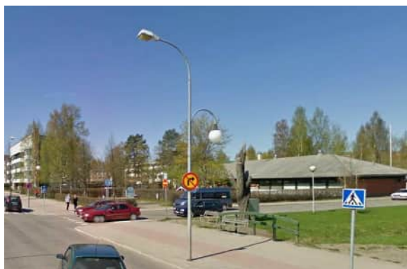
Kalevalan päiväkoti, Kalevalankatu 38
