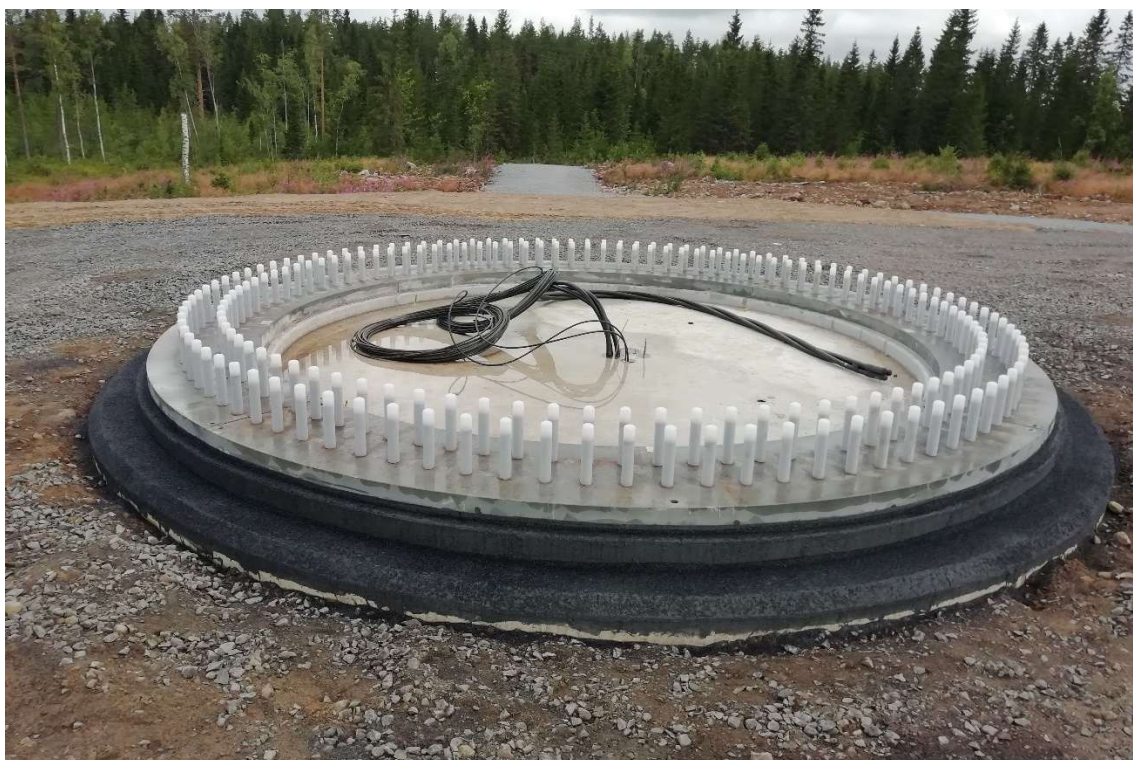
KUVA 41. Toteutettu esimerkki perustuksen maanpäällisestä osasta
