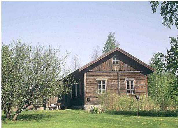
Kuva 17. Mattilan päärakennus. Lähde: Etelä-Savon kulttuuriperintötietokanta.
